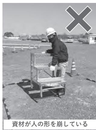
図一4 カメラ方式による従来の安全装置の弱点
