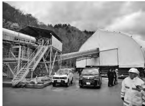
写真二 坑外設備（バルコン、テント）
