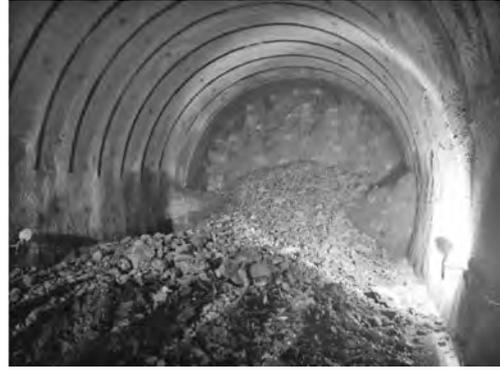
写真一七 発破後の切羽状況
