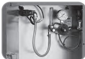
炭酸ガス圧力調整器、
