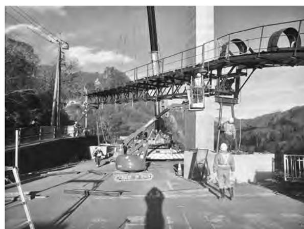
写真一 5 工事用道路部組立状況 (TBC13)
