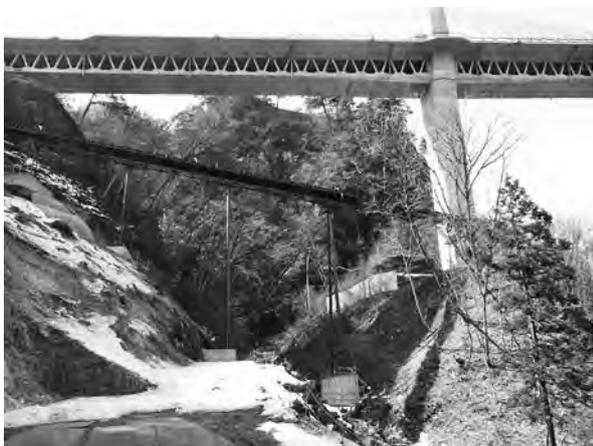
写真一 2 ベルトコンベア設置状況 (TBC10)
