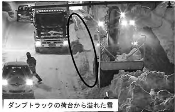
写真一4 運搬排雪の作業ロス状況
