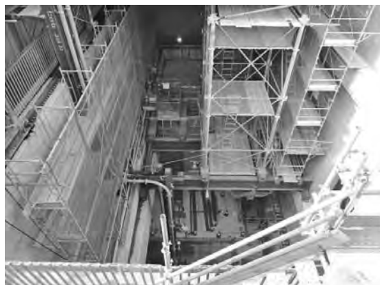
写真—4 接続部立坑 地上から内部の状況
