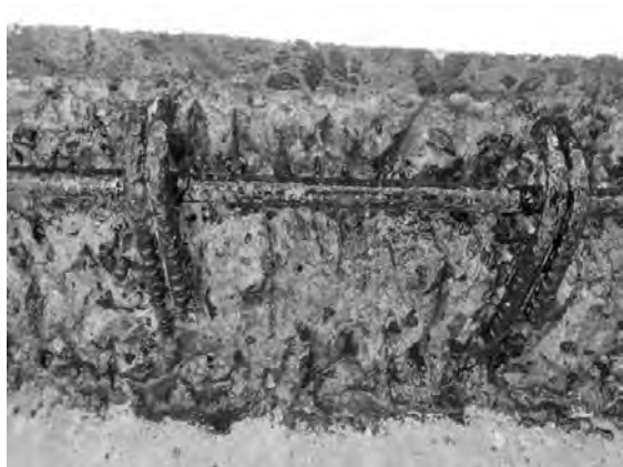
写真一4 HEP20 塗布後の状況
