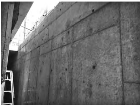
写真一七 本体壁完成後の状況
