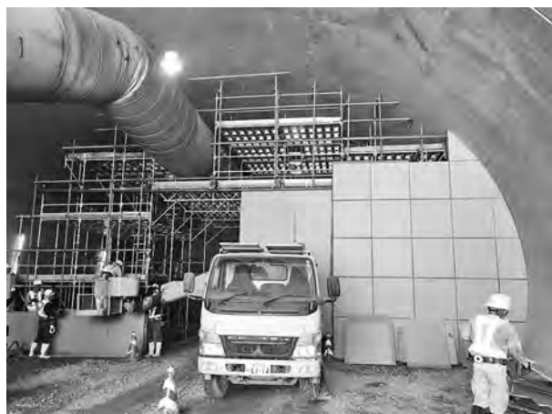
写真ー5 紙素材の風門の組立状況
