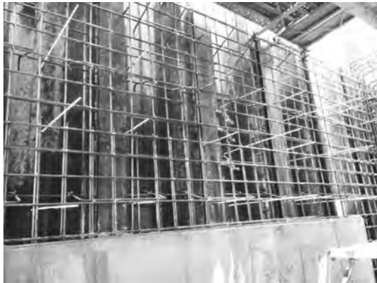
写真一六 本工法による本体壁の配筋状況
