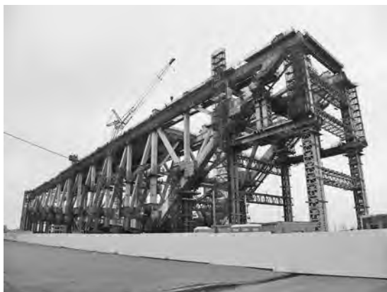
写真一 2 大型トラスの現場溶接による組立の様子
