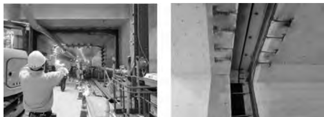
写真—2 左：沈埋函トンネル状況 右：継手部
