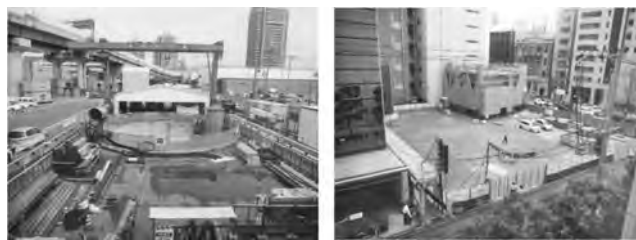
写真—1 事例 1：搬出工事（左）、搬入工事（右）
