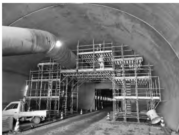
写真—4 紙素材の風門用の支保工設置状況
