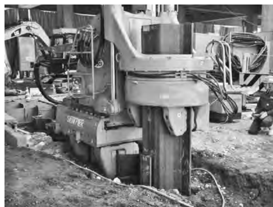
写真—5 合成構造用鋼矢板の打設状況
