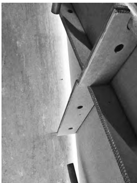
写真一七 紙素材用ネジによる部材同士の接合
