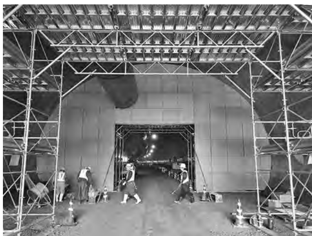
写真一八 紙素材の風門の設置完了状況
