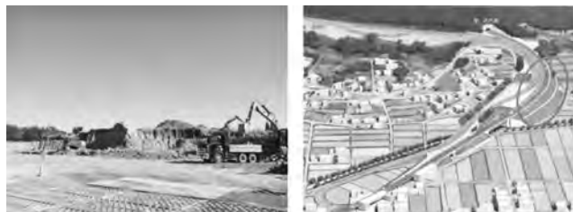
写真—2 事例 2：搬出工事（左）、搬入工事（右）
