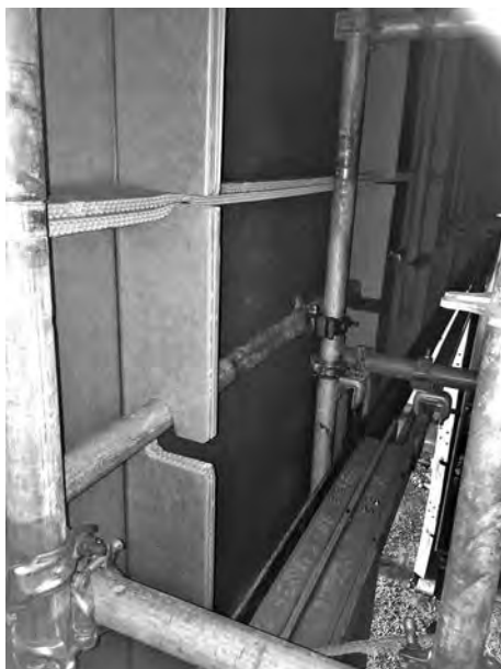
写真一六 L字型の切込みによる支保工への固定状況
