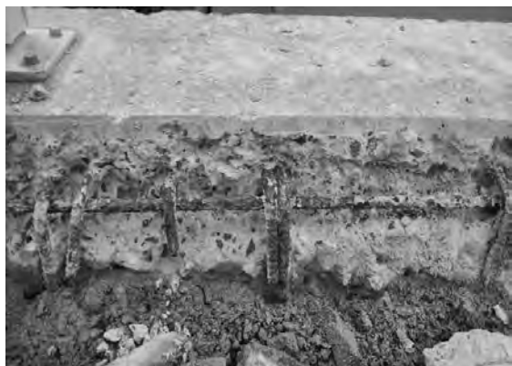
写真一3 はつり取り後の鉄筋状況
