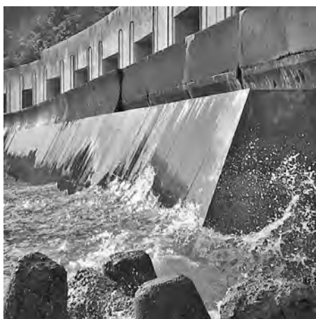
写真—3 鋼繊維補強 PFC 製パネルを用いた補修
