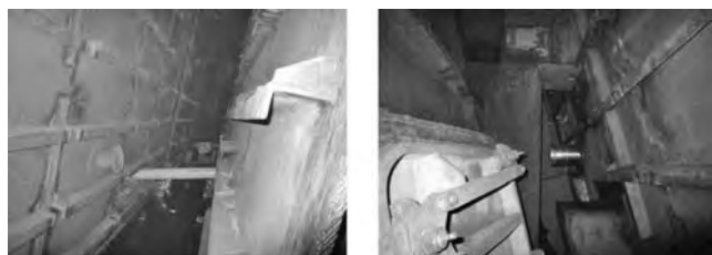
写真—3 6号函側バルクヘッド中状況
