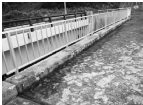
写真一2 施工前状況
