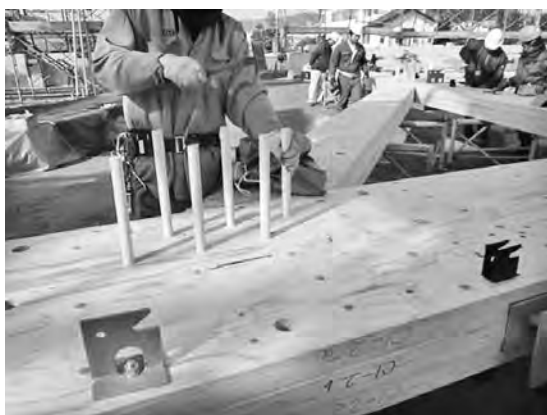
写真一2 地組状況 (地組みブロック①)
