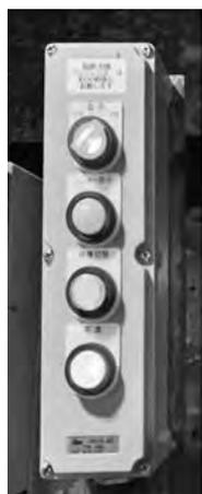
写真一六 プロジェクター起動スイッチおよび画像の切替えボタン
