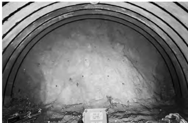
写真—2 吹付けコンクリートに覆われた切羽
