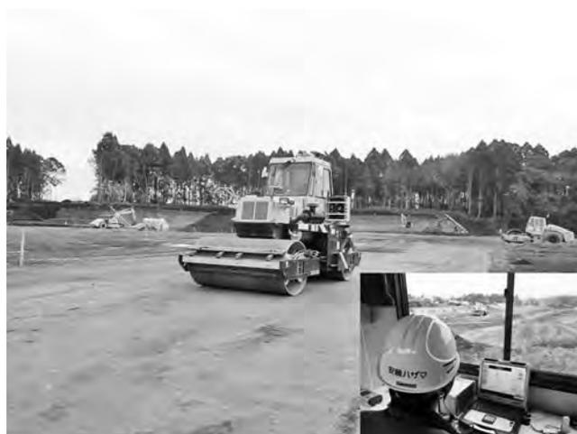
写真—1 締固め作業の自動施工
