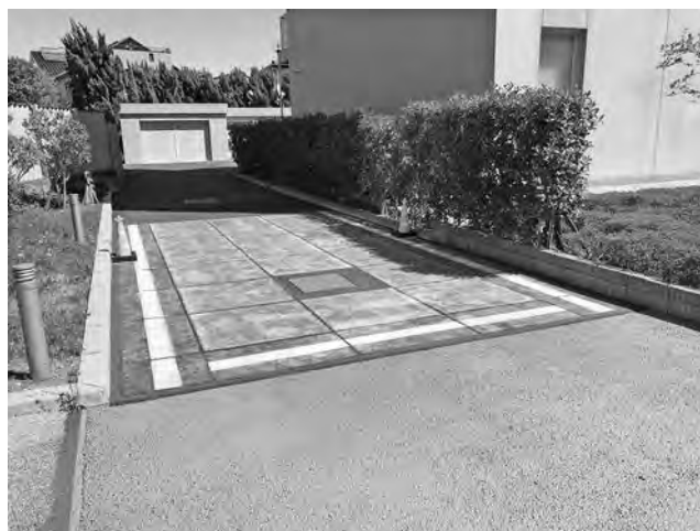
写真-1 開発した太陽光発電舗装
