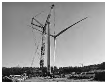
写真一6 風車据付
