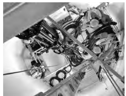
写真一7 タワー内配線、耐圧試験
