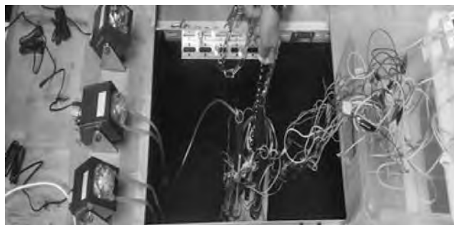
写真一 3 下水処理場への設置状況
