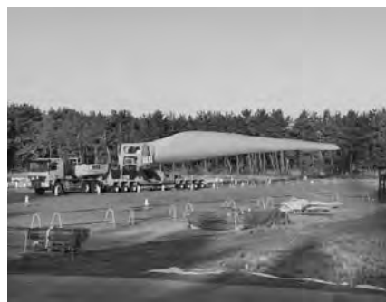
写真-15 リフター
