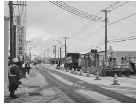
写真一〇 送電管路工
