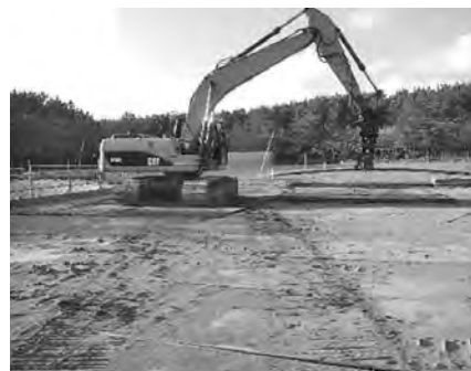
写真一3 ヤード造成
