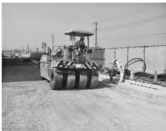
写真—5 外構工事転圧作業状況
