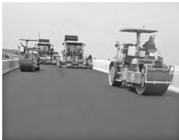
写真—6 高速道路舗装工事転圧作業状況
