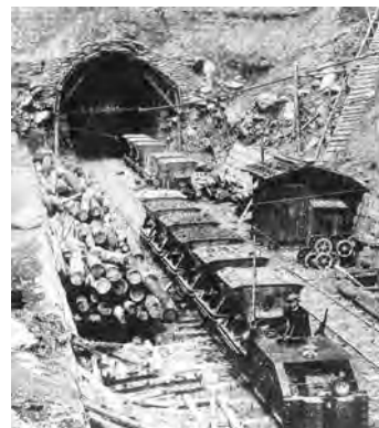
写真—1 笹子隧道坑口
