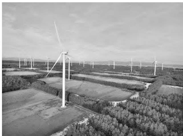
写真—1 本工事の風車
