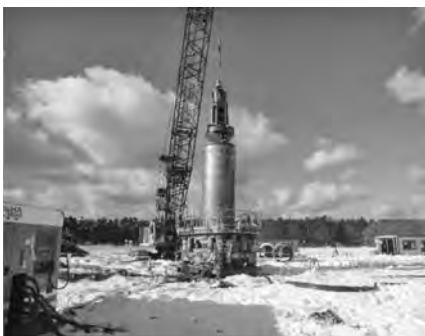
写真一2 風車基礎工
