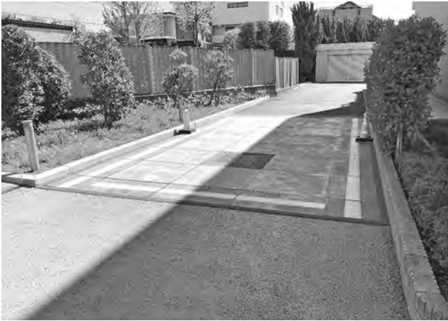
写真一4 日陰混在による電氣的耐久性確認
