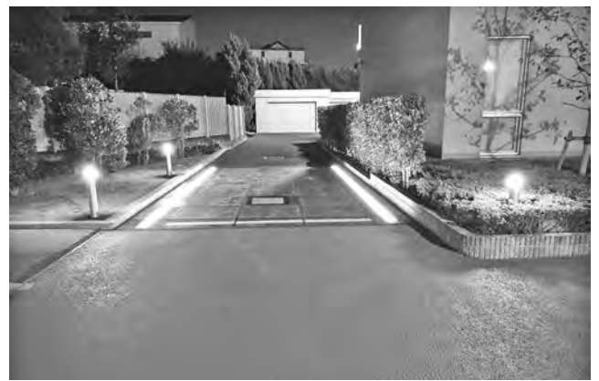
写真一6 LEDによる区画線の路面発光表示
