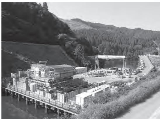
写真—2 シールド機掘進用仮設備設置状況
