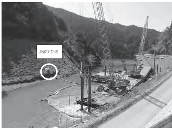
写真—1 仮設構台設置状況
