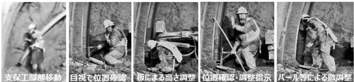
写真一 2 現行の鋼製支保工脚部における作業フロー（切羽左側）
