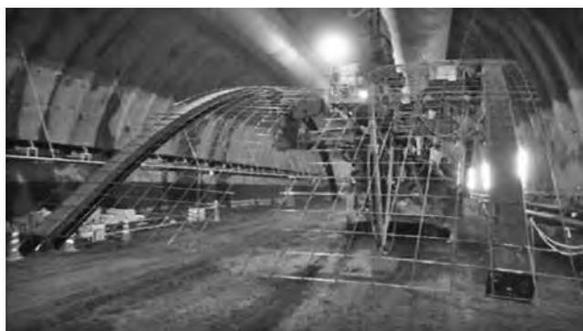
写真—11 溶接金網取付完了
