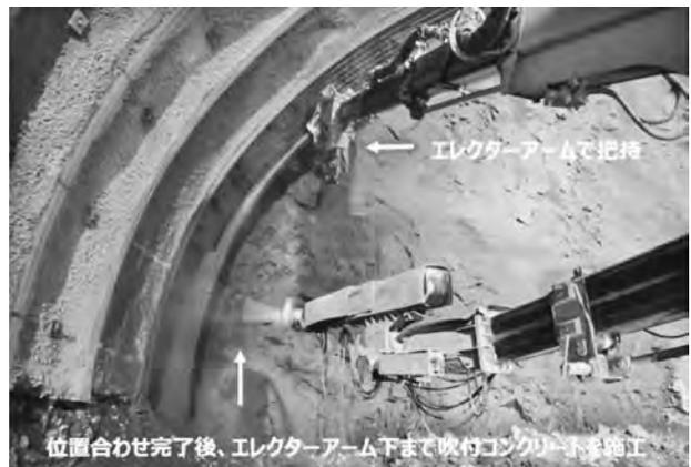
写真—15 左側鋼製支保工脚部固定状況
