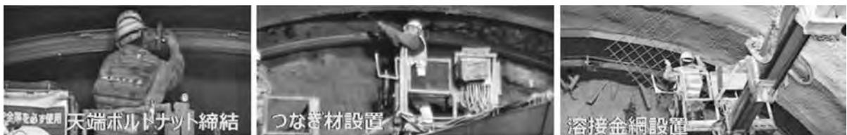
写真一 3 現行の鋼製支保工天端部における作業フロー
