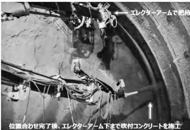
写真—13 右側鋼製支保工脚部固定状況
