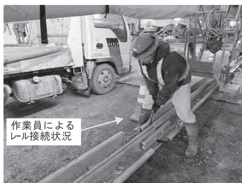
写真二 従来のレールの移動状況
