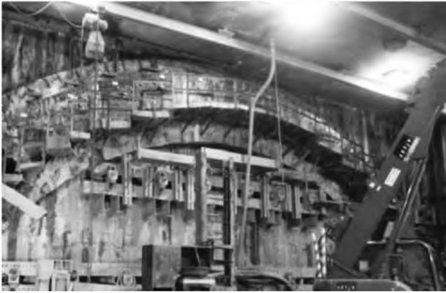
写真—1 角形エレメント推進工上半施工完了
