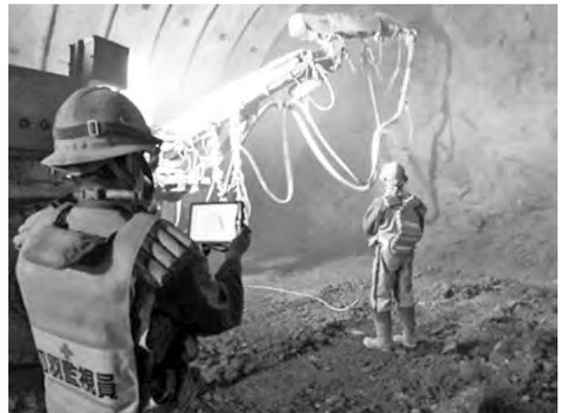
写真一3 切羽監視員による切羽監視状況
