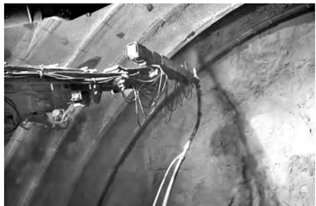
写真—16 天端部二次吹付けコンクリート状況
