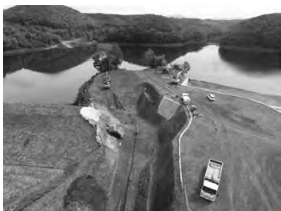
写真—23 新設堤体周辺状況 (心壁撤去前状況)
