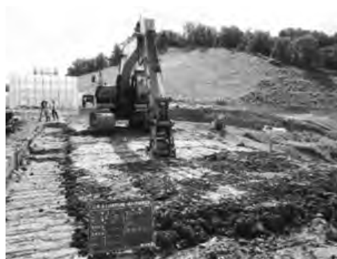
写真—12 堤頂部鋼土転圧
