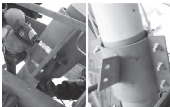
締め込み状況
