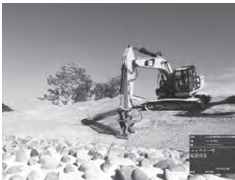
写真—14 フィルター転圧
