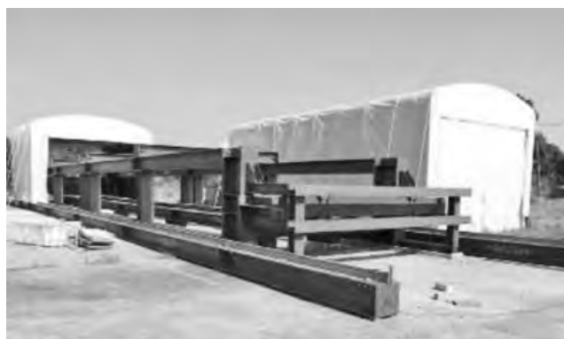
写真一7 製作ヤード(緊張設備)
