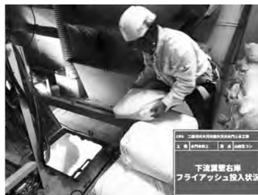
写真—3 フライアッシュ投入(内包用袋に水解紙充填袋を使用)
