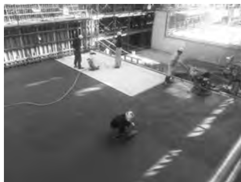
写真-3 施工状況
