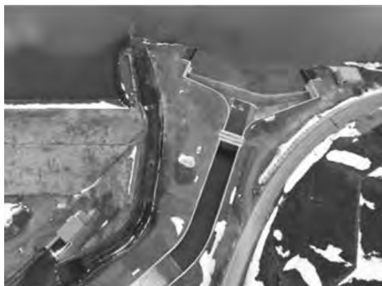
写真—22 既設洪水吐撤去前 (協力会社作業予定打合せなどで使用)
