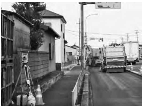
写真一 2 市街地における MC 施工の状況
