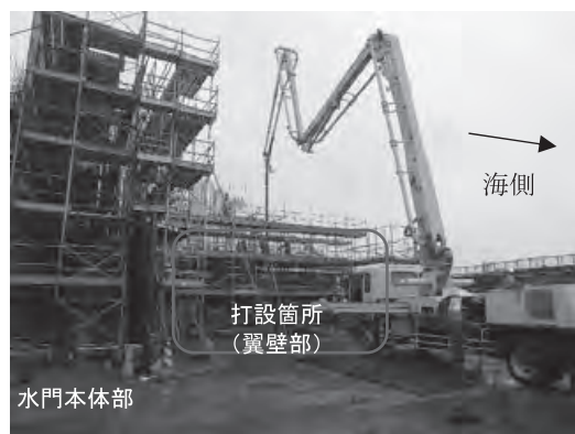
写真—1 打設状況
