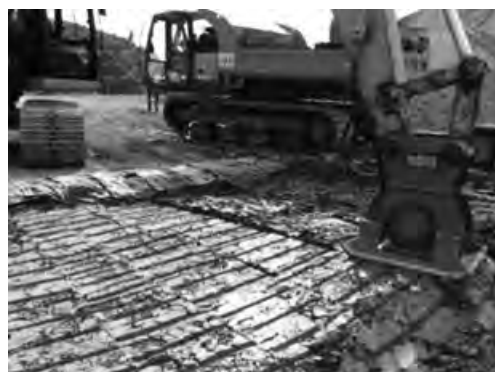
写真—11 転圧状況
