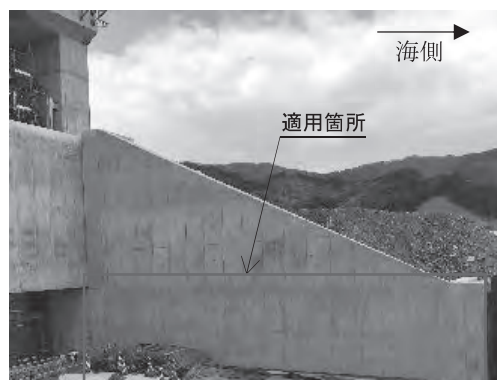
写真—2 脱型後の状況
