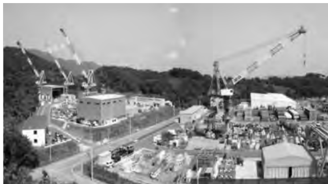
写真—1 クライミングクレーン
