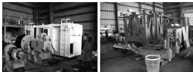
写真一3 整備試運転検査
