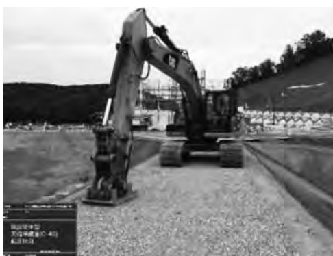
写真—13 天端保護層転圧
