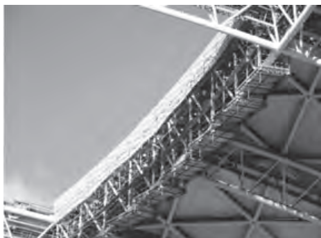
写真二 施工時の吊り足場の状況
