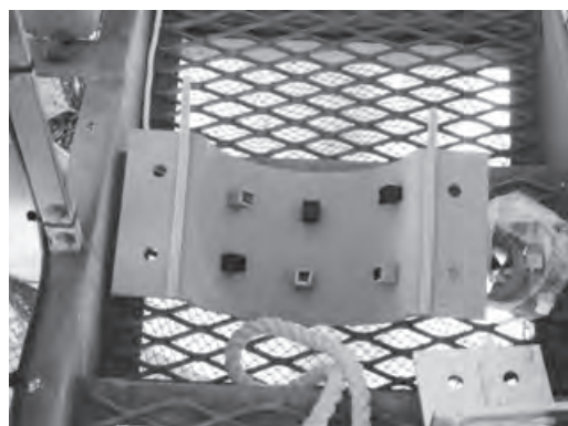
写真—5 ゴムパッキンの取付け状況
