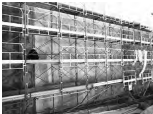
写真-2 壁面の養生状況
