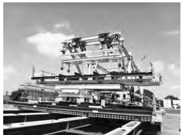
写真ー2 床版架設機
