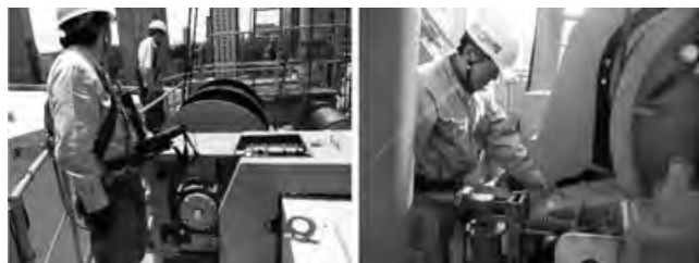
写真一2 現場点検
