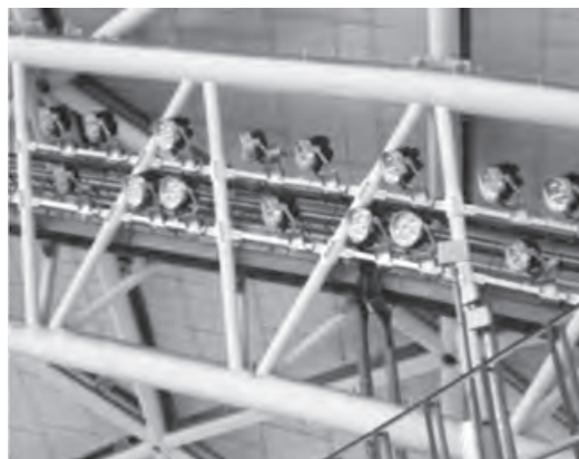
写真—7 工事完了状況
