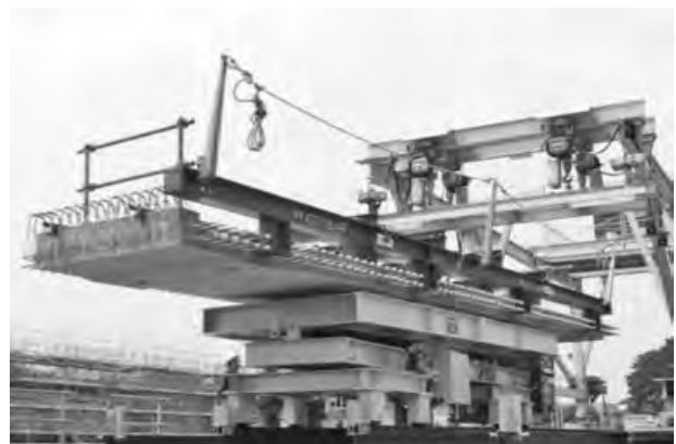
写真ー3 ターンテーブル付き床版運搬台車
