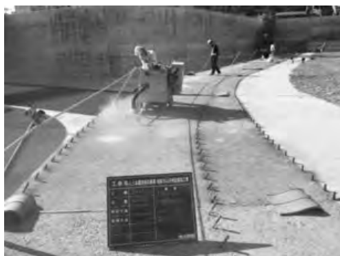
写真一五 溝切り状況
