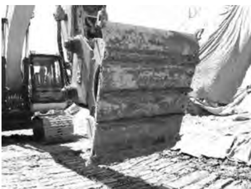
写真—10 鋼材取り付け
