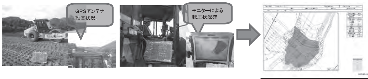
図—12 転圧管理システム
