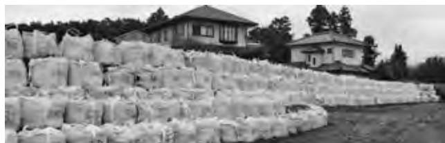
写真二 永野川（左右岸）栃木市片柳町「二杉橋下」
