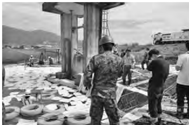
写真—4 流出油の除去作業（柏木樋管にて）
