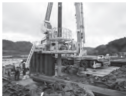
写真—6 施工状況写真
