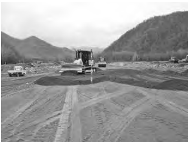
写真—5 盛土材巻き出し状況
