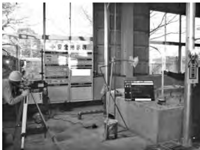
写真－6 ディーゼル機関台盤の据付高さ調整（S5排水機場）
