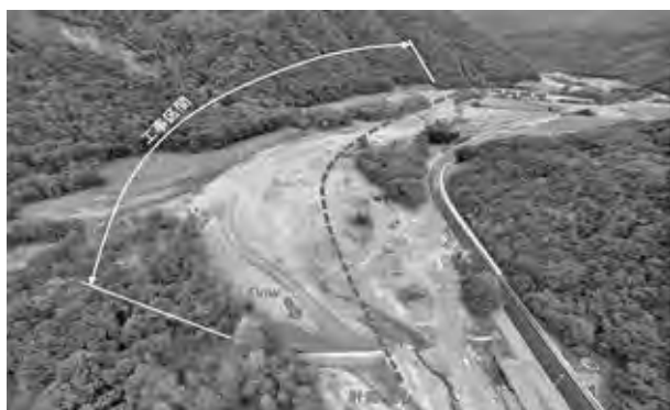
写真-2 着工前 H29.09 撮影
