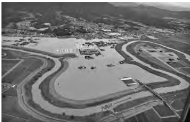
写真—2 六角川周辺の浸水状況（佐賀県大町町）
