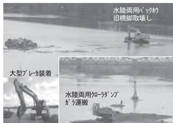
写真一九 木曽川旧橋脚撤去状況
