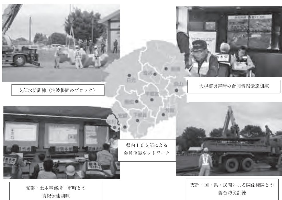
図一3 定期的な訓練や連携確認が早期の応急仮復旧工事完了に繋がった
