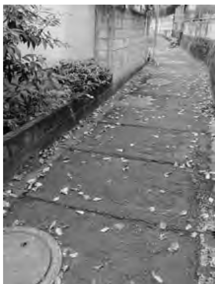
写真—1 羅漢寺川(入谷川)。高度経済成長期からの侘び寂あふれる暗渠景観。
