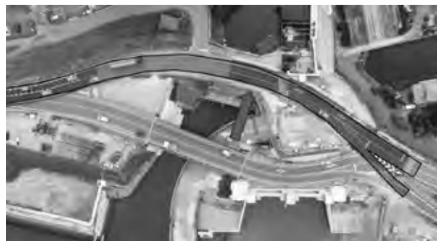
写真—6 県道切替後
