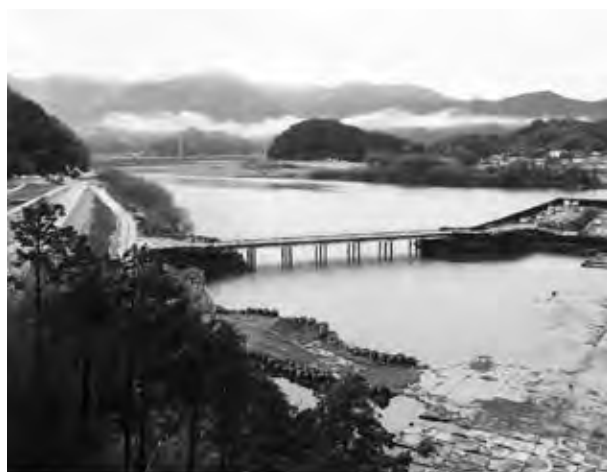
写真—11 仮設栈橋設置完了状況
