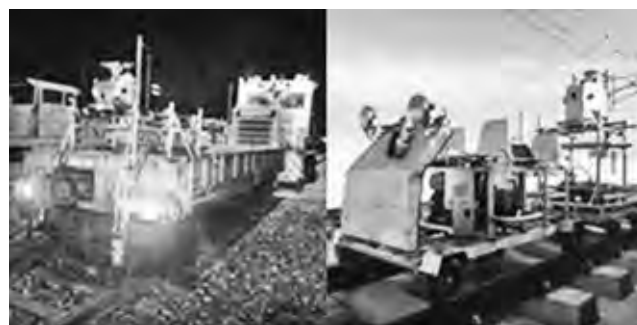
図一12 計測作業の様子 左：保守用車、右：軌道自動自転車
