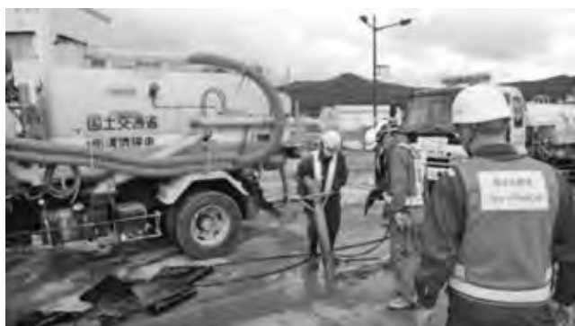
写真—10 路面清掃（長野県長野市）
