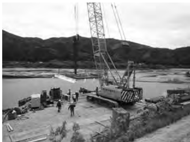
写真—9 鋼製パネル設置状況
