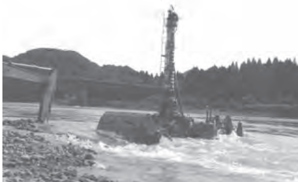
写真一六 阿賀野川河道掘削状況
