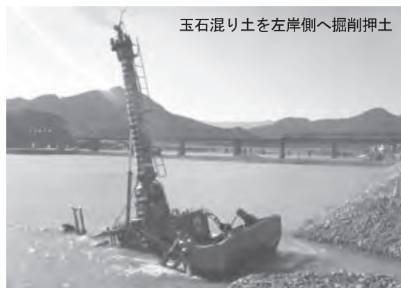
写真—4 熊野川河道掘削状況
