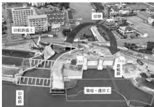
写真—4 施工手順 (2)
