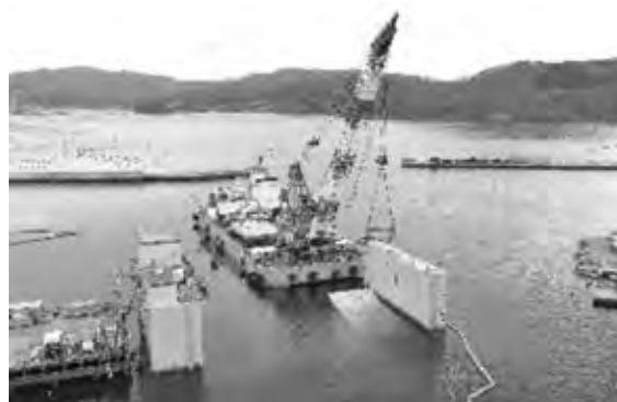
写真—3 扉体据付状況
