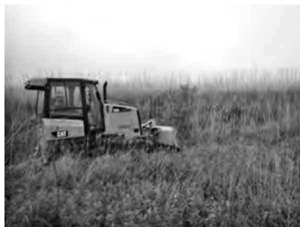
写真—1 ブルドーザーによる踏み倒しの概要
