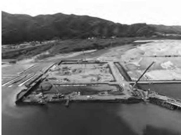
写真—8 硬質地盤クリア工法3班施工状況
