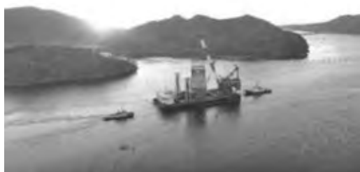
写真—2 本体二次曳航および現地据付状況
