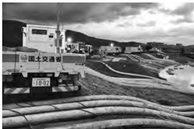
写真—3 排水ポンプ車による緊急排水状況（佐賀県大町町）
