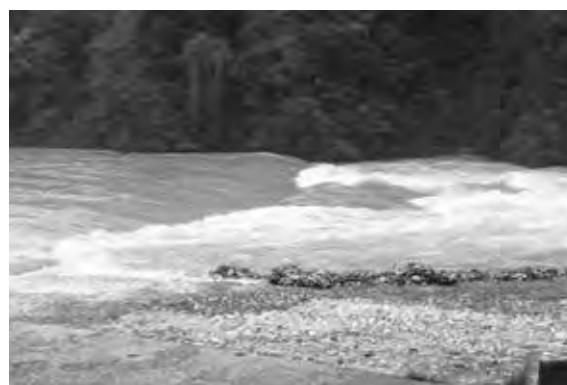
写真—4 内江と飛沙堰 (出水期には、内江の水が手前の飛沙堰を越えて外江へ流れる)
