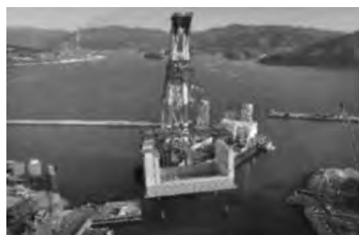
写真—2 本体二次曳航および現地据付状況
