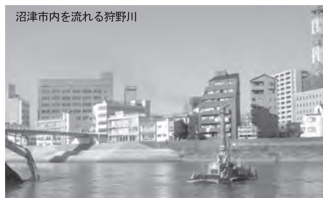
写真—5 狩野川河道掘削状況
