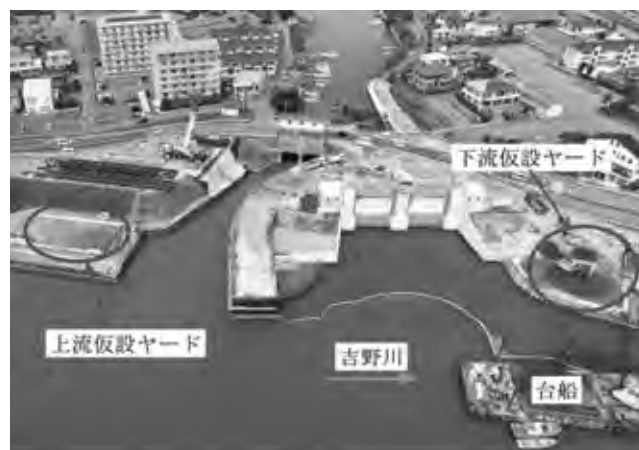
写真—7 上下流仮設ヤード
