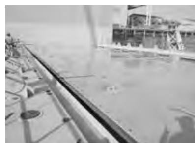
函体内水張 調整・試運転
