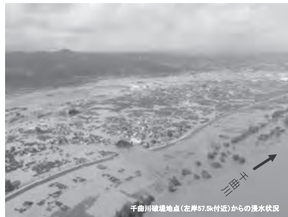
写真二 令和元年東日本台風における被災状況（信濃川水系千曲川の決壊）
