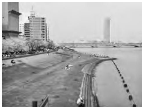
写真—2 やすらぎ堤整備後
