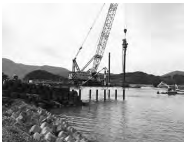
写真—10 支持杭打設状況
