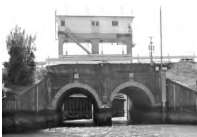
写真—1 既設榎瀬川樋門
