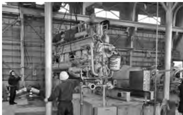
写真－4 ディーゼル機関の取り外し（S5排水機場）
