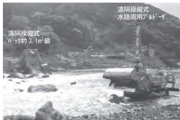
写真—11 熊本地震災害復旧状況
