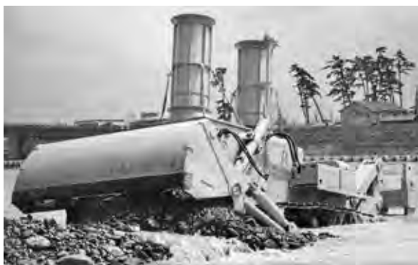
写真—1 D125-18B型 水陸両用ブルドーザ
