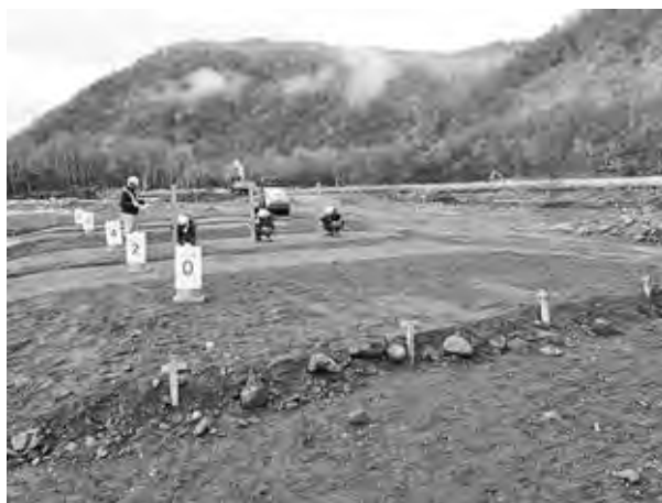
写真—4 試験施工状況
