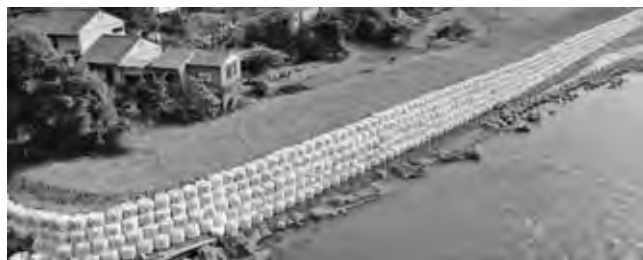
写真一 荒川（左岸）那須烏山市藤田「藤田橋下」
