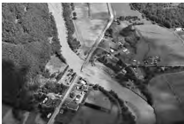
写真—1 千呂露橋被災状況
