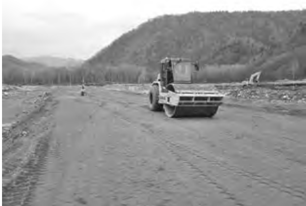
写真—6 転圧締固め状況
