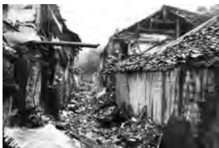
写真一七 被災直後の西街（2008年6月）
