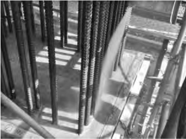
写真一3 柱部材の洗い出し
