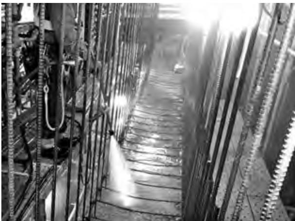
写真一4 壁部材の洗い出し
