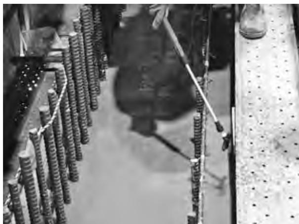
写真2 壁部材の打継ぎ目処理剤散布状況
