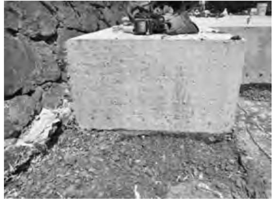
写真—4 仮床版切断後状況
