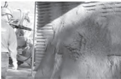
図一七 吹付状況 (模擬トンネルでの吹付試験)
