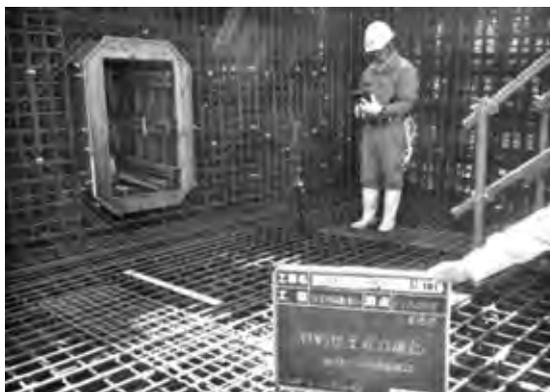
写真—5 鉄筋計測状況
