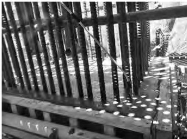
写真1 柱部材の打継ぎ目処理剤散布状況
