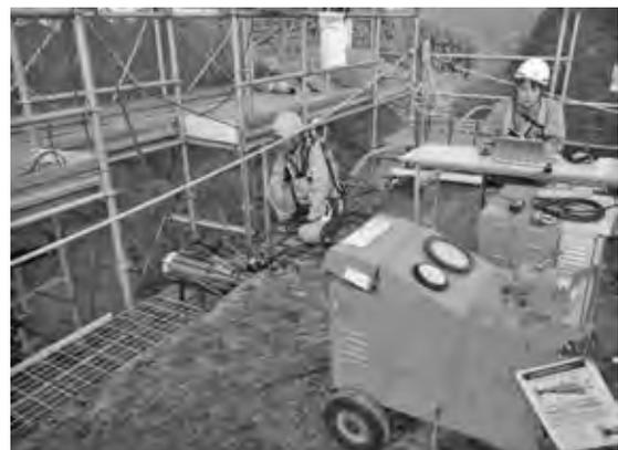
写真一1 自動緊張施工状況
