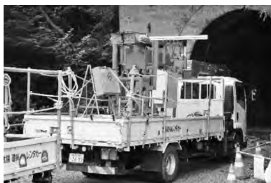
写真-7 トンネル搬入時
