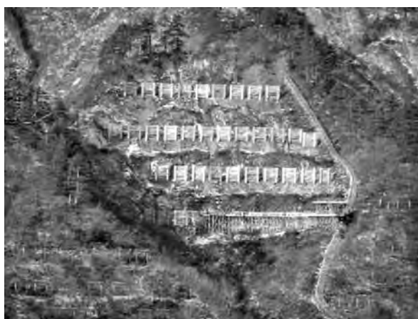
写真—12 雪崩柵設置後、作業構台を撤去中
