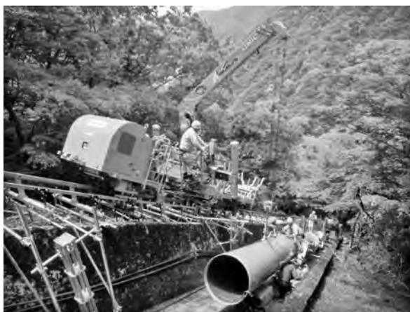
写真—6 2t積載クレーン台車
