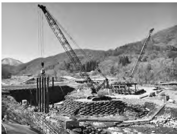
写真—7 鋼管杭打設状況
