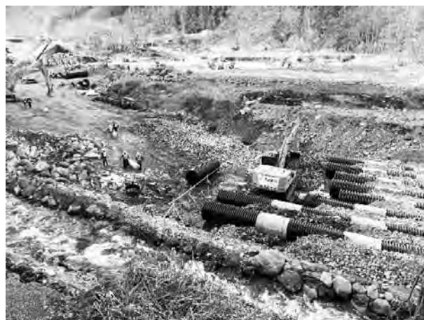
写真一3 コルゲートパイプ設置状況
