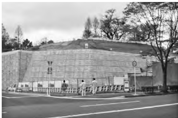
写真一 1 調査時（本工法全景）
