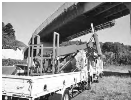
写真-6 完成機械（T3 カッター）
