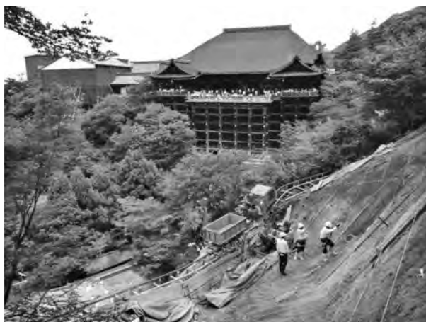
写真—1 清水寺災害復旧工事
