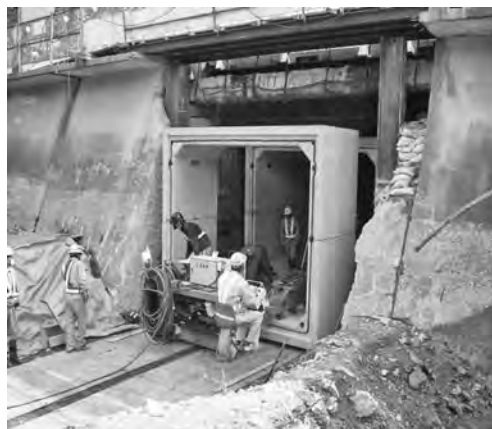
写真-6 道路高架下での施工状況
