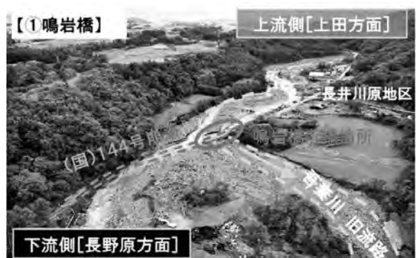
写真—1 被災状況 1)
