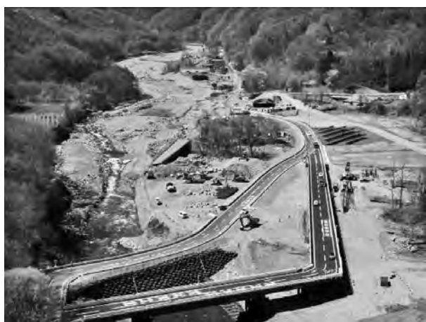
写真—11 仮橋完了全景（ドローン撮影）
