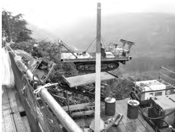
写真—10 モノレール荷台を水平に角度補正
