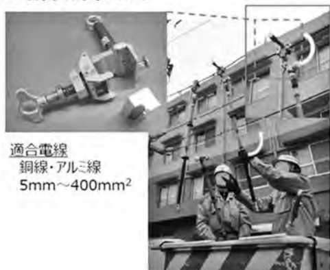
図—1 全国の電線径に対応した「電線被覆剥取工具（マルチホットハグラー）」 1)
