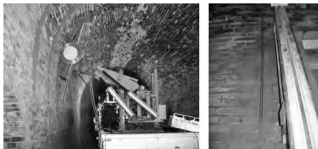
写真—8 作業状況
