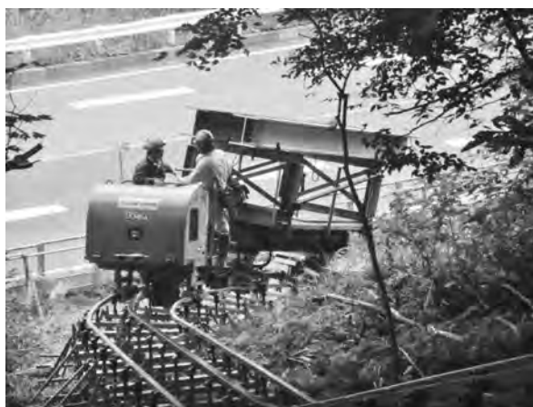
写真—11 500H 鋼 2本を運搬
