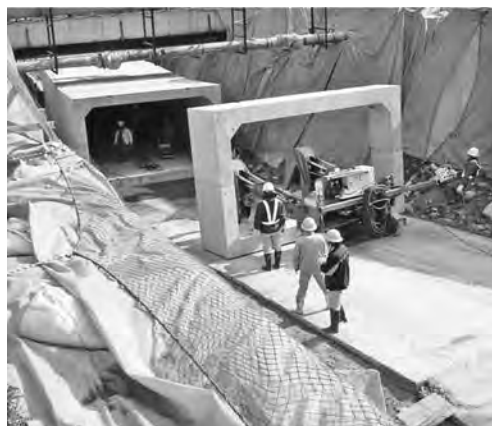
写真-8 縦断勾配部での施工状況
