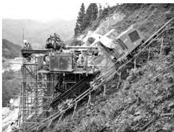
写真-2 4t積載フラットデッキダンプ台車
