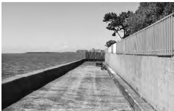
写真—6 ガレットサンド設置箇所
