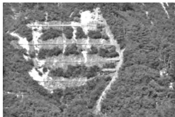
写真—7 最上部より作業構台を設置
