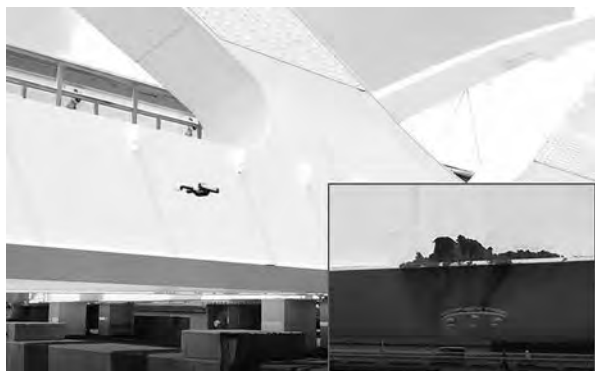
写真一 3 点検事例③
