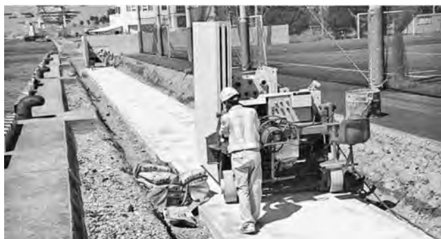
写真—12 バラベツ施工状況
