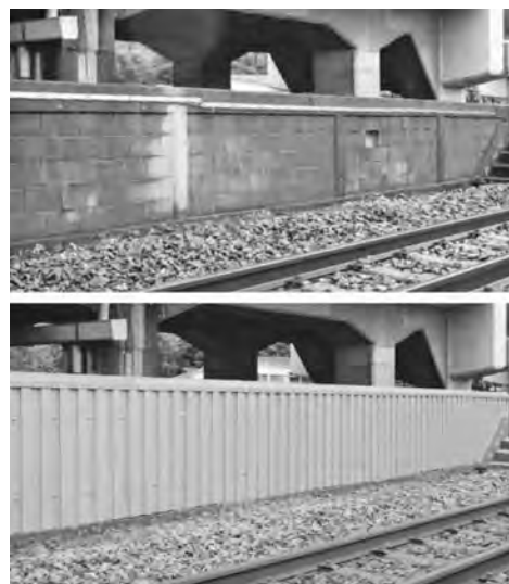
写真—1 本工法外観（上：施工前、下：施工後）
