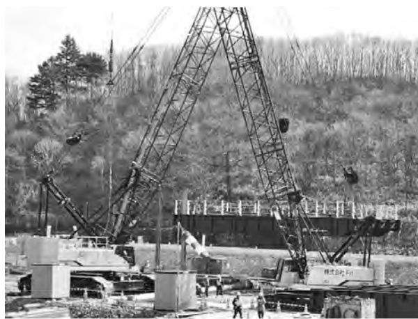
写真—8 一括架設状況
