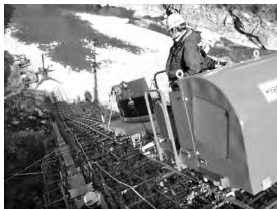
写真—16 ミニクローラークレーンで重機組立
