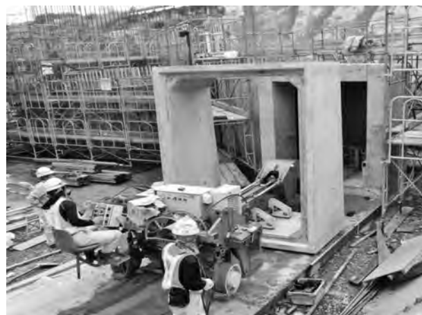
写真－2 搬送据付装置での施工状況
