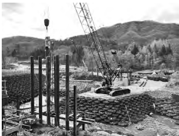
写真—6 プレボーリング状況
