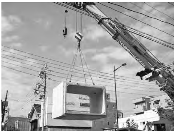
写真－1 PCa製品クレーン施工状況
