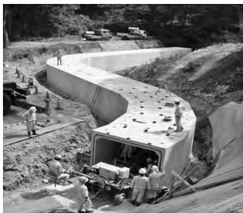
写真-7 曲線部での施工状況
