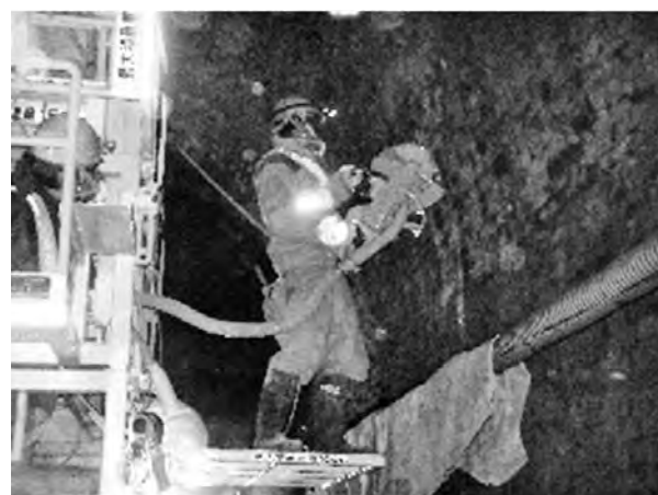
写真一 3 レンガ切断工
