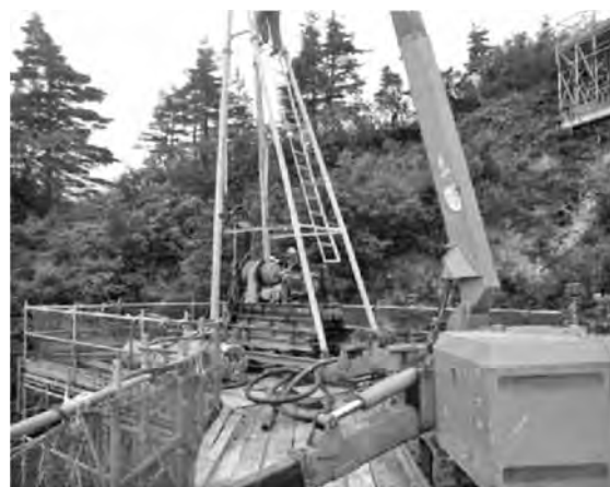
写真—9 ダウンザホールハンマの機材を搬入
