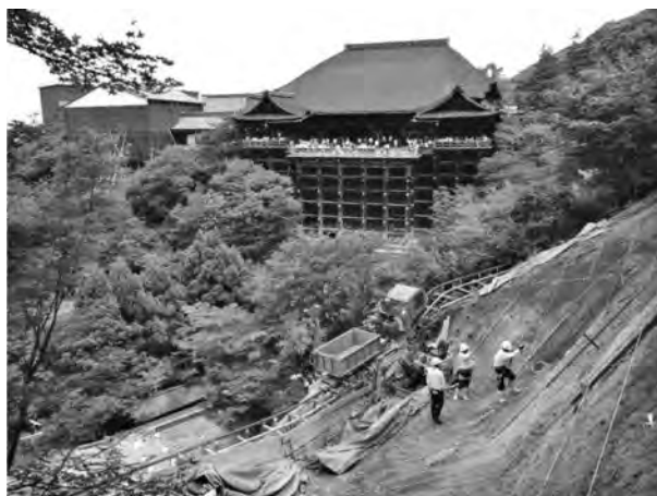
写真—1 清水寺災害復旧工事
