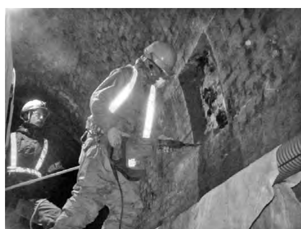
写真一 4 レンガはつり工
