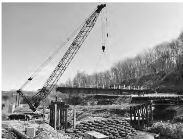
写真—9 分割架設状況
