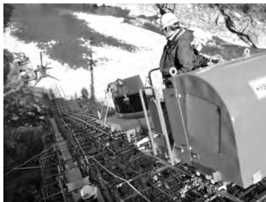
写真—16 ミニクローラークレーンで重機組立
