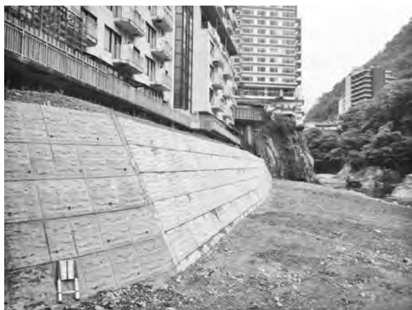
写真—20 護岸復旧後
