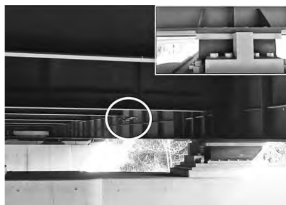
写真一7 点検写真 支承部
