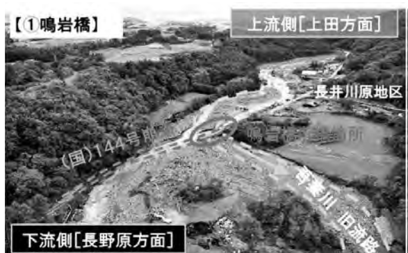
写真—1 被災状況 1)
