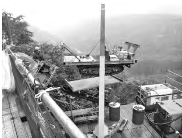
写真—10 モノレール荷台を水平に角度補正
