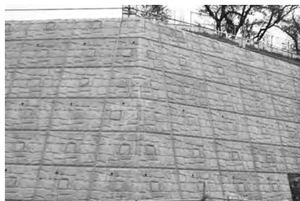
写真一 2 出隅部の状況
