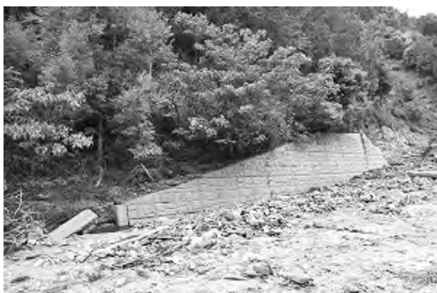
写真—6 調査時（起点側より）
