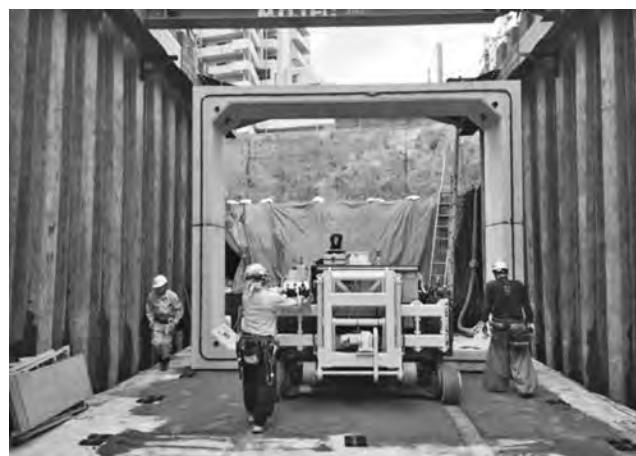
写真ー10 2分割ボックスカルバート施工状況
