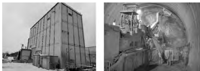
図—1 コンクリート製造設備および吹付けコンクリート施工状況
