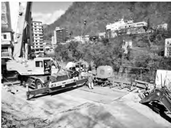
写真—15 0.45 m 3 バックホウを分解運搬
