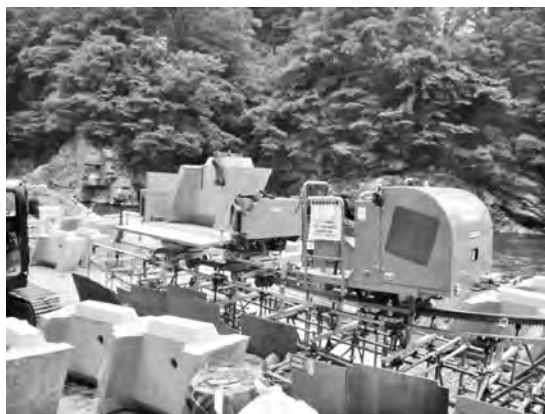
写真—17 大型ブロックを積込固定できるように改造
