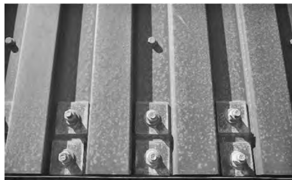
写真—7 高耐食めっき鋼板（3年経過時）
