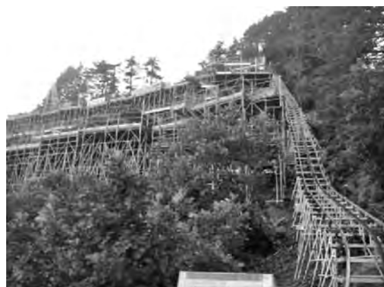
写真—8 作業構台上に資機材搬入
