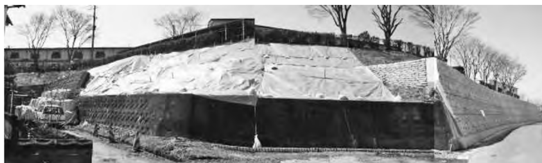
写真一 3 調査時（本工法全景）
