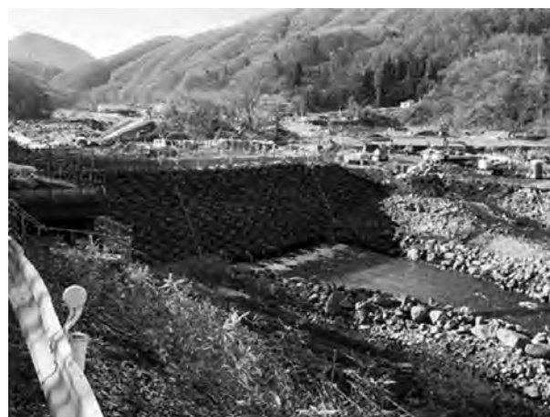
写真—5 緊急迂回路施工完了
