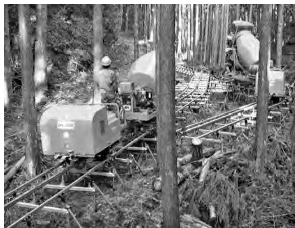
写真-5 1m 3 ミキサー台車
