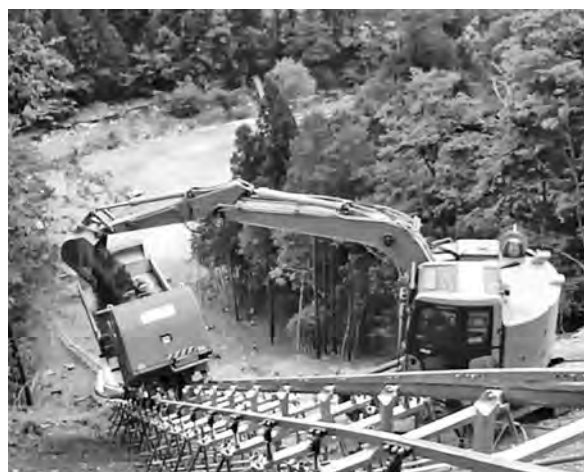
写真-3 傾斜地でダンプ荷台を角度補正
