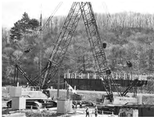
写真—8 一括架設状況
