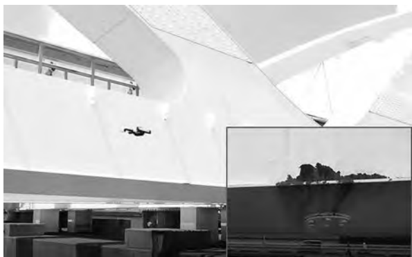
写真一 3 点検事例③
