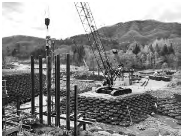
写真—6 プレボーリング状況
