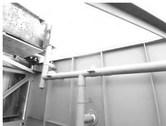
写真一6 点検写真 下フランジ上面
