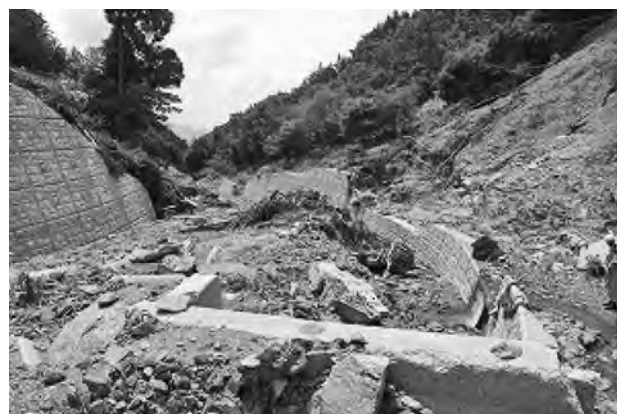
写真—8 調査時（起点側より）
