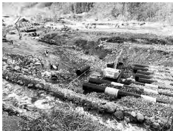
写真一3 コルゲートパイプ設置状況
