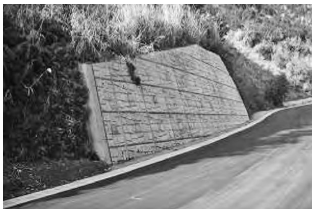
写真—5 施工完了時（起点側より）
