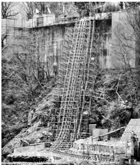
写真—14 河川敷に向かってレールを設置
