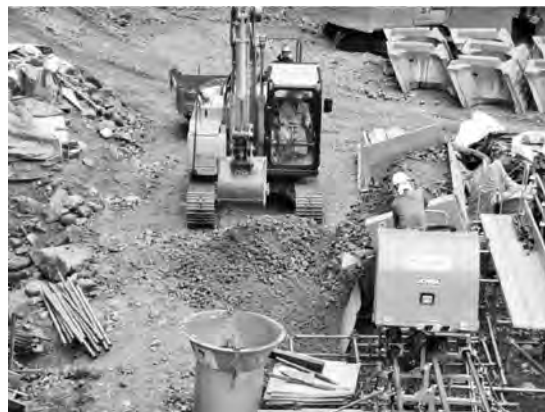
写真—18 大型ブロックの裏込め材（碎石）を運搬
