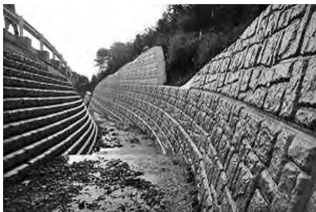
写真—7 施工完了時（起点側より）
