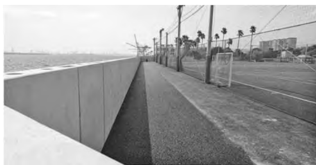
写真—13 バラベツ施工完了
