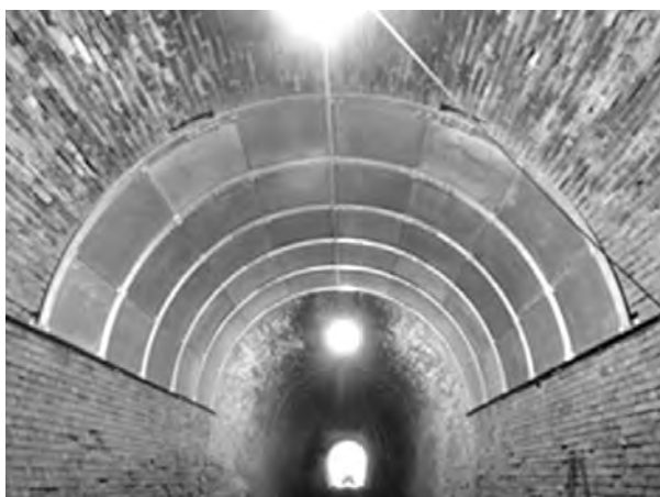
写真一 1 T3 パネル工法設置事例 1
