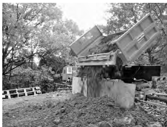
写真-4 サイドダンプで土砂を排出
