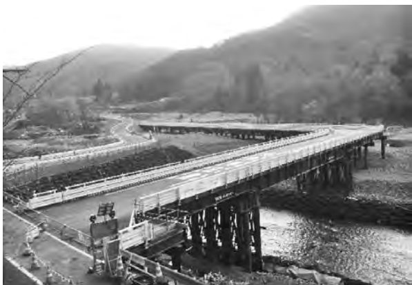
写真一10 仮橋完了全景（起点側）
