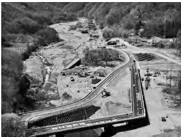
写真一11 仮橋完了全景（ドローン撮影）
