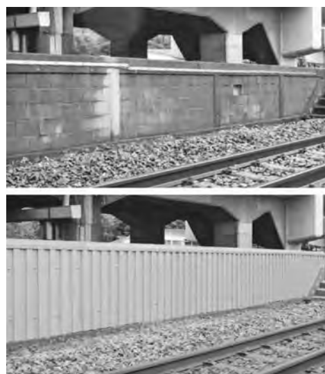
写真—1 本工法外観（上：施工前、下：施工後）
