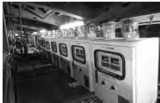
写真一10 圧力温度センサーモニター
