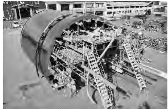
写真-1 ホース伸縮連続打設システム全景
