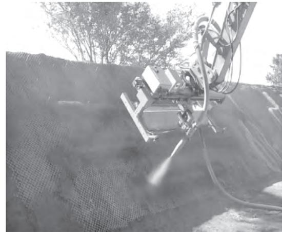
写真一 4 横枠吹付け状況
