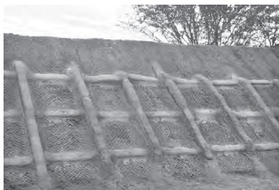
写真一6 格子柵吹付け完了
