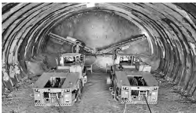
写真一 4 ロックボルト施工状況
