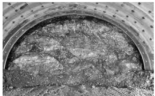
写真-2 切羽写真の例
