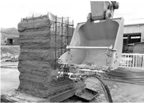
写真—6 埋設型枠（水平吹き）の造形状況
