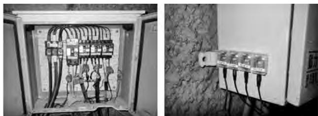
図一2 電力センサー取付け状況
