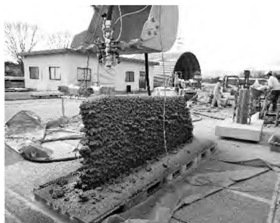
写真一5 壁状部材（鉛直吹き）の造形状況
