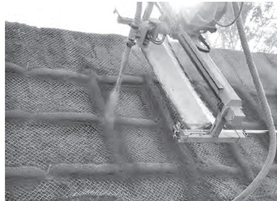
写真一 5 縦枠吹付け状況
