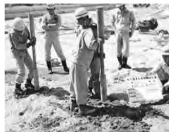
写真—61 凹部の杵突き
