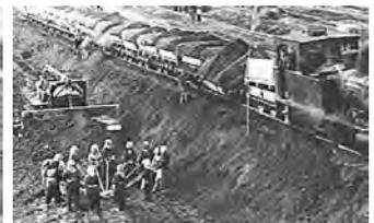
写真—44 石蛸による突固め
