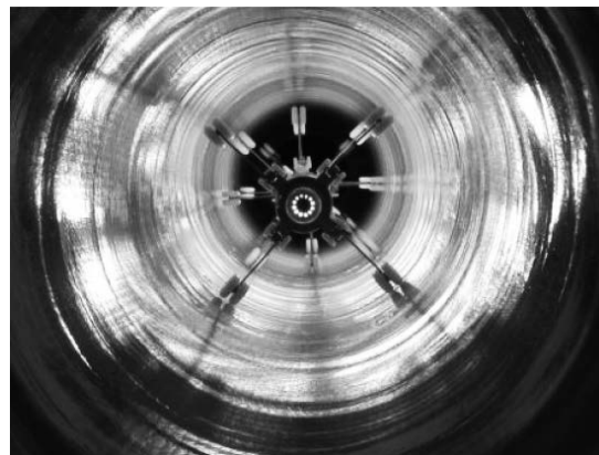
写真-1 人孔内光射装置
