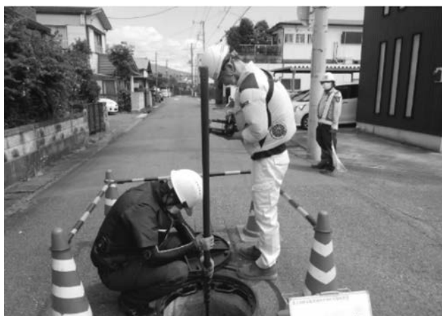
写真-5 現地作業状況
