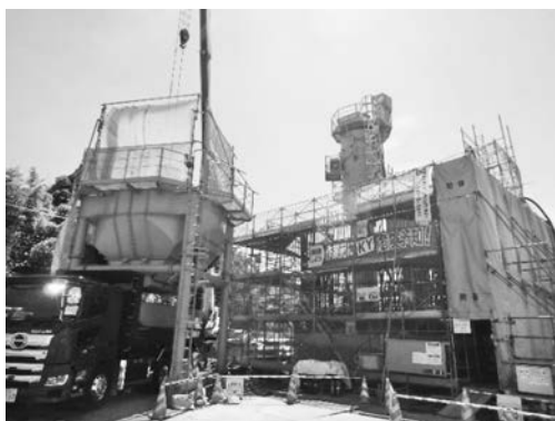
写真—7 ニューマチックケーソン施工状況
