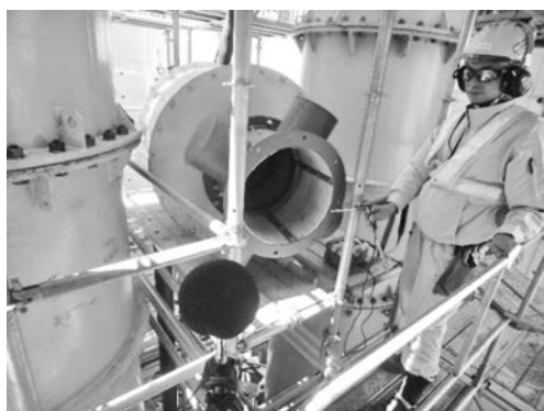
写真—8 現場での計測状況
