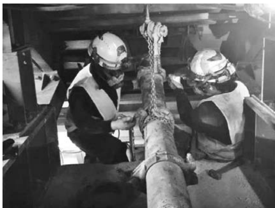
写真ー1 配管切替作業
