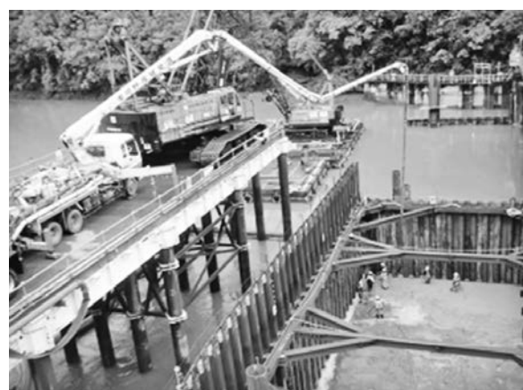
写真—6 右岸側均しコンクリート打設
