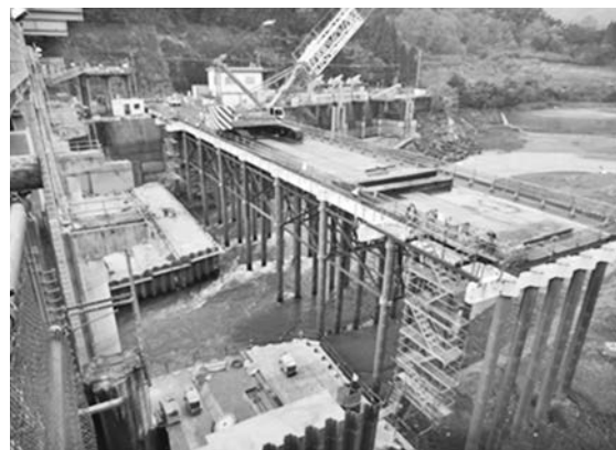
写真—2 上流作業構台設置状況
