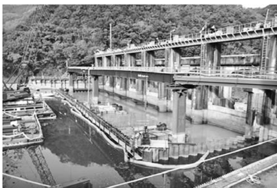
写真一 8 止水矢板薬液注入状況 (2 期)
