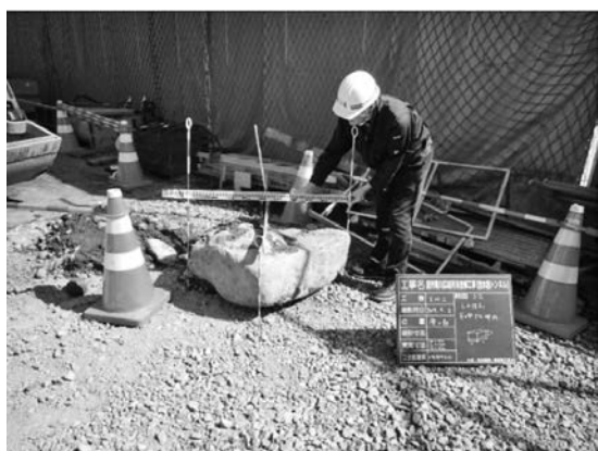
写真一八 中間立坑巨礫 1,000 mm×850 mm×450 mm
