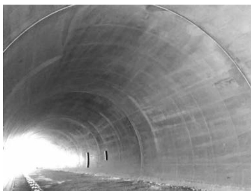
写真—8 仕上り状況
