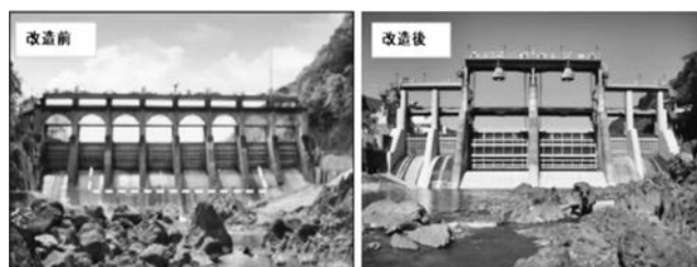
写真1 改造前後の西郷ダムの全景
