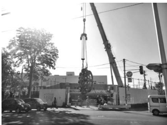
写真一七 新規カッターヘッド投入状況
