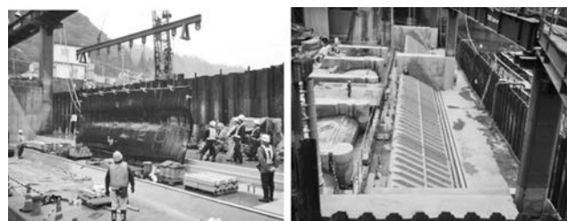
写真一 9 ゴム袋体と壁体設置状況
