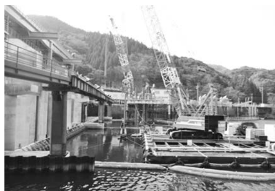
写真—3 80tクレーン台船作業状況（5期）
