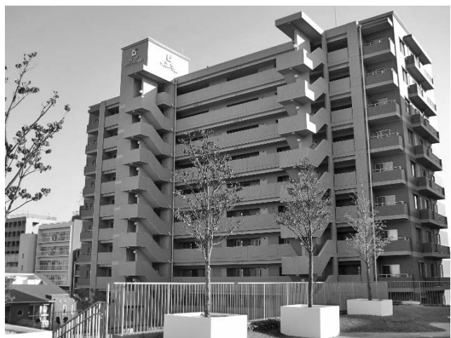
写真—2 定期(転)借地権付分譲マンション「アイパークス岡山」(出石小学校跡地整備事業H20.2竣工)(H23.10筆者撮影)
