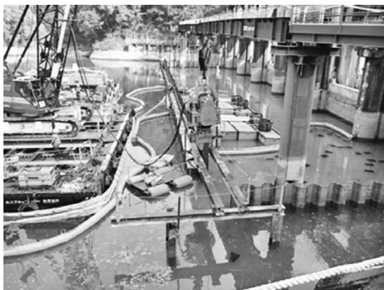
写真一 7 止水矢板打設状況 (2 期)
