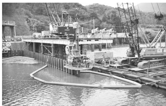
写真—4 仮締切鋼矢板打設状況 (1期)
