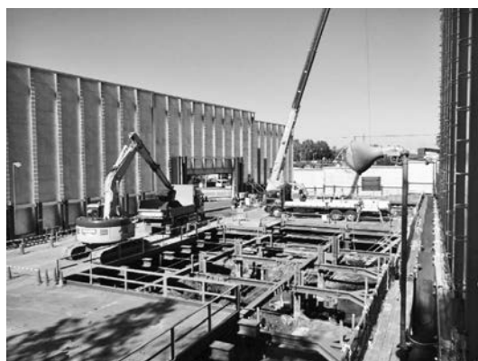
写真-1 呑口部掘削・山留施工状況
