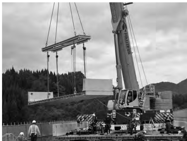
写真一 10 壁高欄一体型コッター床版の架設状況
