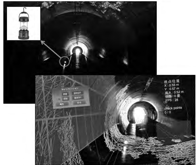
図一 8 LED ランタンによる構内照明
