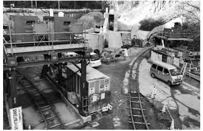
写真三 上口・下坑口全景
