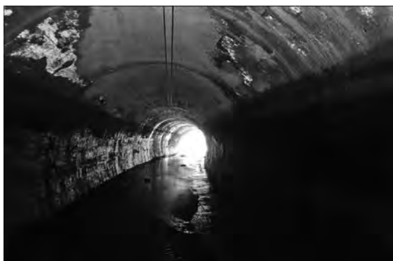
写真—1 水路トンネル構内
