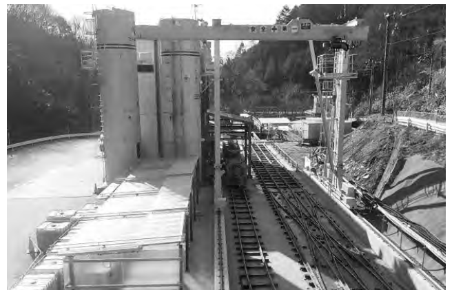
写真五 門型クレーン・充電ヤード・バッチャープラント
