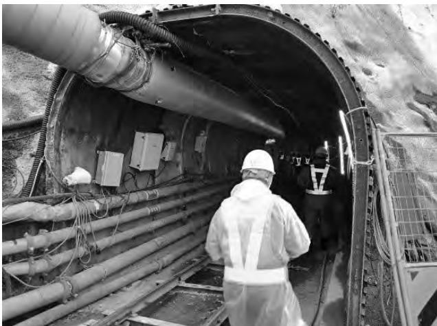
写真一七 坑口部
