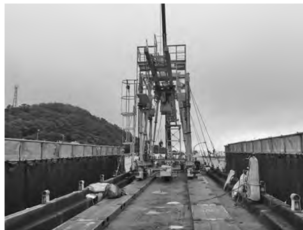
写真一3 床版取替機によるプレキャスト床版の架設
