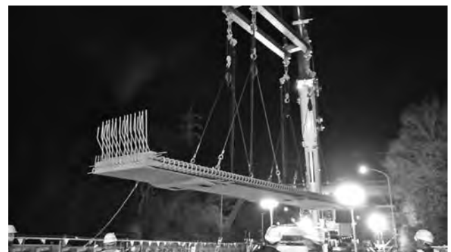
写真一 1 クレーンによるプレキャスト床版の架設
