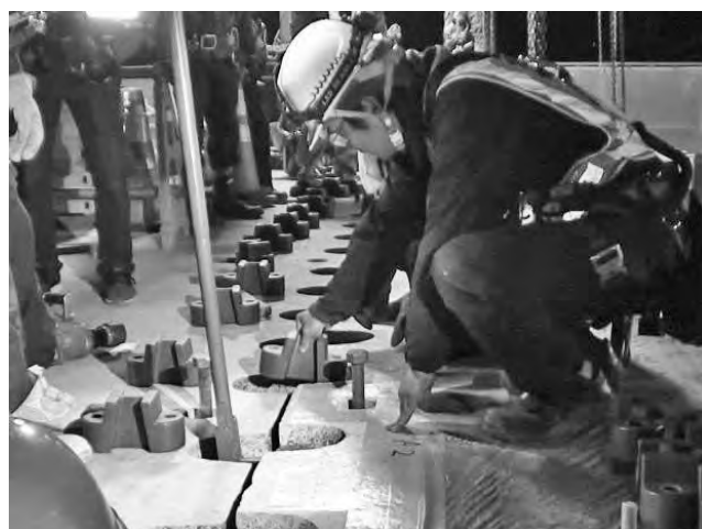
写真一 5 H 型金物の挿入状況
