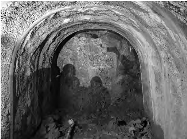
写真—13 切羽状況
