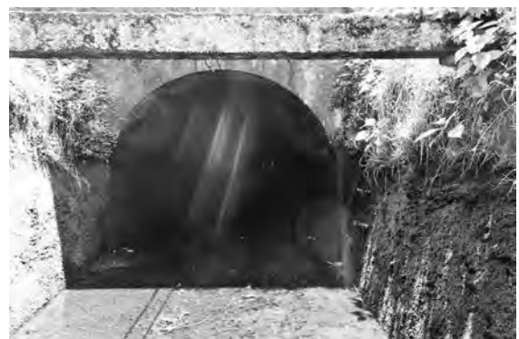
写真—2 水路壁面の状況
