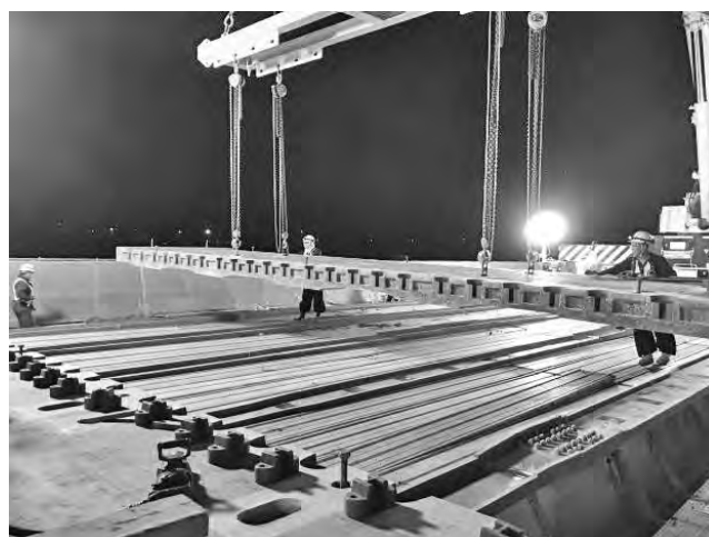
写真一 3 コッター床版の架設状況
