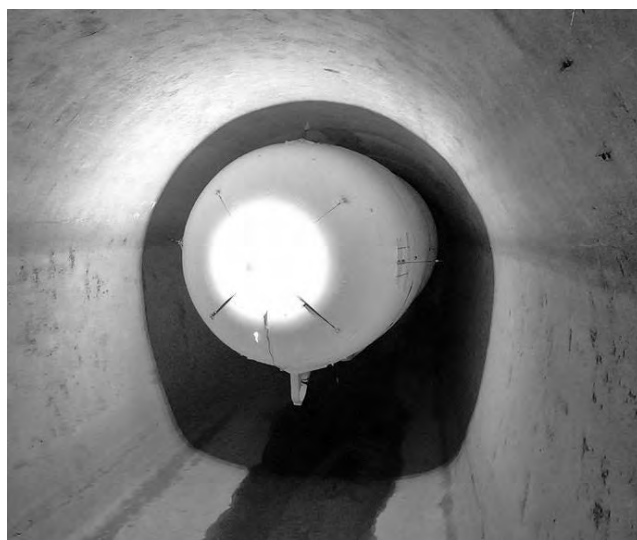
写真7 自律飛行による調査状況
