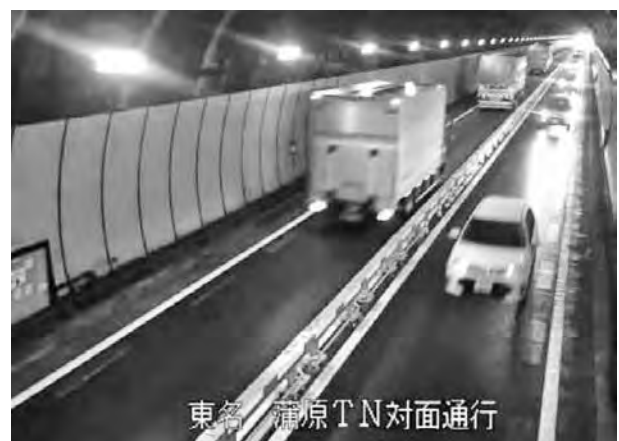
写真一五 トンネル区間内鋼製防護柵の設置状況
