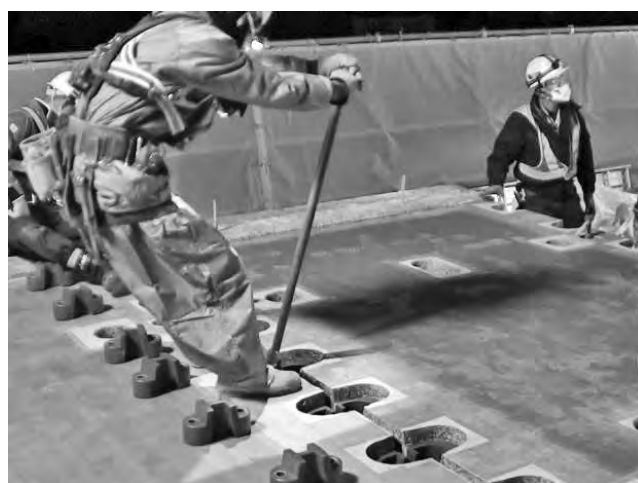
写真一 4 専用治具による引寄せ状況
