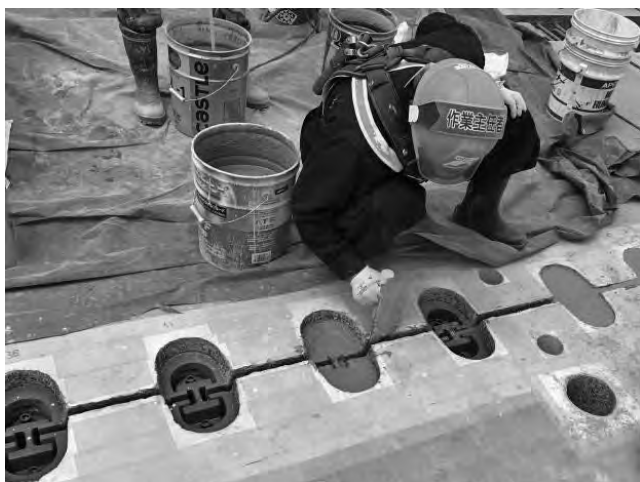
写真一七 目地材の充てん状況
