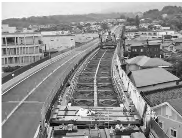
写真一2 床版架設機によるプレキャスト床版の架設
