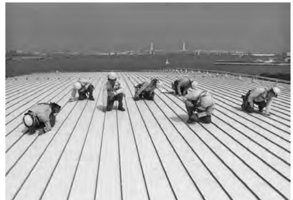
写真一十 屋根ステンレスシーム溶接の自主検査（従来）
