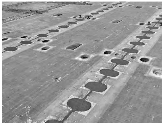
写真一八 目地材充てん完了（接合完了）状況
