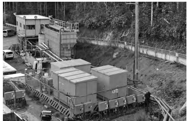
写真六 受電設備
