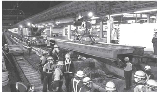
写真一1 鉄道クレーンによる工事桁架設・撤去
