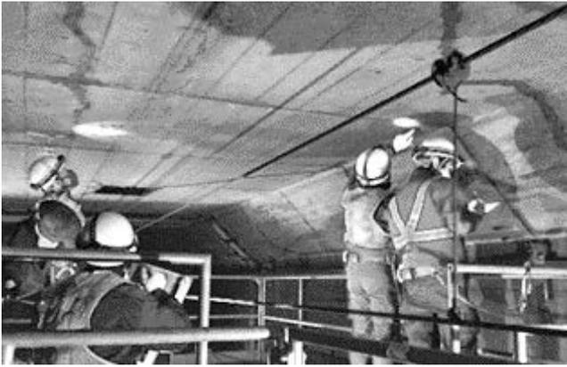
写真一2 ひび割れ調査状況
