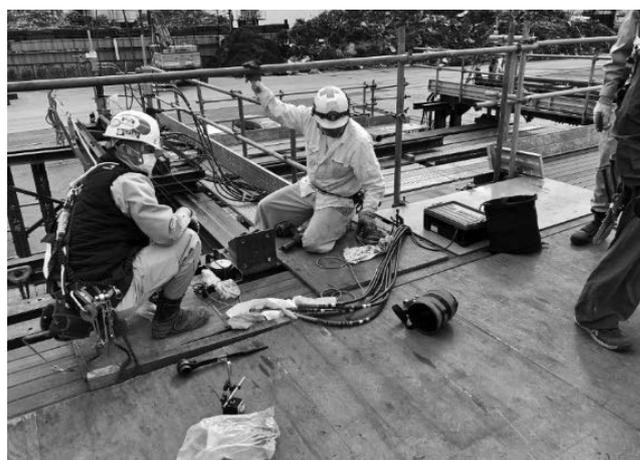
写真-21 交換試験 (ジャッキ)
