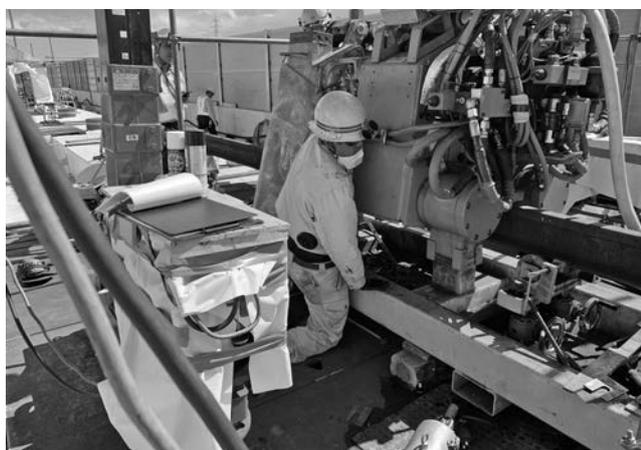
写真-2 芯出し調整作業
