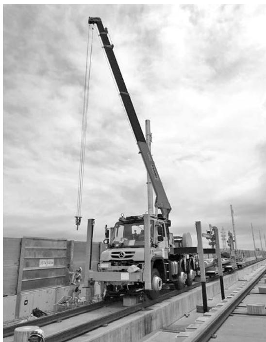
写真-8 電化柱建植作業
