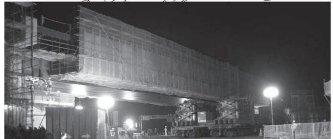
b) 多軸式移動台車による桁架設
