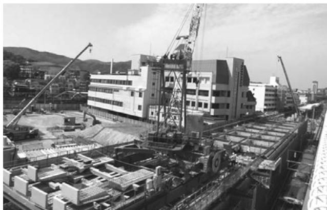
写真—3 HPca 架設状況
