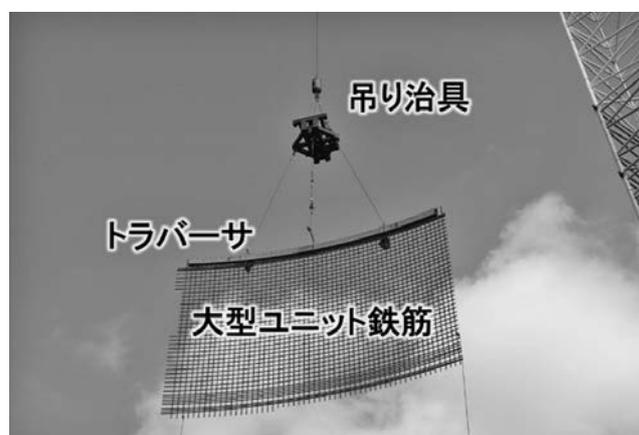
写真一3 大型ユニット鉄筋揚重状況
