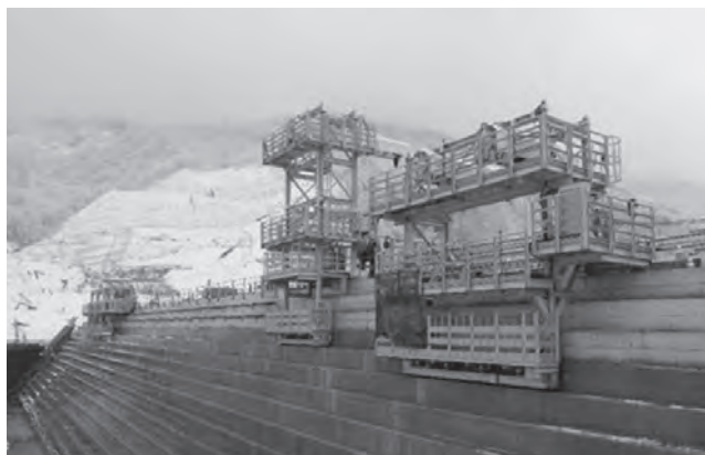
写真—3 置き型枠自動スライドシステム
