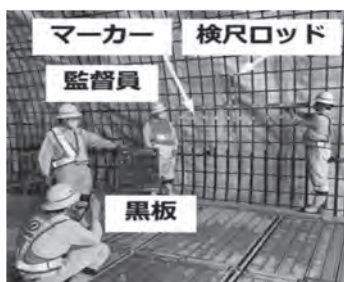
従来の配筋検査
