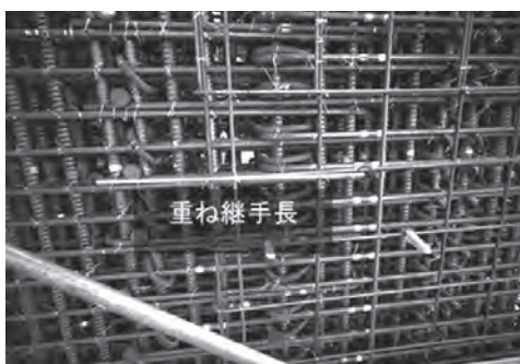
写真—6 重ね継手長さ計測状況
