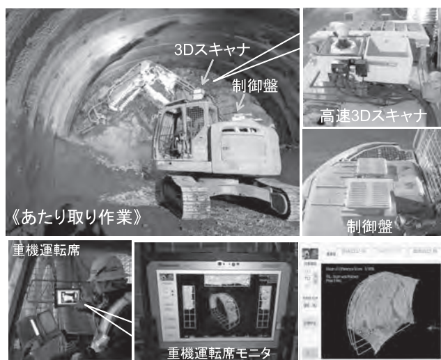
図—3 掘削形状モニタリングシステム
