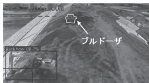
図ー10 カメラから150m離れた位置のブルドーザ
