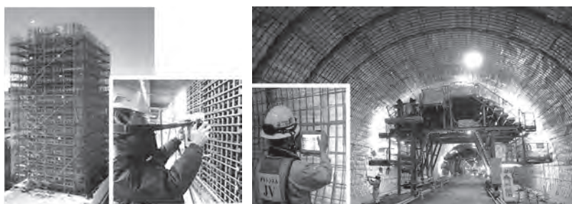
写真—11 検査状況（左：川崎臨港下部，右：音中トンネル）
