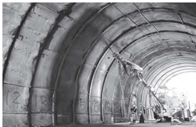
写真—4 模擬トンネルでの自動吹付け実験
