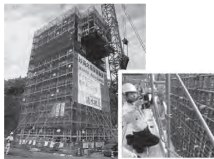
写真—9 検査状況（妙高大橋下部工事）
