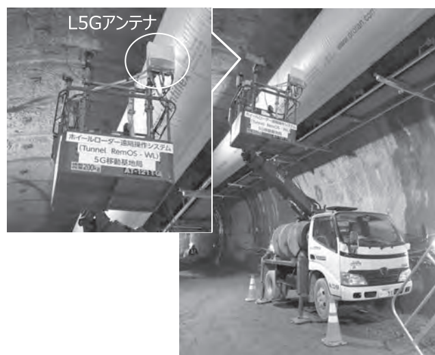
写真-4 映像・制御信号通信システム（坑内固定ユニット【L5G仕様】）
