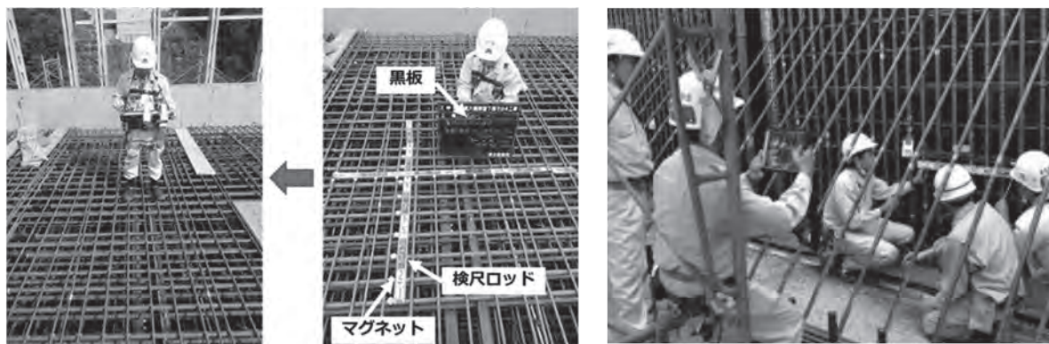
(a) 配筋検査比較（左：システム利用，右：従来）
