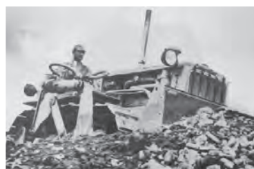
豊満ダムのブルドーザ
