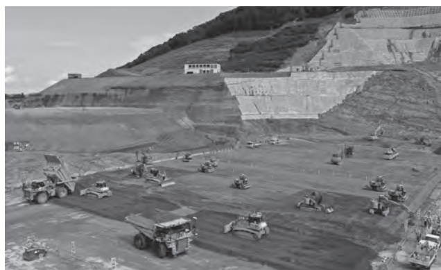
写真—1 A 4 CSELによる堤体自動打設 (成瀬ダム工事/東北地方整備局)
