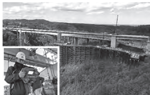
写真—10 検査状況（新思惟大橋上部工工事）
