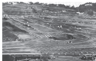
山口貯水池堤体敷の軌道網
