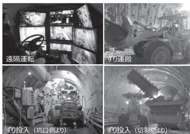
写真—5 トンネル坑内における遠隔操作実験状況
