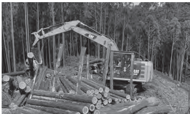
写真—1 幅広い現場で用いられる建設機械の例（バックホウ）
