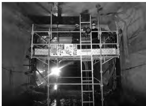
写真—9 製管機の組立状況
