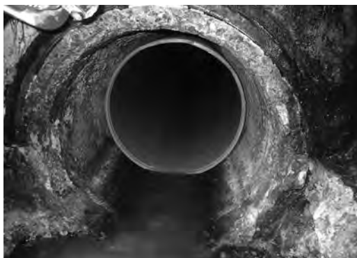
写真—6 製管状況
