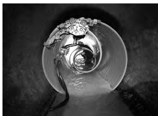
写真—14 製管状況
