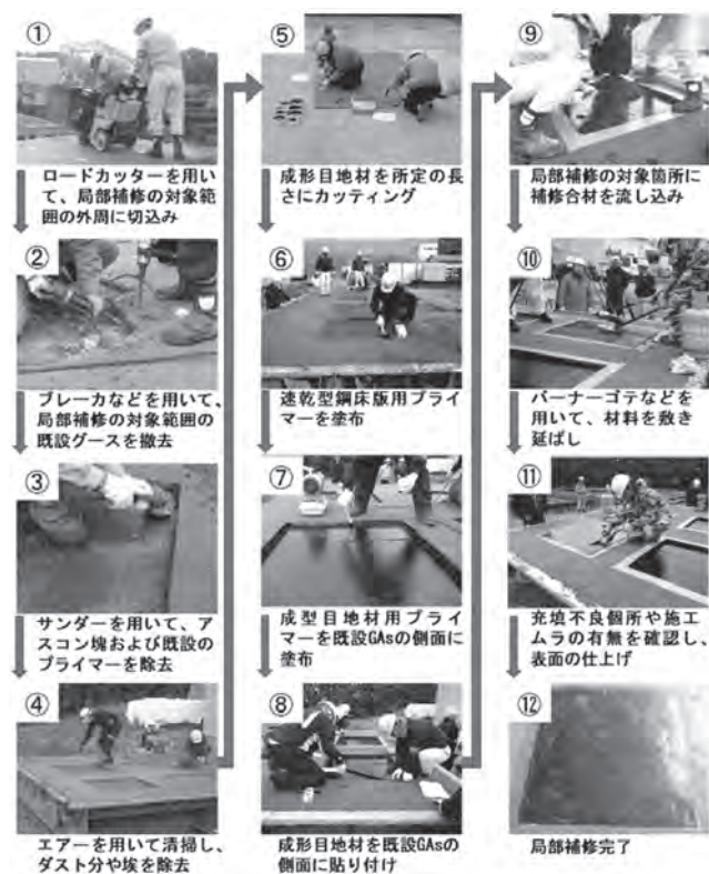
図—13 推奨仕様における局部補修の手順
