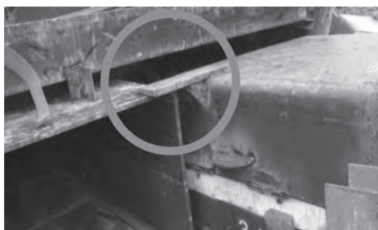
写真—10 ガイド板による推進（○の位置がガイド板）
