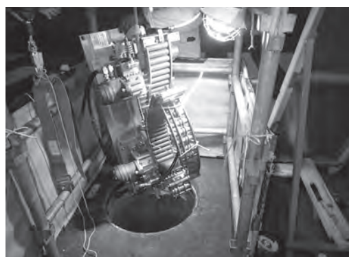
写真—4 製管機の吊り下ろし状況
