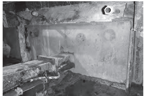
写真一 7 コンクリート充填完了 (ストラット支保工設置)
