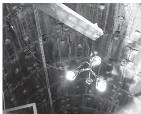
写真—7 撮影装置の降下状況
