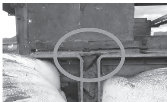
写真—10 ガイド板による推進（○の位置がガイド板）
