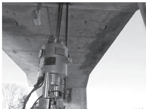
写真一6 カメラ点検装置
