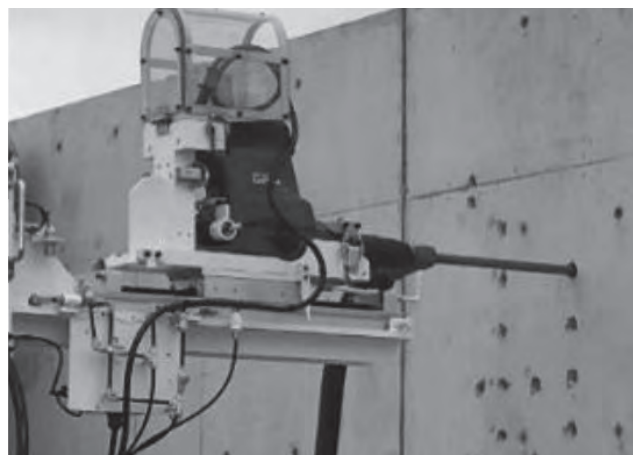
写真一 7 小径用自動削孔装置の実験状況
