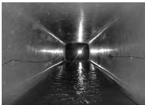
写真—10 製管完了
