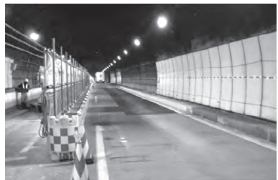
写真一 8 走行車線規制状況
