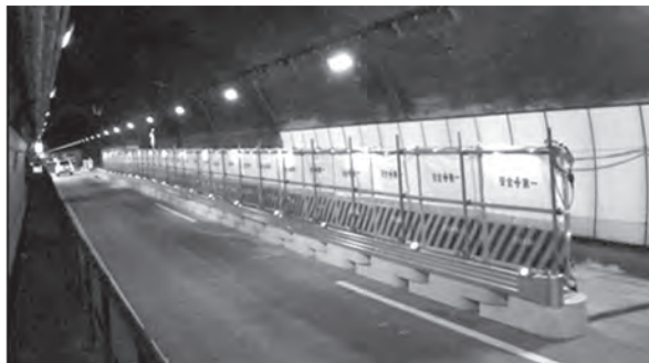
写真―1 車線規制状況（仮設ガードレール設置）
