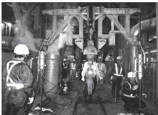
写真－14 装置固定式によるキブル用ワイヤロープの保守点検状況
