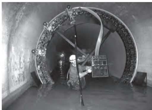
写真—2 供用下で施工状況
