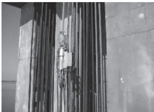
写真一2 当システムによる機械施工
