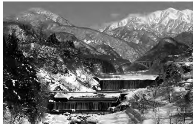
写真—6 本宮砂防堰堤 (貯砂量 500 万 m³)
