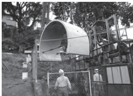
写真—1 プレキャスト部材坑内搬入状況
