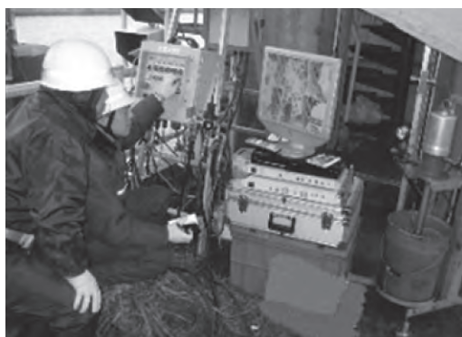
写真—8 モニター目視点検状況
