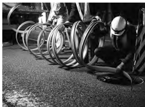
写真—13 プロファイルの送り込み状況
