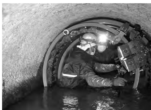
写真—12 製管状況
