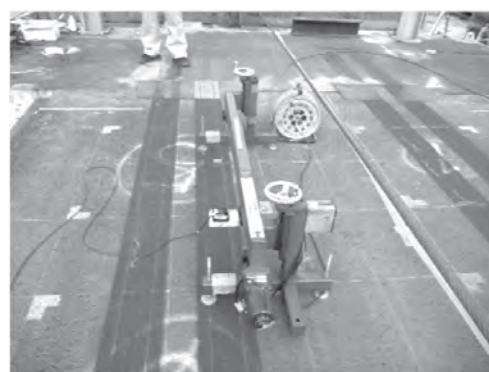
写真一 10 段差量の計測状況
