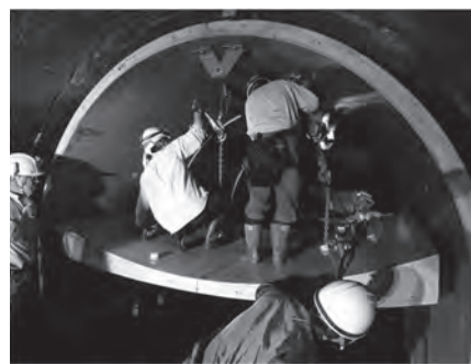
(c) レバーブロックによる底盤材の設置状況
