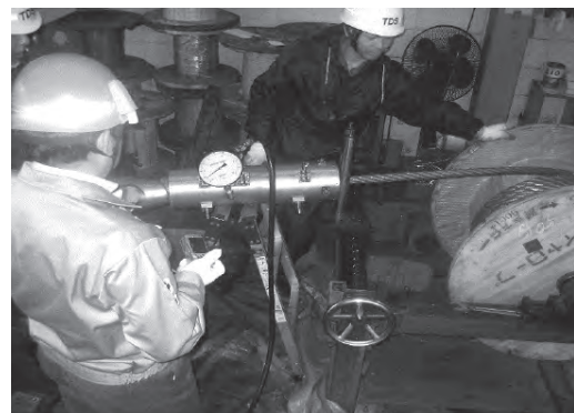
写真－16 新規ゲートワイヤロープへの給油状況
