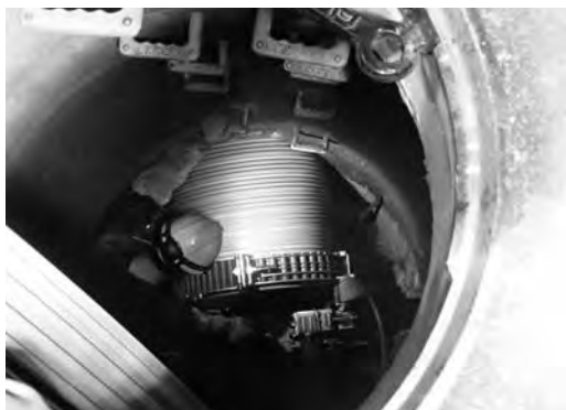
写真—5 マンホール内での製管機状況
