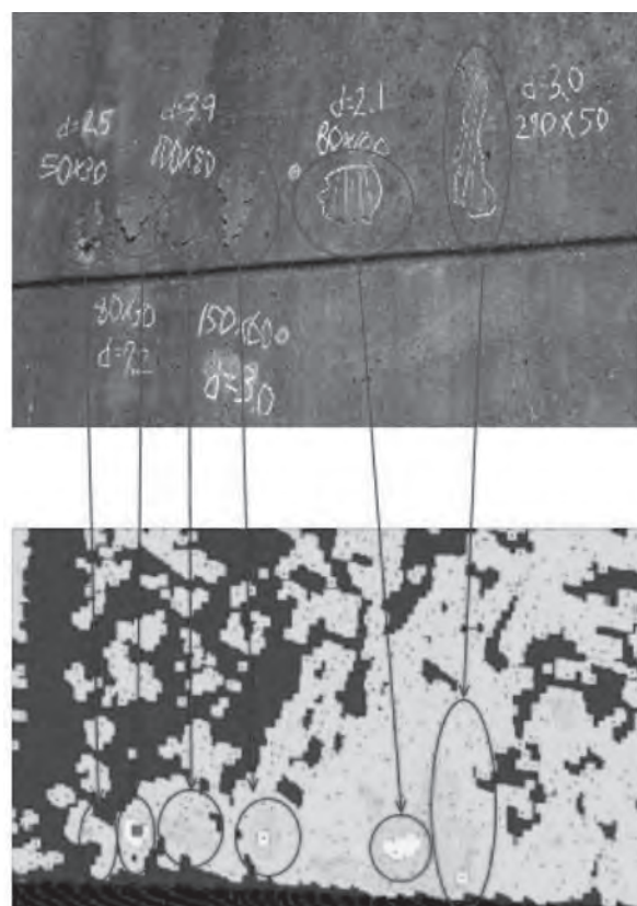
図—2 3次元点群データによる変状検出
