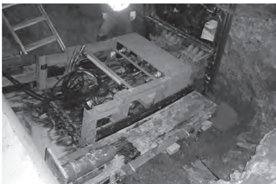
写真一 4 推進機設置状況
