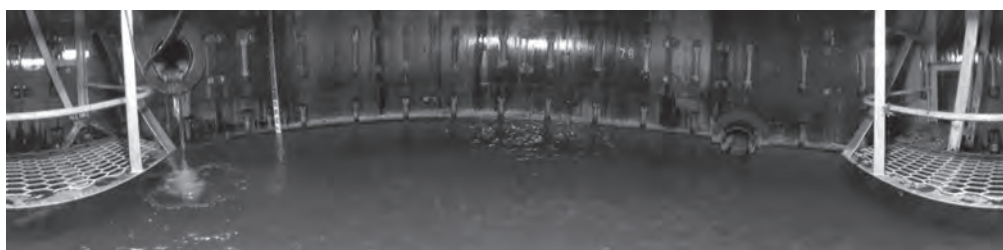
写真—8 全周撮影型カメラによる点検画像
