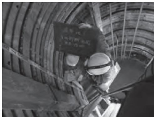
写真—1 集水井の点検状況（人が集水井内に直接侵入し点検する方法）
