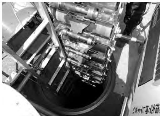
写真—8 製管の吊り下ろし状況
