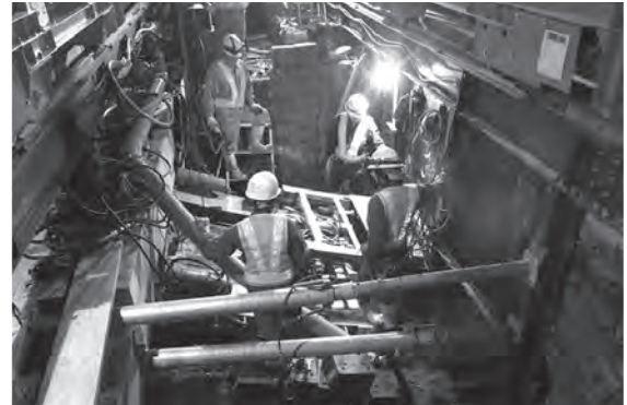
写真一 6 推進機引き抜き状況
