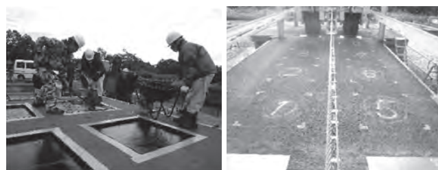
写真一 7 局部補修状況（左）・補修後の外観（右）
