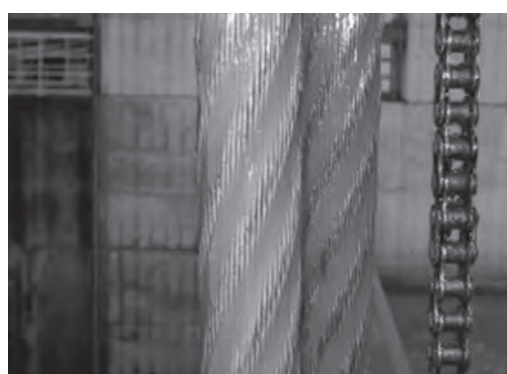
写真—12 給油仕上がり状況
