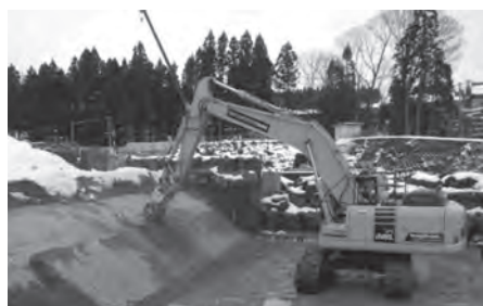
写真ー3 ICT建機による固定堰はつり状況
