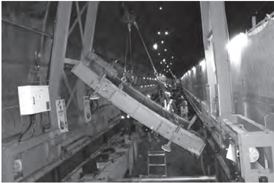
写真一 2 発進架台設置状況
