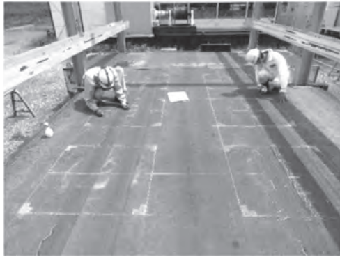
写真—11 ひび割れ調査状況
