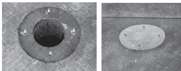
写真—2 カメラを挿入するための点検孔（左：開口時、右：閉口時）
