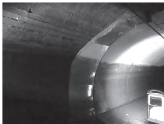
写真—7 内面補強区間での水位低下
