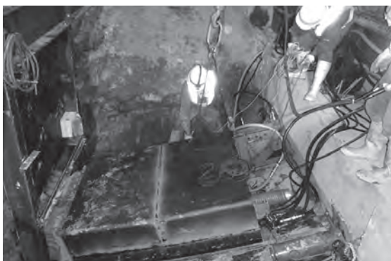
写真一 5 函体推進状況
