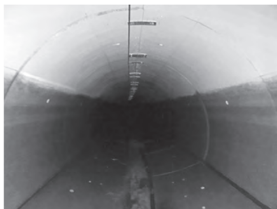
写真—6 1年経過後のプレキャスト内面補強工状況
