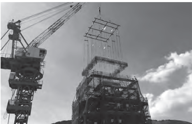
写真一七 帯鉄筋プレファブ化（ノップキャリアー工法）
