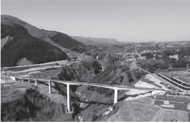
写真—11 開通した国道325号新阿蘇大橋
