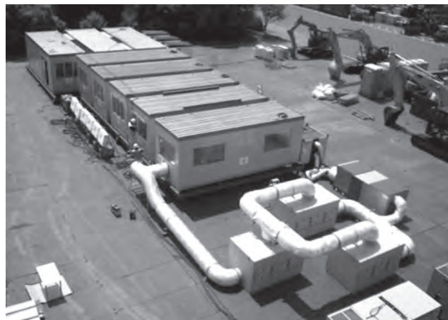
写真—1 休憩室の製作完了
