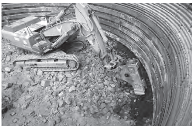
写真—5 大型掘削機（BH1.4 m³/3800 kg 級ブレーカ）
