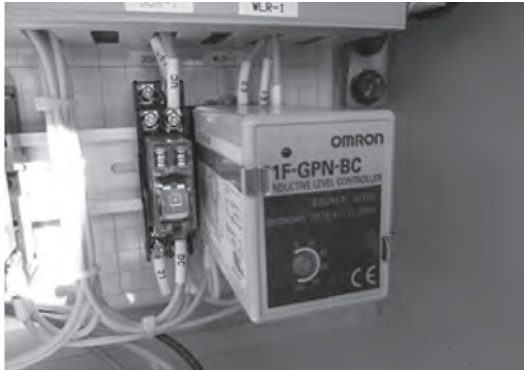
写真一六 遠隔装置のコントローラー類
