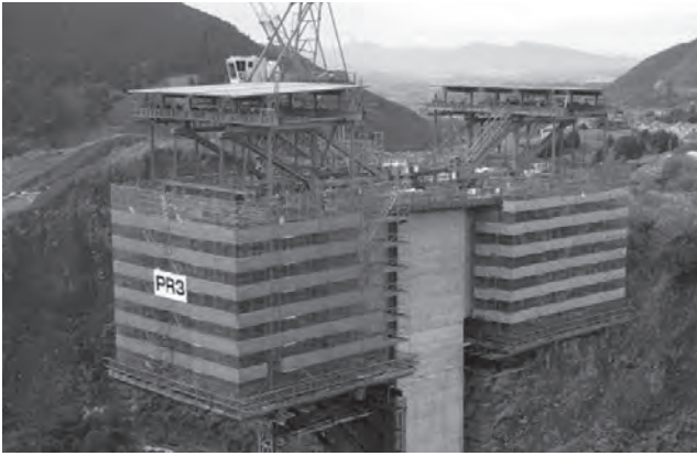
写真一八 超大型移動作業車による施工状況
