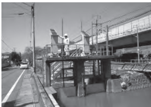
写真-1 水門開閉装置の外観
