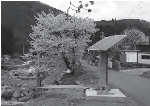
写真一八 本事例の設置状況
