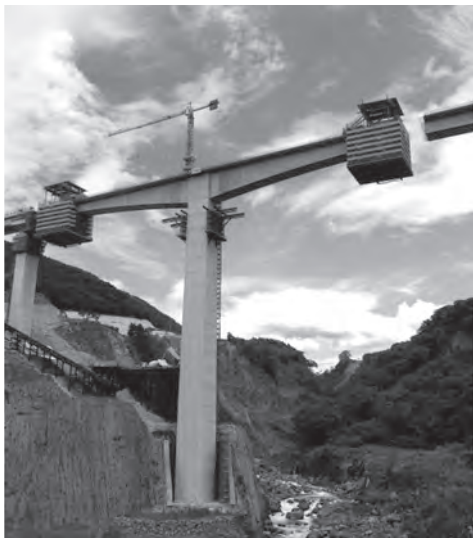
写真一九 張出架設、終盤施工状況
