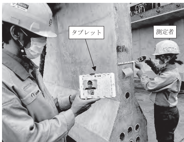
写真-1 「遠検」を利用した立会状況（現場）
