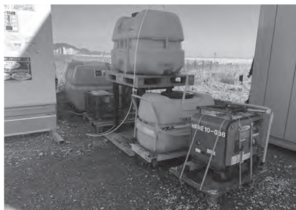
写真—2 工事現場での利用写真 (海水を真水にろ過し、簡易水道として利用)
