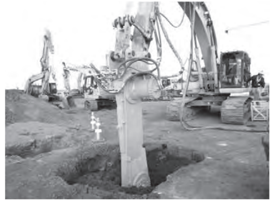
写真一3 透水性改良体造成状況
