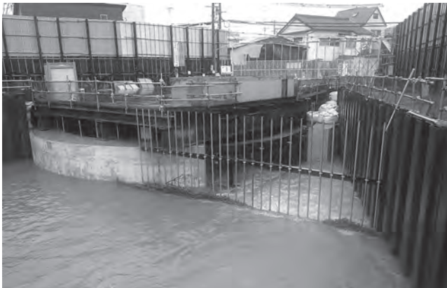
写真一 3 地下河川流入状況
