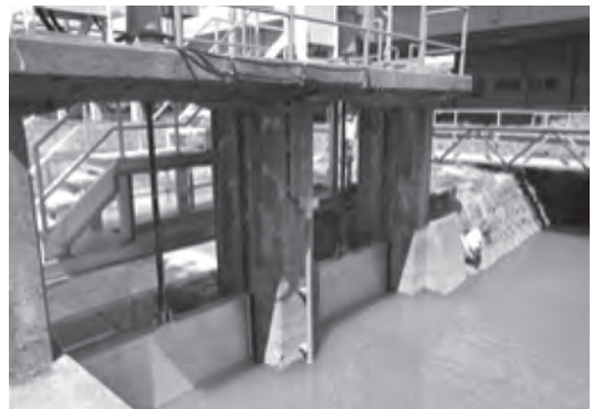
写真—4 巻き上げ中の水門扉
