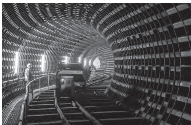
写真—1 4連続急曲線 (IP.10~13 : R=20m, 18m, 20m, 20m)
