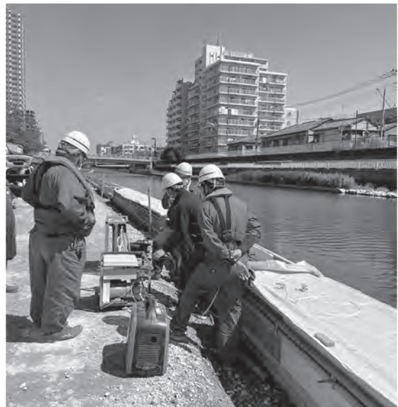
写真一3 某所工事現場での利用写真 (コンクリート養生水確保)
