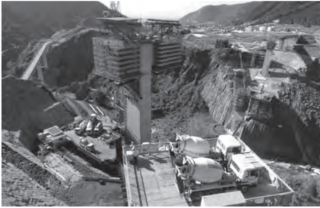
写真一 1 インクラインによる施工状況
