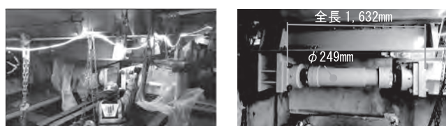
(d) 設置作業状況 (e) 設置完了状況（詳細）
