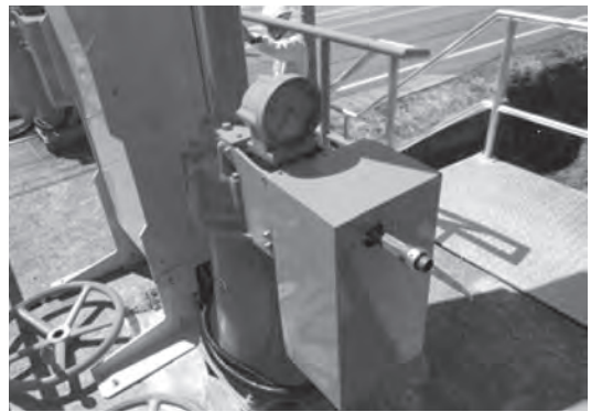
写真—3 動力機構を内蔵した巻き上げ機
