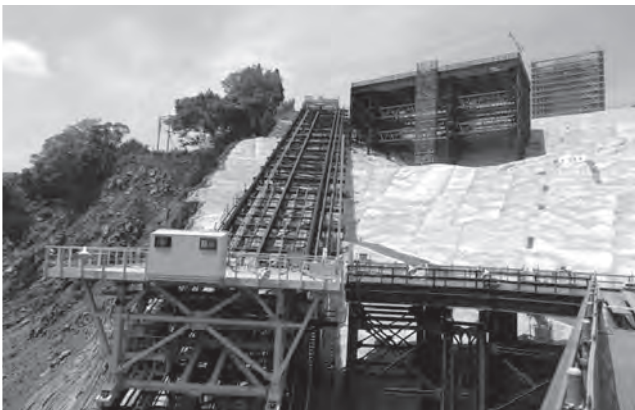
写真一 3 インクライン第三軌条方式
