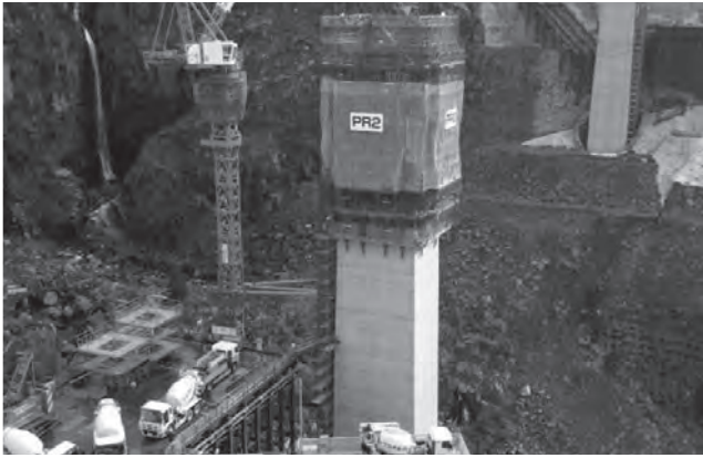
写真一六 ACSによる橋脚施工状況
