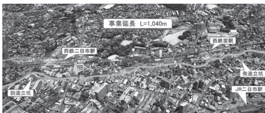
図-1 高尾川床上浸水対策特別緊急事業区間の状況
