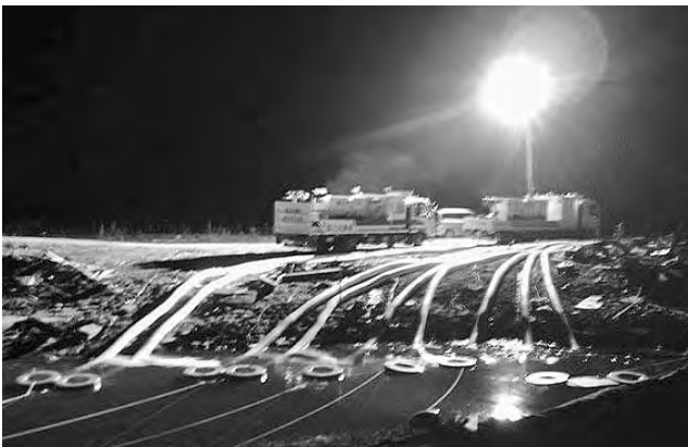
写真—1 夜間の排水作業状況（国土交通省資料より）
