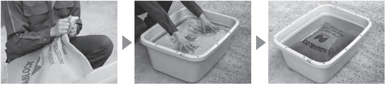
写真—8 吸水性土のうの製作手順
