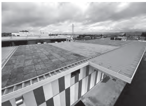
写真-2 食品倉庫コケボード施工
