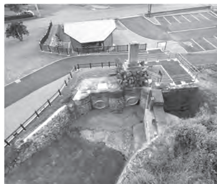
写真—1 整備後の宿布発電所跡公園
