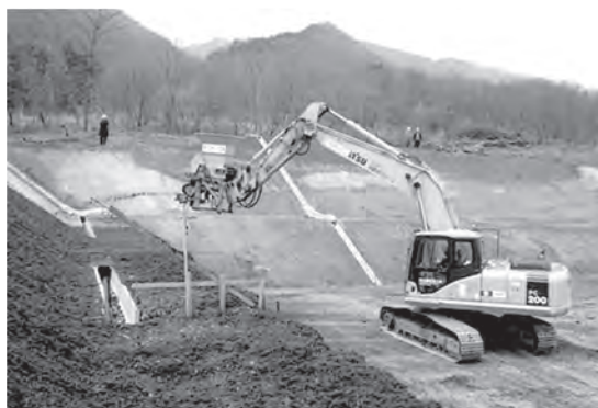
写真-3 標準施工システムによる施工状況
