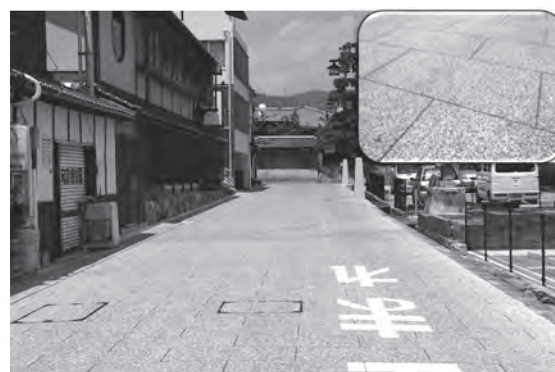
写真—2 疑似平板風舗装の施工例
