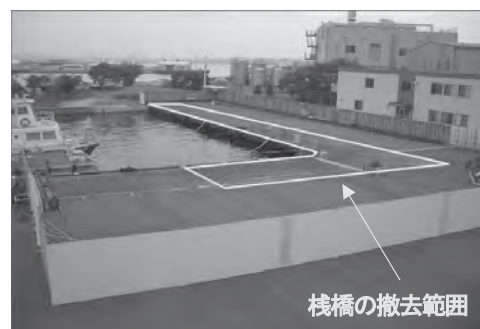
写真—2 施工前の様子
