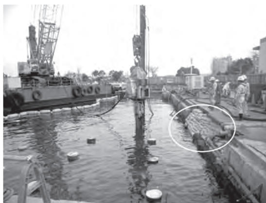
写真—3 既設杭引き作業の状況
