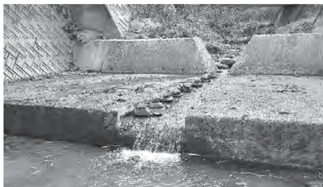
図—4 切欠き魚道の完成
