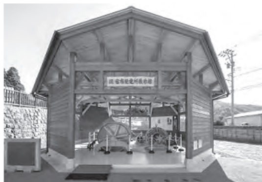
写真—2 展示館の水車・発電機設備
