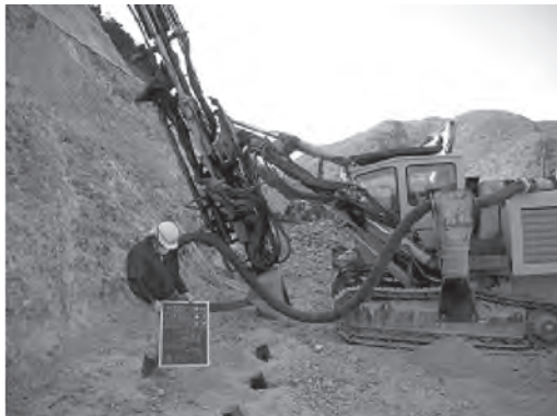
A 岩盤法面整形工法「特殊楔型チゼル」 写真—4 特殊楔型チゼルセット状況
