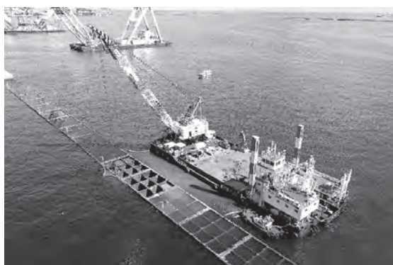
写真—4 養浜砂（中詰砂）撤去
