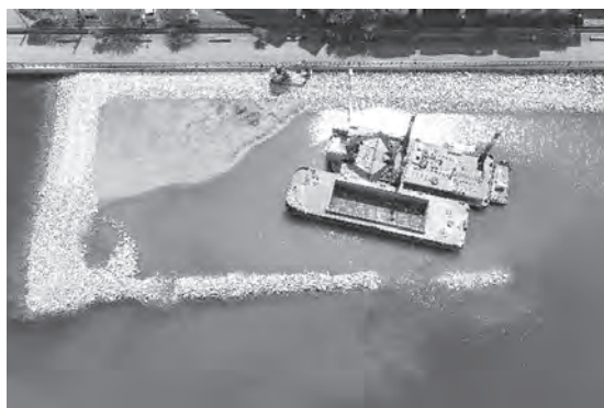
写真—8 狭隘条件による片押施工
