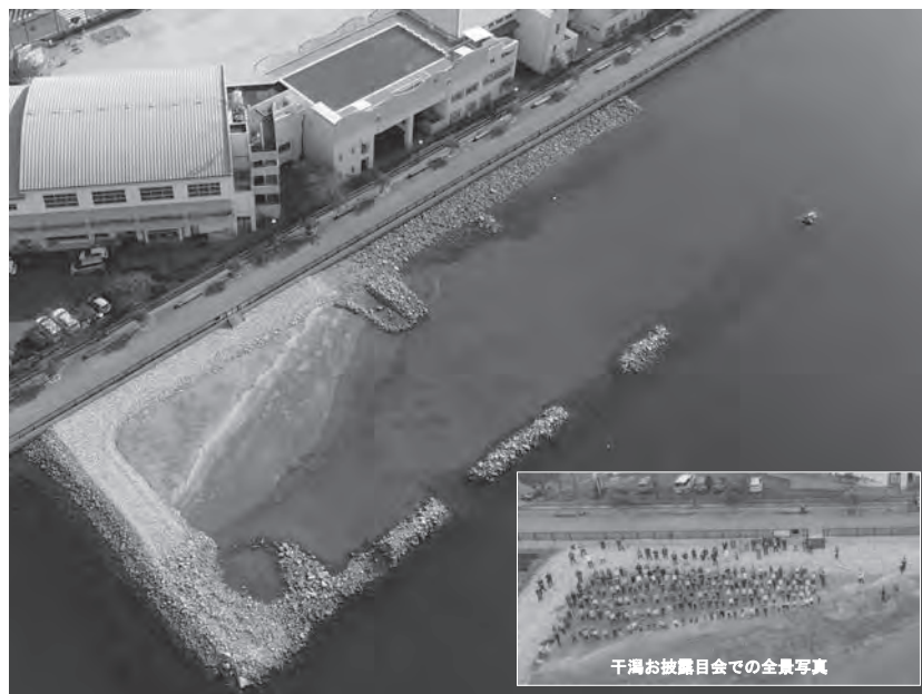
写真—10 完成した兵庫運河干潟の全景《干潮時》
