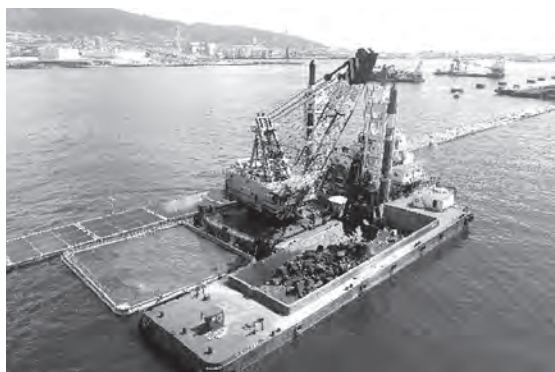
写真—3 基礎捨石（流用石材）撤去
