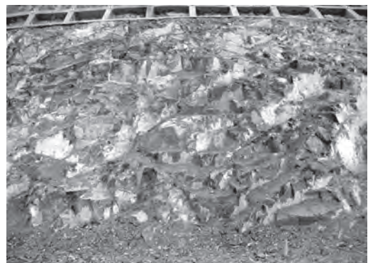
写真—1 従来工法による法面整形の仕上がり状況
