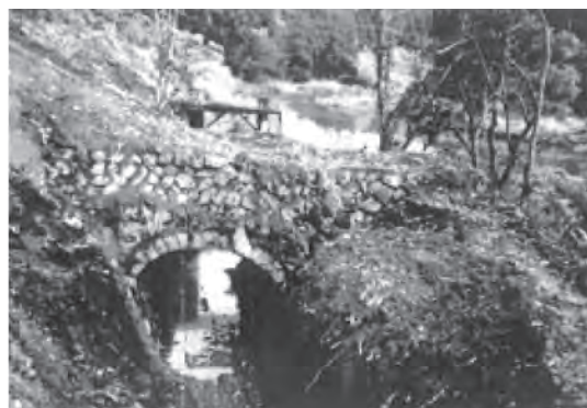
写真—3 当時の宿布発電所導水路
