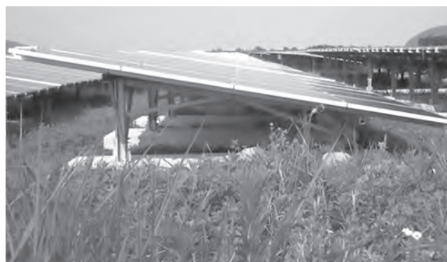
写真ー3 みどりを残して設置された太陽光パネル
