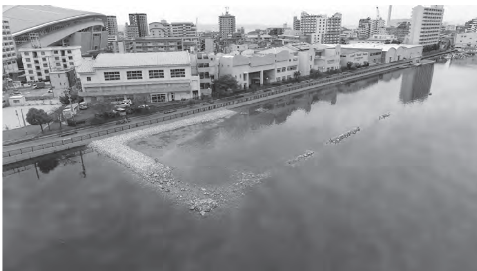
写真—11 完成した兵庫運河干潟の全景《満潮時》
