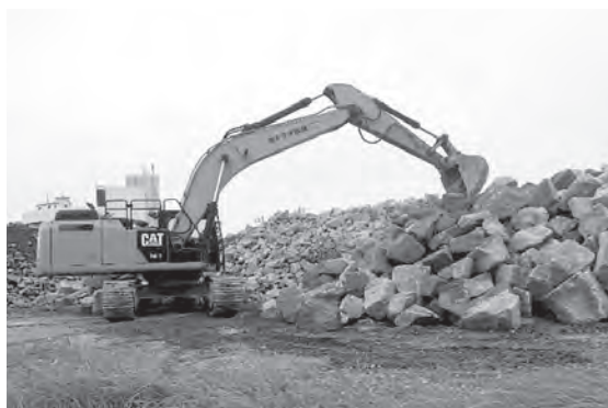
写真—5 仮置ヤードでの材料選別
