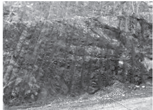
写真—7 法面仕上がり状況(B工法)
