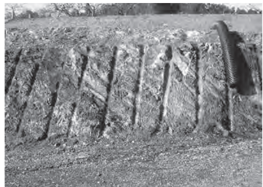
写真—9 法面仕上がり状況(B工法)
