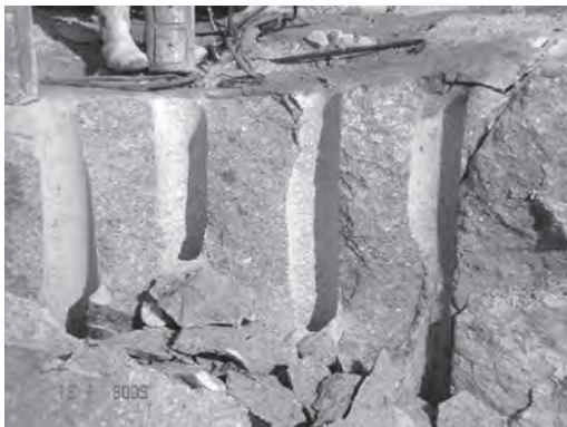
B 岩盤法面景観工法「油圧式割岩装置(V4)」 写真—5 油圧式割岩装置(V4)割岩状況
