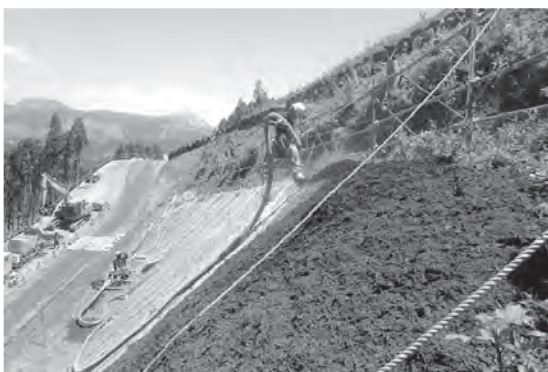
写真-4 ポンプ圧送方式による施工状況
