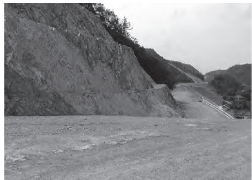
写真—8 法面仕上がり状況(A工法)
