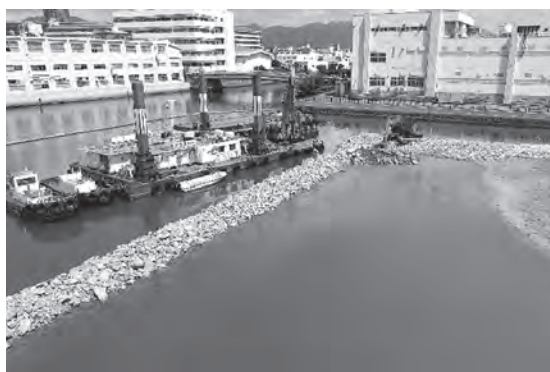
写真—7 流用材投入・外縁部傾斜堤構築
