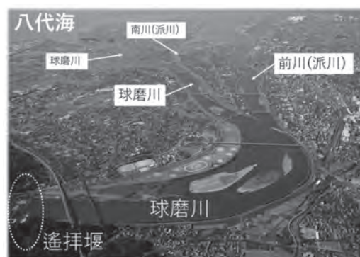
図—2 遙拝堰より下流付近
