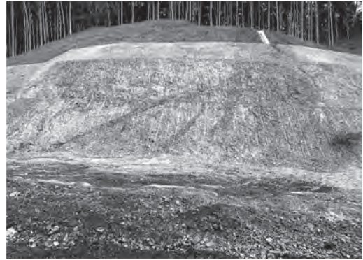
写真—6 法面仕上がり状況(A工法)
