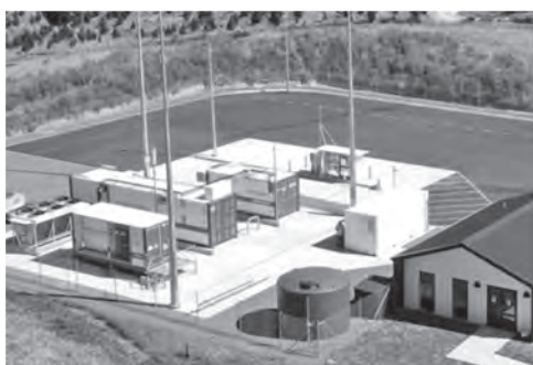
写真一 3 タウポのグリーン水素製造プラント
