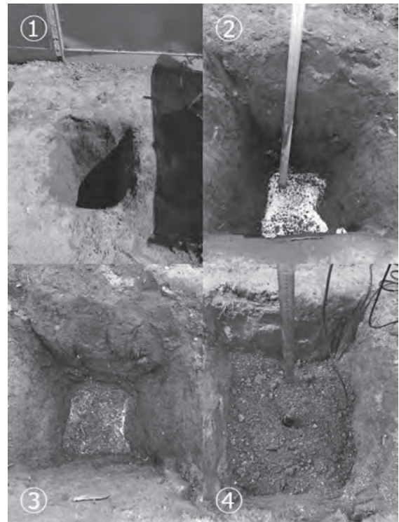
写真—3 屋外施工試験における工程
