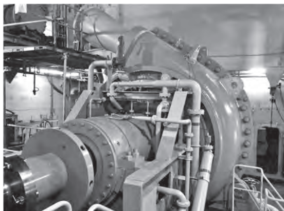
写真—3 浚渫ポンプ
