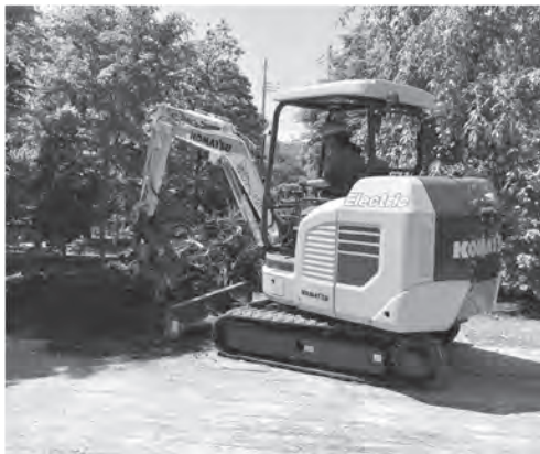
写真—4 作業現場での稼働風景
