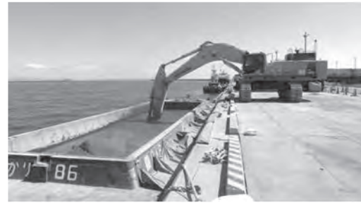
写真-1 バックホウ混合の施工状況
