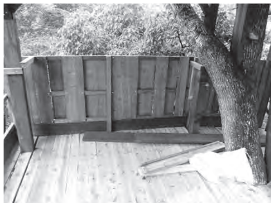
写真—5 完成した腰壁
