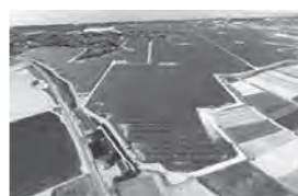
四ツ郷屋発電所 (新潟県新潟市)
