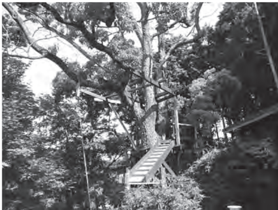
写真—3 土台にかけた木橋と床用の桁
