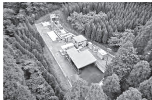
写真-2 グリーン水素製造プラント
