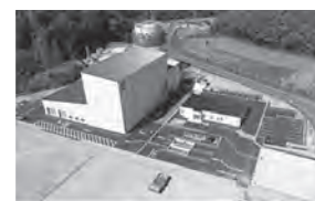
寄居バイオガスプラント (埼玉県大里郡寄居町)
