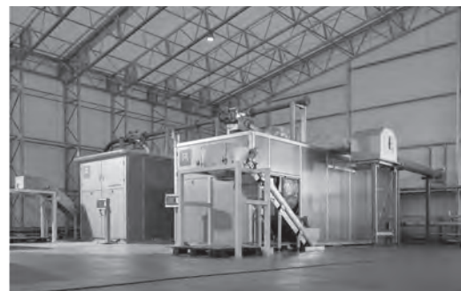
写真-1 プラズマ式イオン乾燥機全景 (RM22-16000型×2台、自動投入排出装置付)
