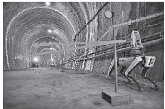
写真一11 後方交会状況
