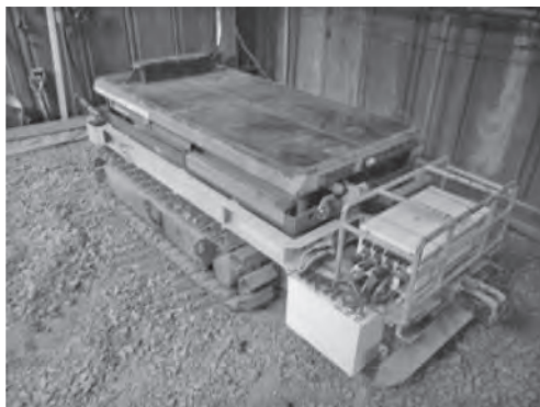
写真一 2 解体用ロボット (Carrying Robot)
