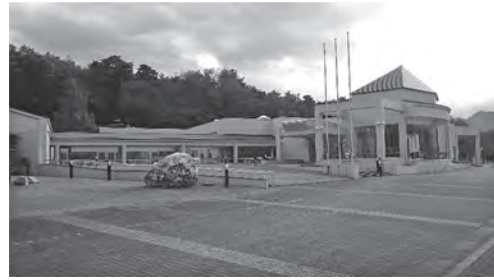
写真一九 ミュージアム全景
