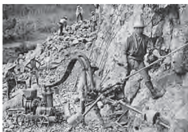
写真—9 明かり鑿岩機
