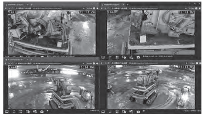
写真一 3 作業室内監視状況
