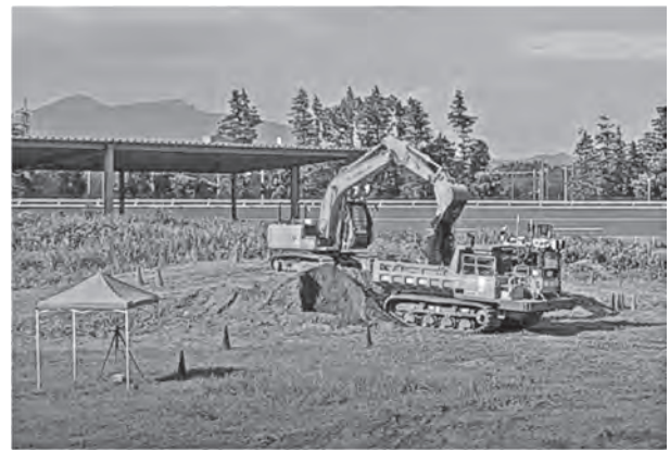
写真-2 自律施工のデモンストレーション
