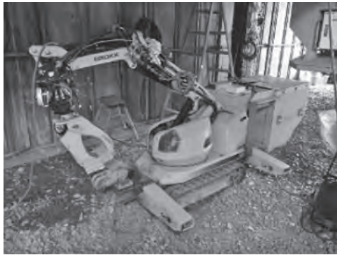
写真一 2 解体用ロボット (Working Robot)
