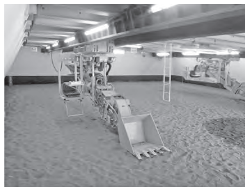
写真-1 ケーソンショベル
