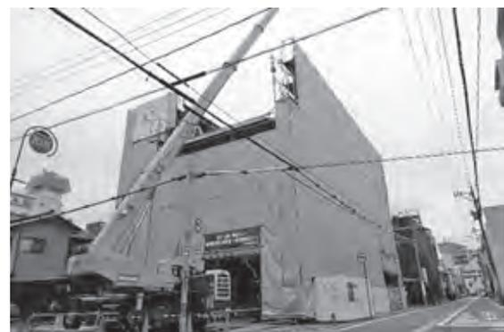
写真—11 70tクレーンによる木部材建方
