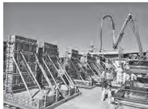
写真一2 コンクリート擁壁への適用事例
