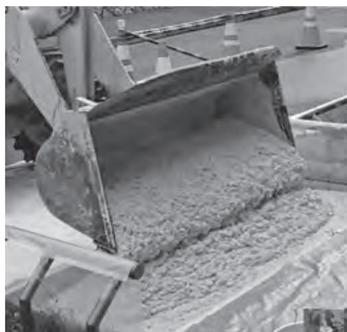
写真一3 鉄筋コンクリート舗装への適用
