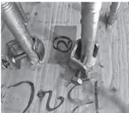
写真一六 ボルト貫通部のシール処理
