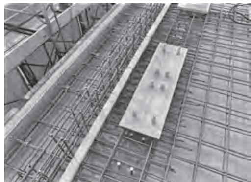
写真一七 テンプレートによる位置調整
