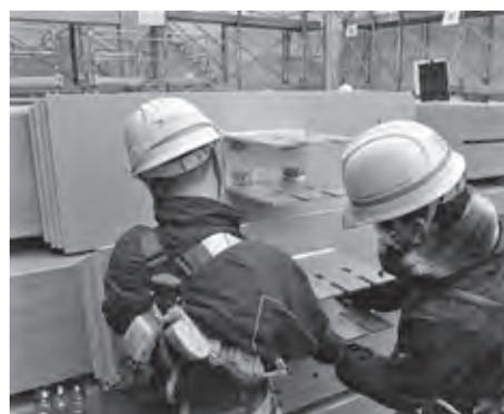
写真-16 木梁を横向きにした取付作業
