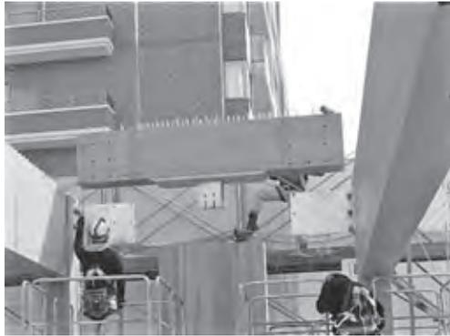
写真一七 木部材の耐火被覆は後施工
