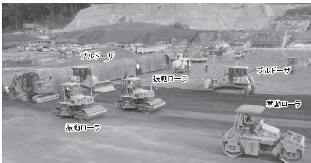
写真—1 ダム打設状況（台形 CSG ダム）
