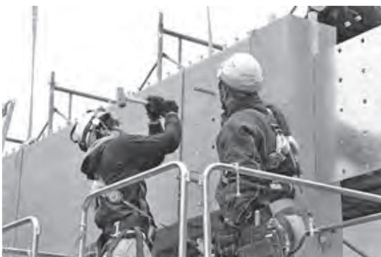
写真—9 仮設足場上でのドリフトピン打込み
