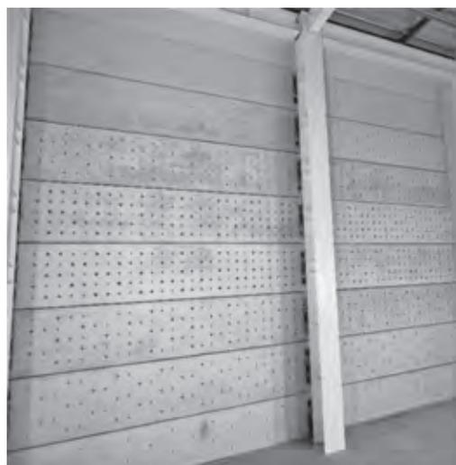
写真一2 鉄筋と鋼繊維を用いた壁部材への適用例
