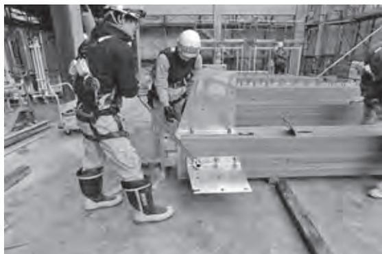
写真-12 通しボルトの出寸法合せ
