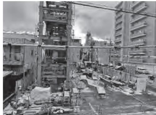
写真—10 50tクレーンによる鉄骨建方
