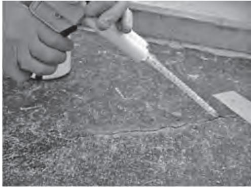
写真一 1 ひび割れ注入例
