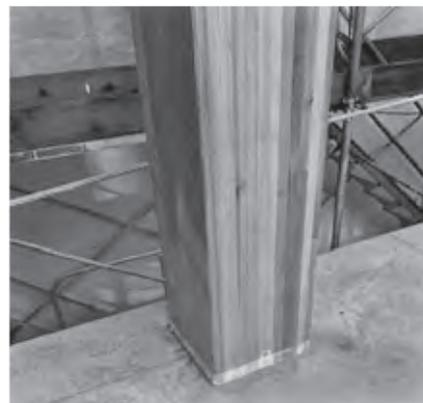
写真—4 撥水性塗料塗布状況
