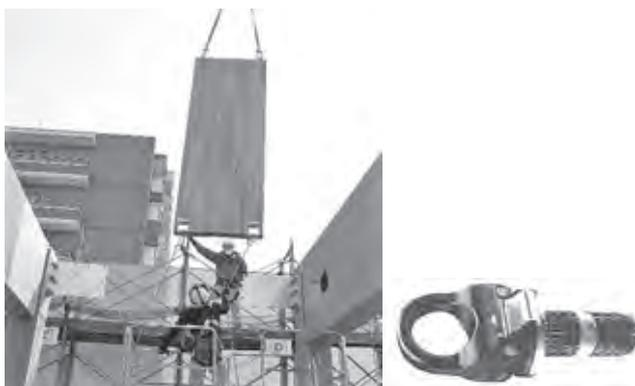
写真一八 パワークランプを用いた吊込み・木質材料吊り具
