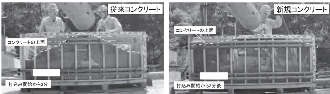
写真一三 酷暑期におけるコンクリートの打込みおよび締固めの状況
