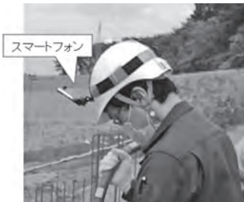
図-3 ウェアラブルカメラの設置状況
