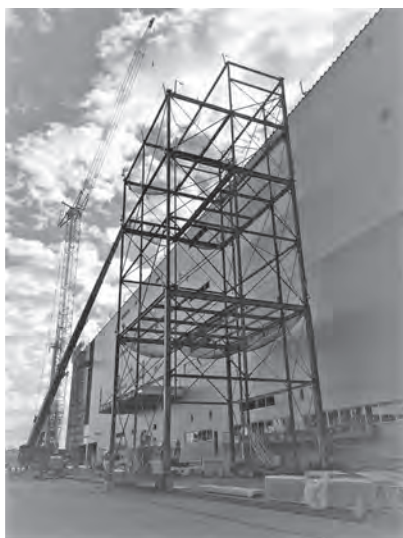
写真—1 移動足場全景
