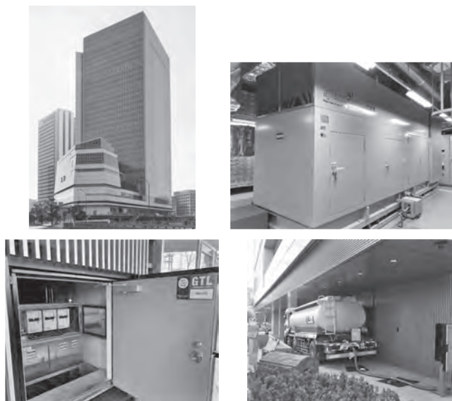
図一七 横浜市庁舎におけるGTL使用例 (左上：市庁舎外観, 右上：非常用発電機, 左下：GTL タンクの注油口, 右下：GTL 給油の様子)
