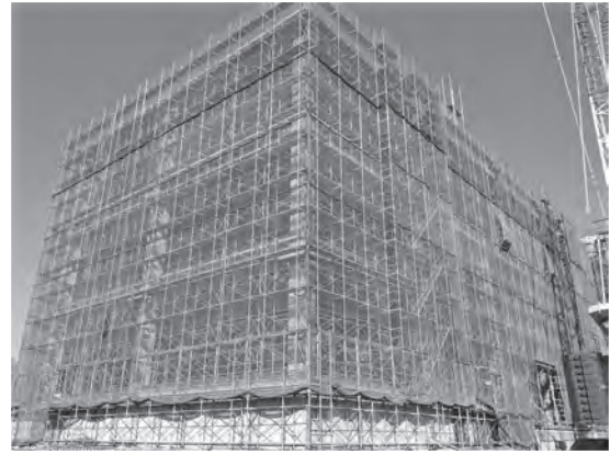
写真一3 本足場使用現場
