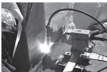
図一1 溶接施工状況
