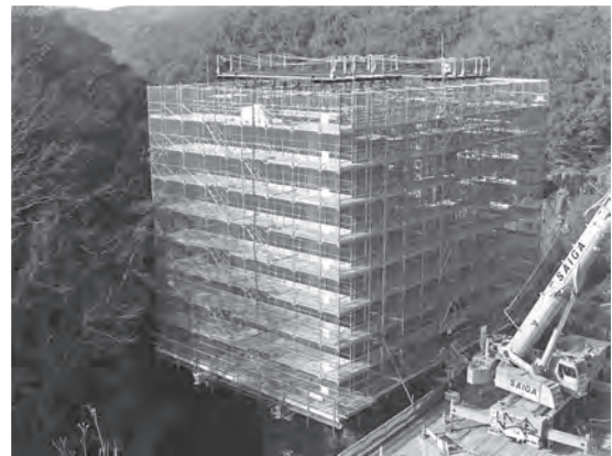
写真一4 本足場使用現場
