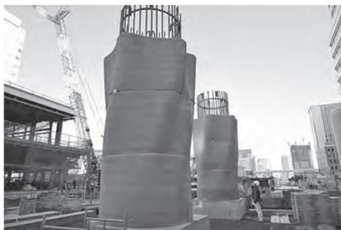
写真一七 コンクリート打込み直後の柱部材
