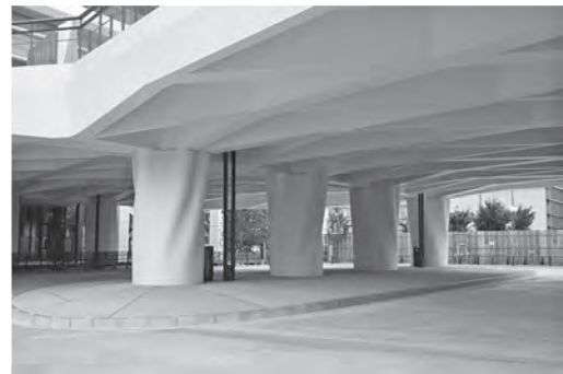
写真一九 デッキ施工後の全景
