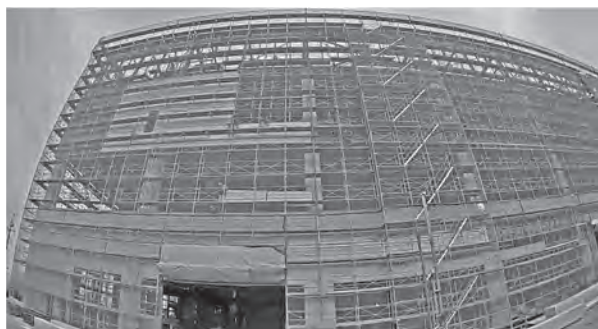
写真-2 在来足場での作業
