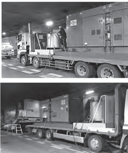
図一六 施工現場の様子 (上：軽油, 下：GTL)
