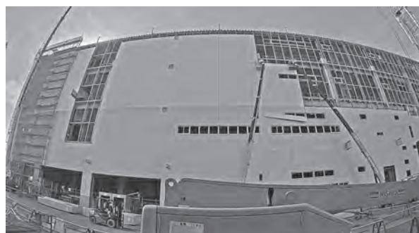
写真-3 高所作業車での作業
