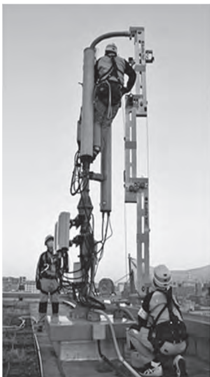
写真—1 施工イメージ
