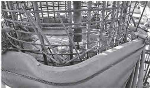
写真一六 プリント型枠へのコンクリート打込み
