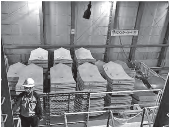
写真-8 セグメントストック状況
