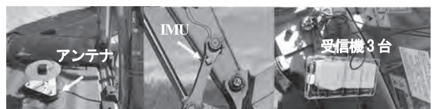
図-5 バックホウにセンサー取り付け
