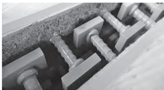
写真一 1 PCa床版の継手構造
