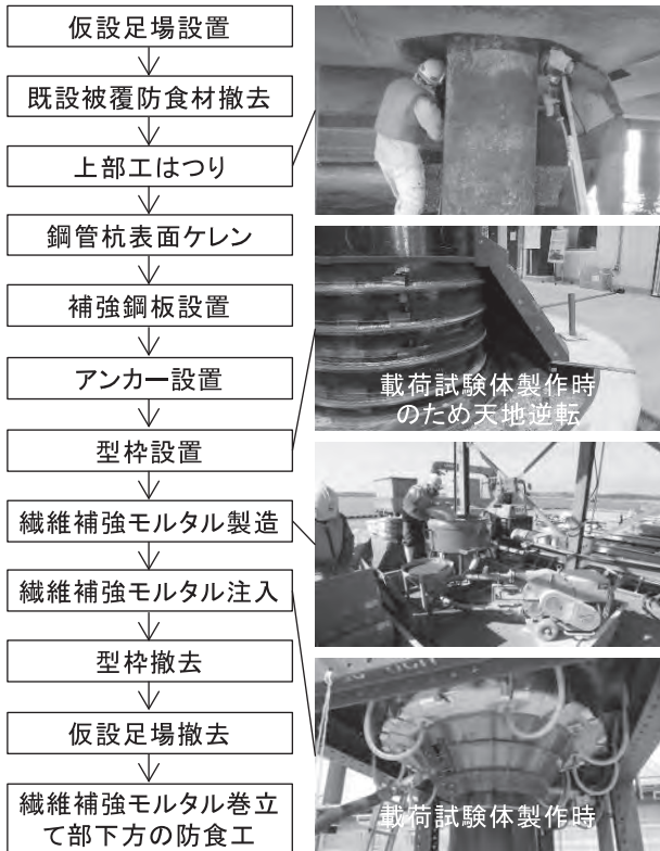
図-4 施工フロー
