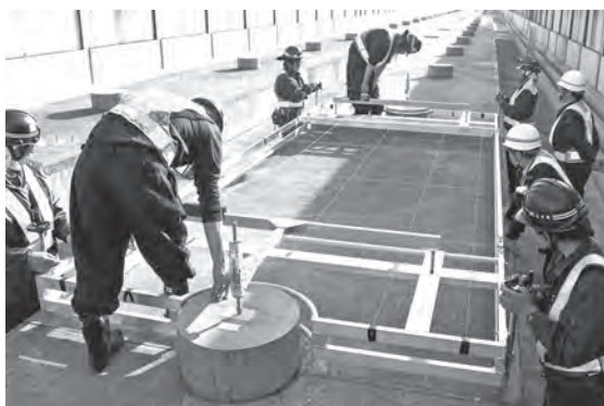
写真一5 従来の路盤調査方法（治具による確認）
