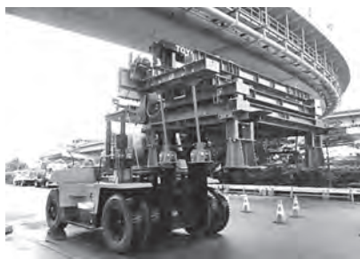
写真一七 フォークリフトに取付けた床版心出し装置
