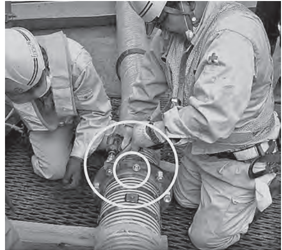
写真—8 ホース貫通型フランジを連結！
