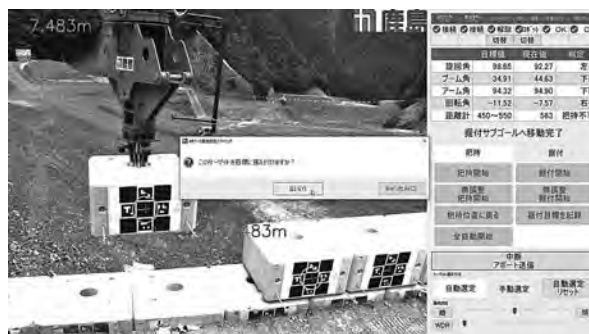
写真一8 操作画面(据付動作中)
