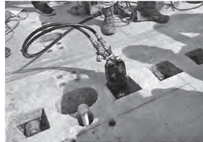
写真-13 PS ジョイント締付状況
