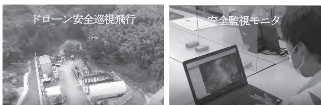
図-2 システム運用状況
