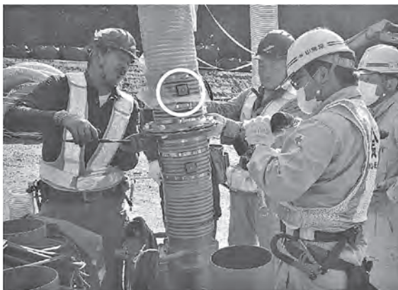
写真—7 ホース貫通型フランジ同士を連結
