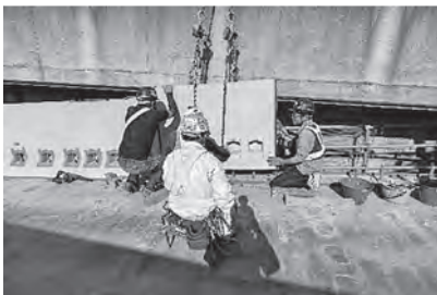
写真-14 PCa 壁高欄設置
