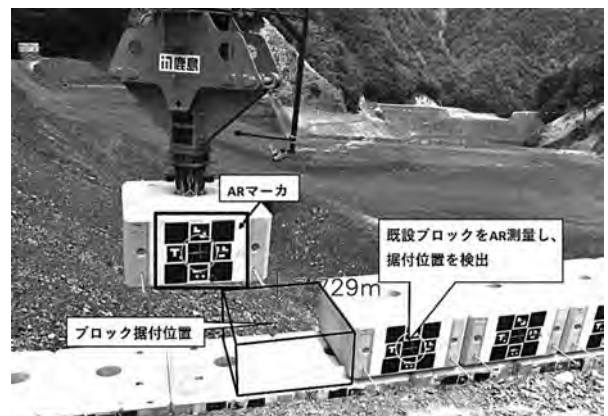
写真一3 自動据付状況
