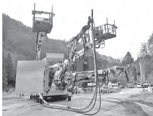
図-2 Smart Lining System™対応エレクター体吹付け機
