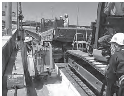
写真一2 既設壁高欄撤去状況
