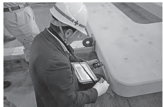
写真一6 軌道スラブタグ読み取り状況
