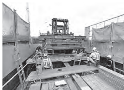
写真一八 床版架設状況
