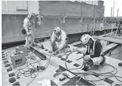
写真-13 PS ジョイント締付状況
