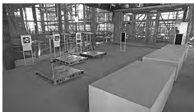
写真一7 実証時のストックヤード階状況
