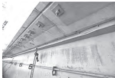
写真-15 床版下面の固定状況
