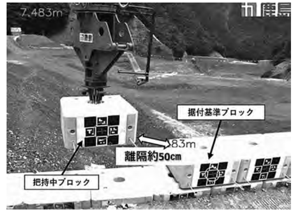
写真-11 自動据付サブゴール位置
