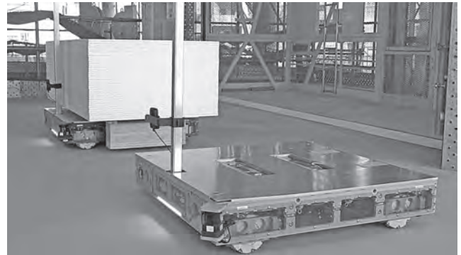
写真—4 エレベーター前でのAGVすれ違い状況
