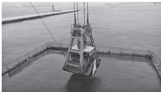
写真一六 カルシア改質土投入状況
