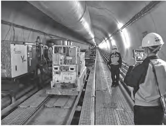
写真一六 Live 映像配信状況（シールドトンネル坑内）
