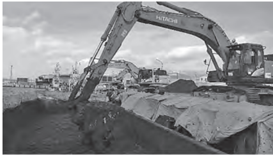
写真一五 カルシア改質土混合状況
