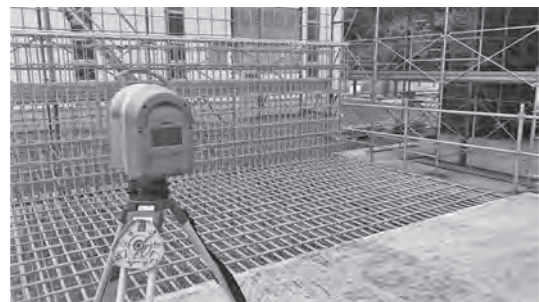
写真—4 レーザースキャナによる計測状況
