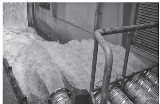
写真－5 Φ200 mm 6条配管の放流状況
