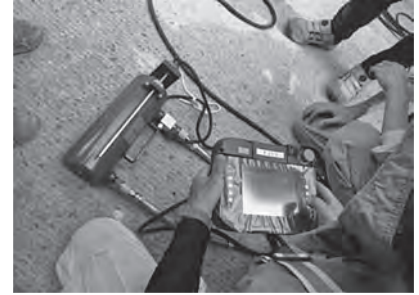
写真-12 引寄せジャッキシステム
