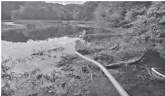
写真—10 サイフォン放流により低水位とする
