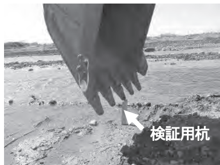
図-16 バケット刃先座標の検証
