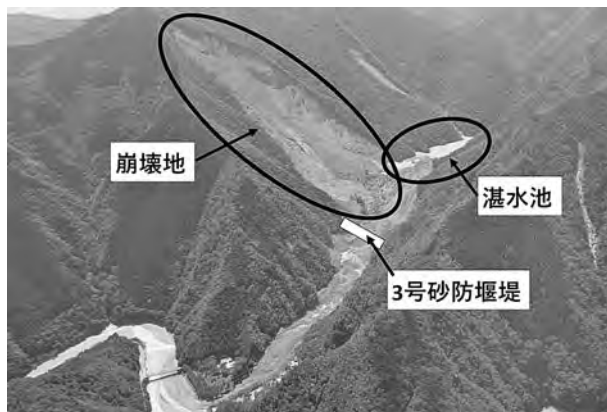
写真—1 災害発生直後の状況と堰堤施工場所
