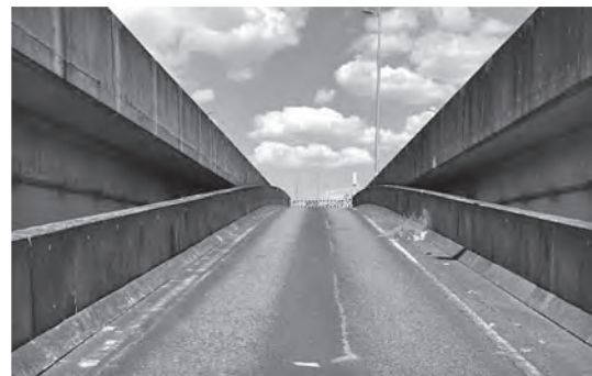
写真-1 対象橋梁の現況
