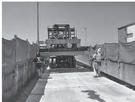
写真-6 撤去床版運搬状況
