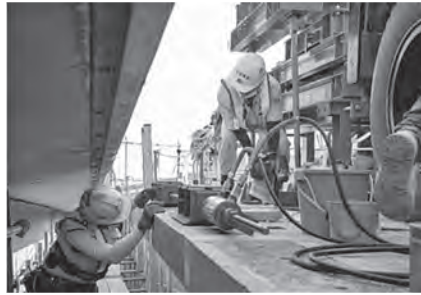
写真-11 床版引寄せ状況
