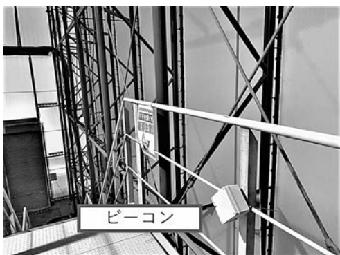
図-9 ビーコン設置の様子
