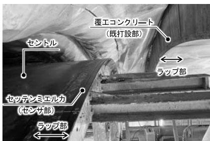
写真-1 セッテンミエルカ設置状況
