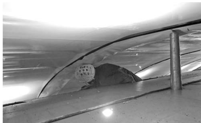
図-2 LED 照明によって明るく照らされた打設空間
