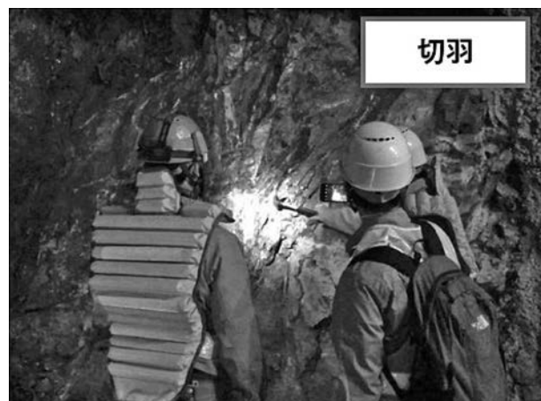
図-7 ハンマーの打撃状況
