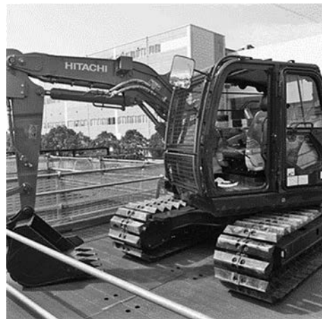
写真-2 使用建設機械 2
