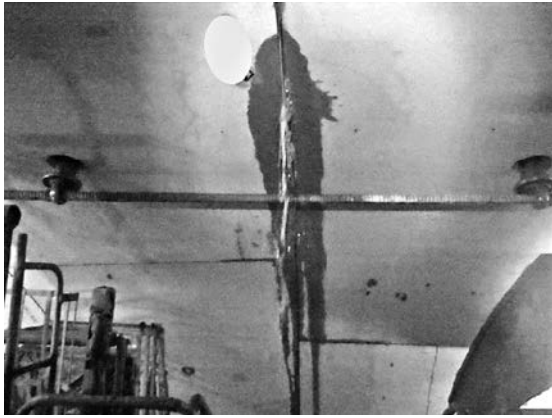
写真一 2 Kセグメントの抜き出し状況
