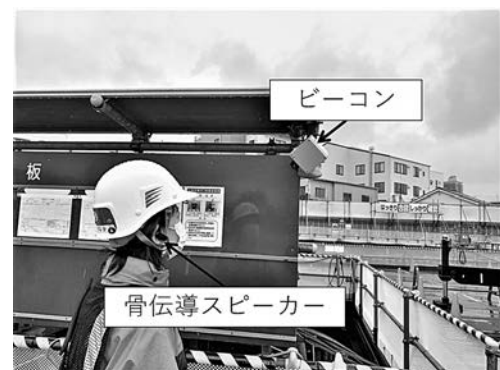
図-10 都市土木工事現場での使用例
