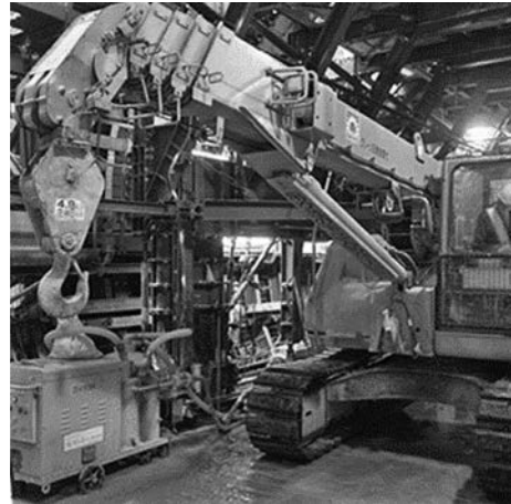
写真-1 使用建設機械 1
