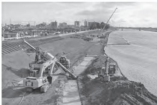
写真—6 庄内川（左岸側）の施工状況
