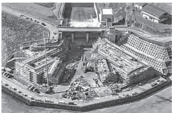
写真一九 流入部 躯体構築3年目 (R2年度)
