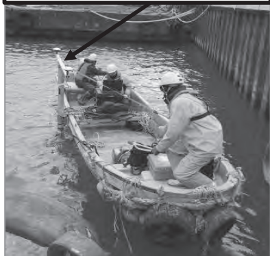
写真—1 測量船による深浅測量状況
