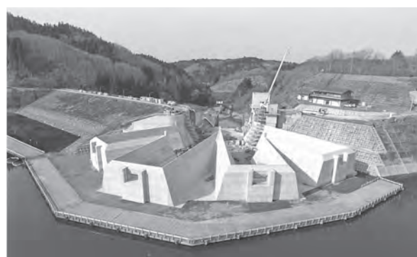
写真一三 流入部 躯体構築4年目 ラビリンス堰完成
