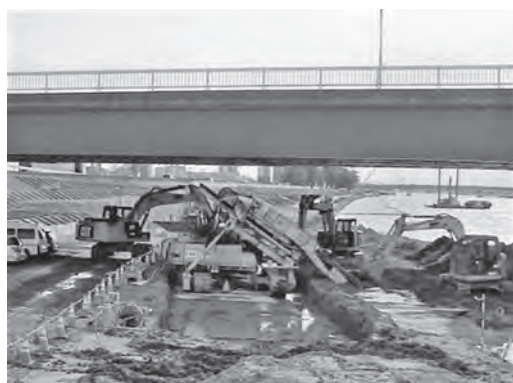
写真—7 大当郎橋桁下の施工状況
