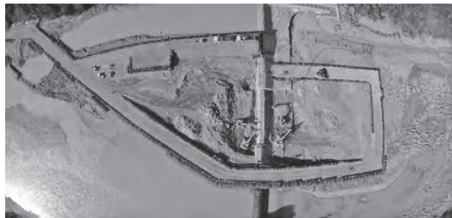
写真—11 仮締切設置（平成27年11月）
