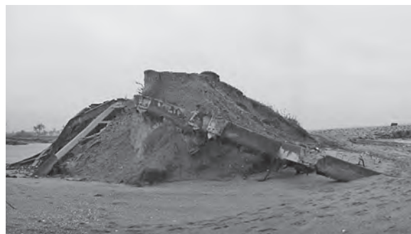
写真—2 津波・越波で破壊した堤防
