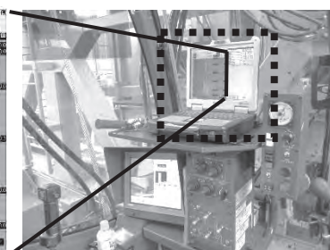
写真-2 運転席モニター設置状況
