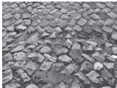
写真—3 既設石張
