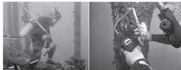
写真一2 高圧ジェットを使用した清掃 4) ・肉厚測定 5)
