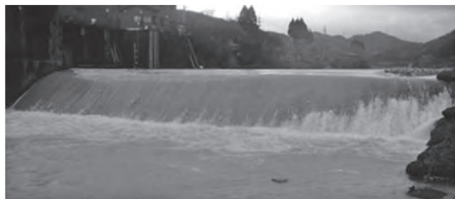
写真—4 白滝発生状況 (上流の土堰堤の影響で越流水位が低い位置のみ白滝が発生している。)
