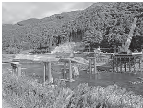
写真一2 復旧工事状況
