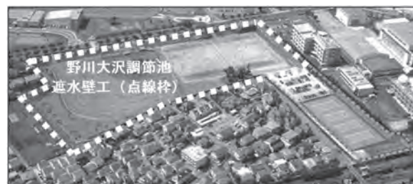
掘込式調節池の例(野川大沢調節池)
