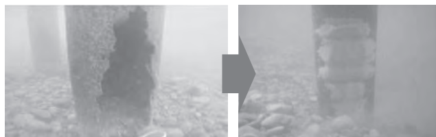
写真－5 併せて断面欠損部はグラウトを注入し応急対策
