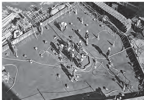
写真—3 浮上り防止筋施工状況
