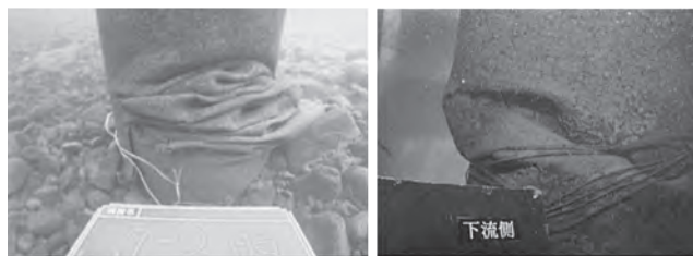
写真－4 全ての橋脚を調査
