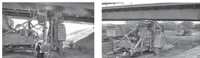
写真—5 橋梁下での低空頭施工機械
