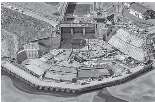
写真一七 流入部 躯体構築1年目 (H30年度)
