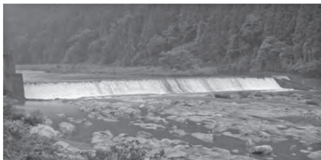
写真—2 改修前の白滝発生状況
