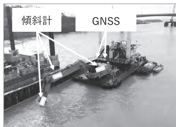
写真—2 バックホウ浚渫船の掘削工事状況
