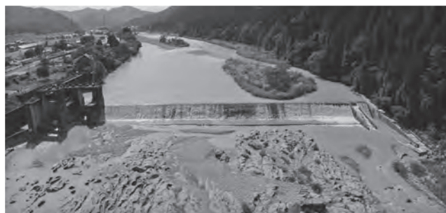
写真—1 改修前（平成 26 年 9 月）
