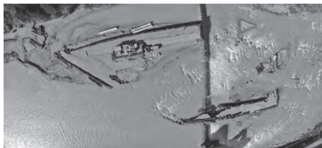
写真—12 仮締切破堤（平成27年12月）
