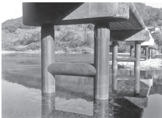
写真－3 鋼製当て板工法の採用
