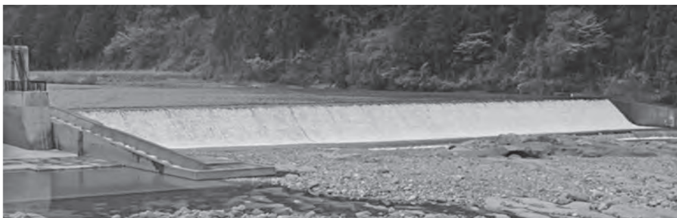
写真—10 完成（令和2年6月）
