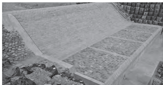
写真一8 石張完了写真
