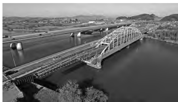
写真—1 架設桁を用いた橋梁の解体事例
