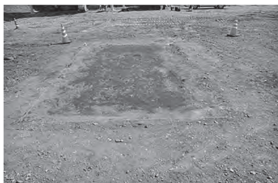
写真二 埋設管設置完了状況
