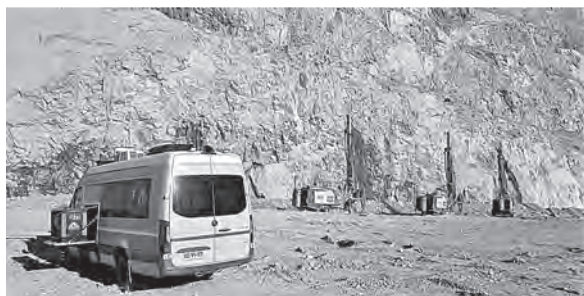
写真-2 1人のオペレーターによる複数台遠隔操作 黄色のバンの中にベンチリモート設置
