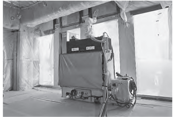
写真一4 耐火被覆取付ロボット
