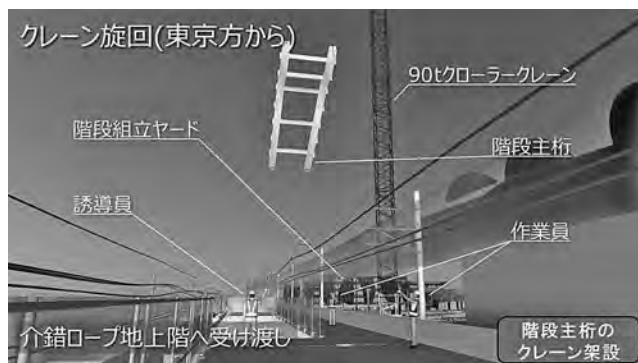
図一四 階段主桁のクレーン架設動画
