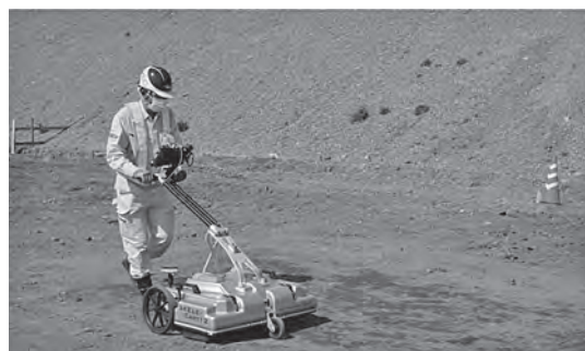
写真三 地中探査の実施状況
