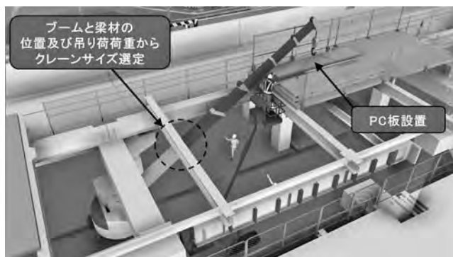
図一 狭隘箇所における重機選定等の施工計画検討 (1)
