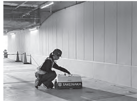
写真一七 墨出しロボット
