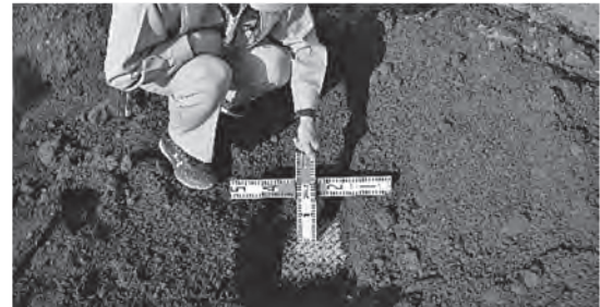
写真—6 ICT 施工実施時の掘削結果
