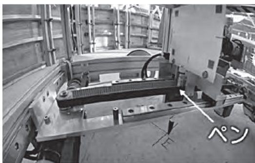
写真-2 ペンプロッタによる墨出し（外装カバー無）
