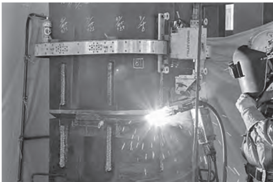
写真一3 溶接ロボット 施工状況
