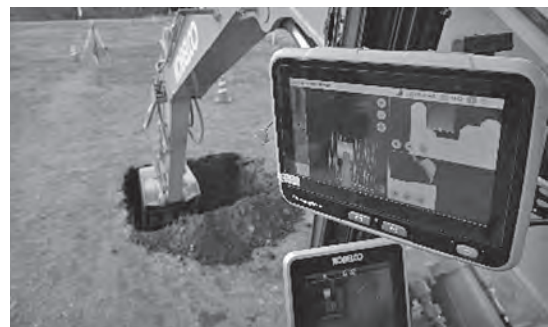
写真-4 ICT建機による掘削作業
