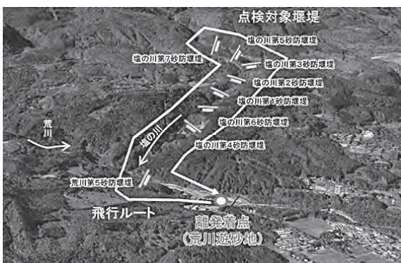
図一 3 点検対象の砂防ダムと飛行ルート（出所：国土交通省）
