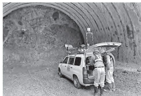
写真—2 切羽写真の取得状況
