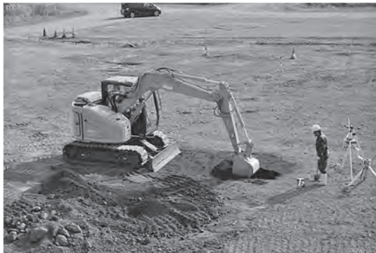
写真—5 従来建機による掘削作業
