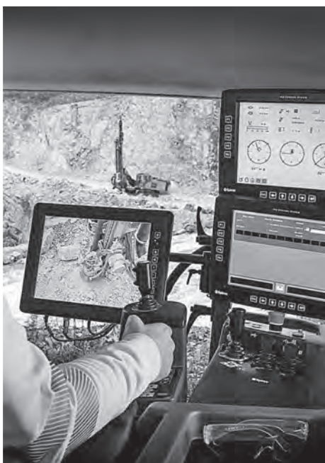
写真—7 遠隔操作機と同じ操作レバーとディスプレイで危険エリアのせん孔機のせん孔作業
