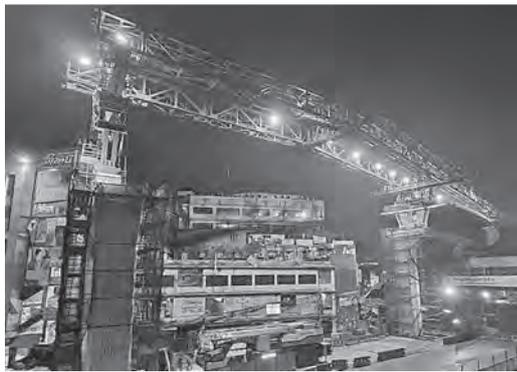
写真一3 急曲線L = 40m 区間 LG 移動状況
