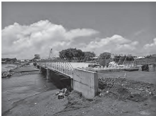
写真一 5 桁架設後
