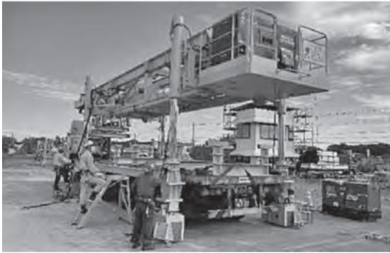
写真一 2 架設機上部本体フレーム運搬・組立
