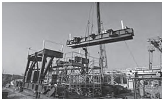
写真一〇 主構（前方部）の搭載
