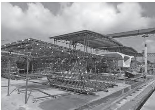
写真—2 製作ベッド屋根設置状況、プレハブ鉄筋組立状況
