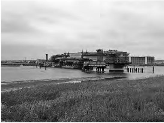
写真一七 台船吊上げ架設状況
