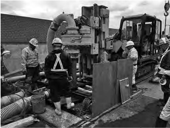
写真-10 階段工基礎 (TBH 工法) 施工状況
