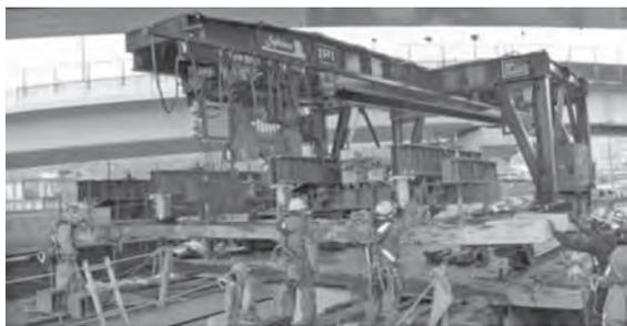
写真—14 旧床版撤去作業
