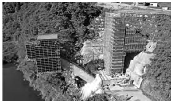
写真-4 斜吊り張出し架設
