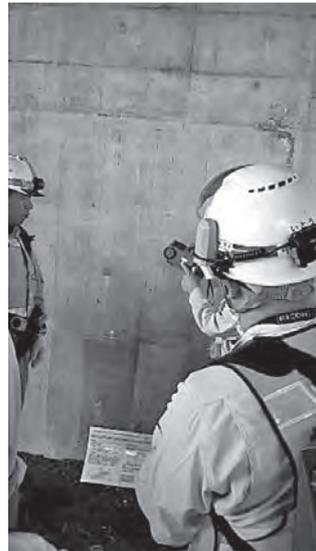
写真一六 コンクリート橋脚の鉄筋探査の様子
