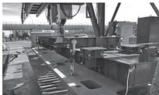
写真一6 新設床版架設時の天秤構造
