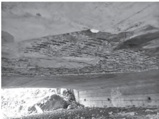
写真—1 既設橋下面の損傷状況
