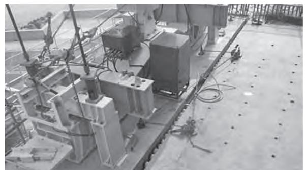
写真-4 基準セグメントの平面位置・高さセット状況
