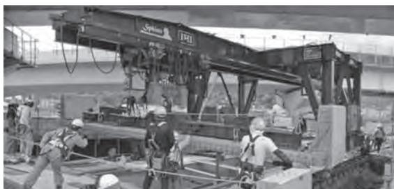
写真—15 新設床版架設作業
