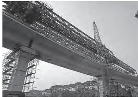
写真-1 スパンバイスパン架設完了状況
