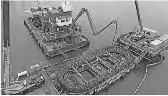
写真-4 コンクリート打設状況
