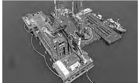
写真三 鋼管矢板打設状況
