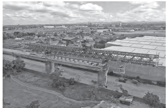
写真-4 LG架設状況
