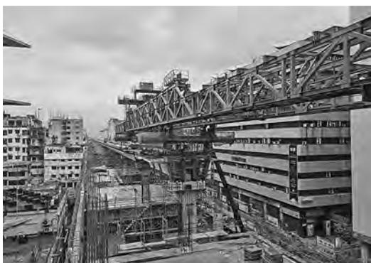
写真—5 カルワンバザール駅部セグメント施工状況
