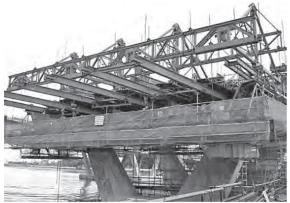
写真-11 道路橋の現場打ちバランスキャンチレバー移動型枠
