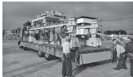
写真一1 架設機走行フレーム運搬
