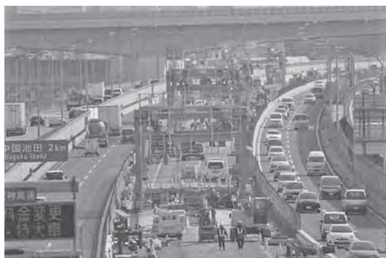
写真一5 床版取替機配置状況
