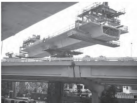
写真-10 道路橋の移動式 PC 緊張吊り足場
