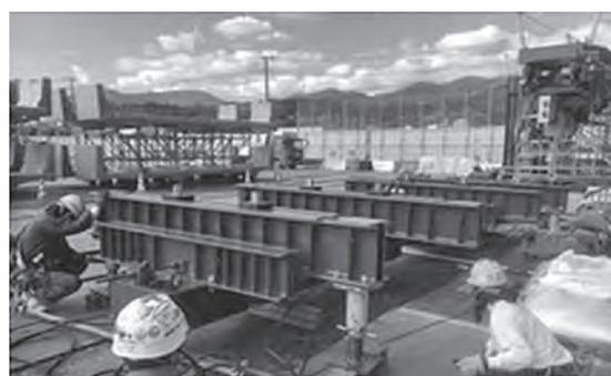
写真一5 旧床版撤去時の天秤構造
