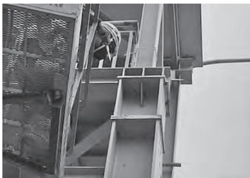
写真一 6 下部工接続部 確認状況
