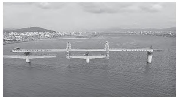
写真—2 架設桁による張出し架設
