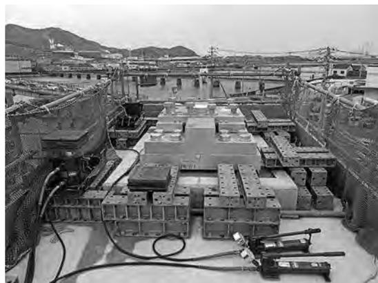
写真-3 P4 支承調整装置および固定装置
