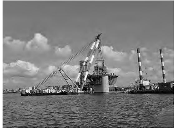
写真-5 柱頭部架設状況
