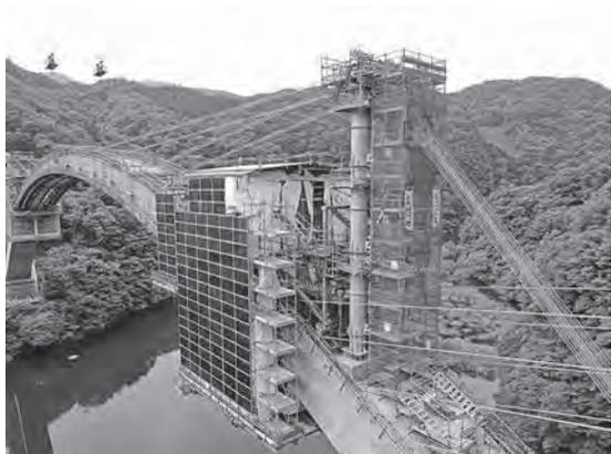
写真-6 鋼メラン材の架設
