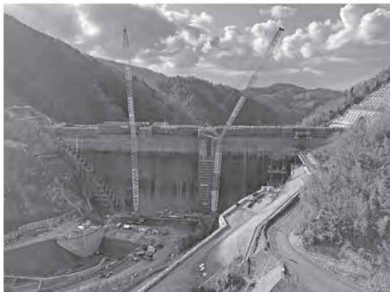
図一五 試行現場におけるクレーンの運用状況（ケース1）
