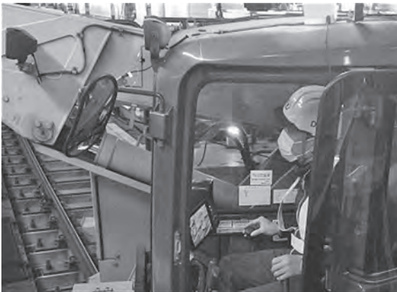
写真一8 軌陸クレーンへの応用
