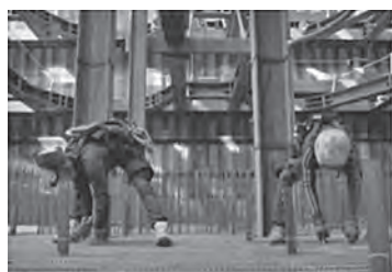
写真-11 床配筋の様子
