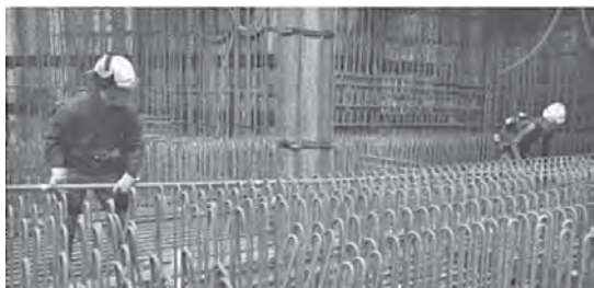
写真-9 鉄筋持ち上げの様子
