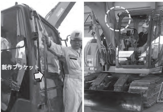
写真-4 ブラケットを使ったカメラの固定 (前面)
