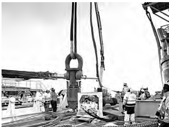
写真—13 汎用型吊り具 作業風景 船上では、玉掛け作業員やその他機器は不要となる
