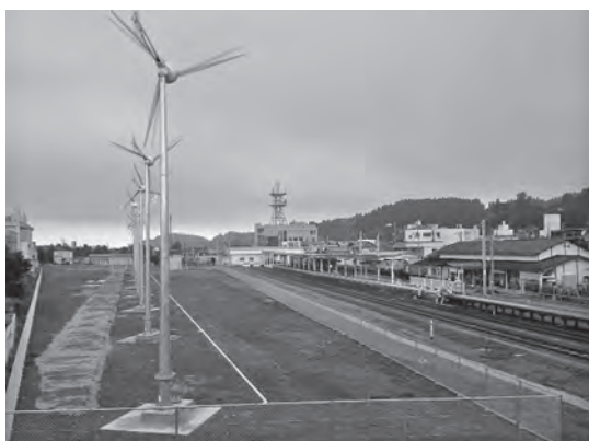
写真一 3 男鹿駅 小型風力発電機
