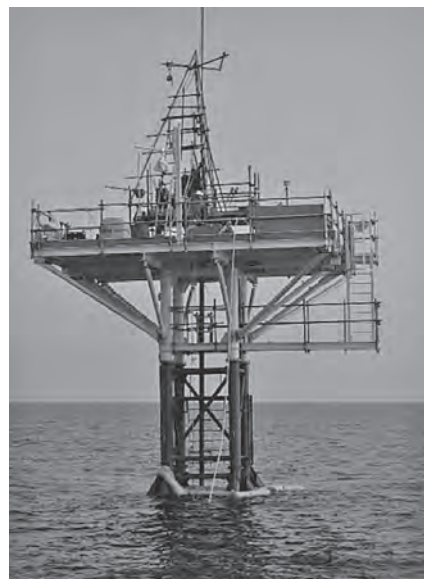
写真-1 自社製ボーリング用鋼製槽（15基保有）
