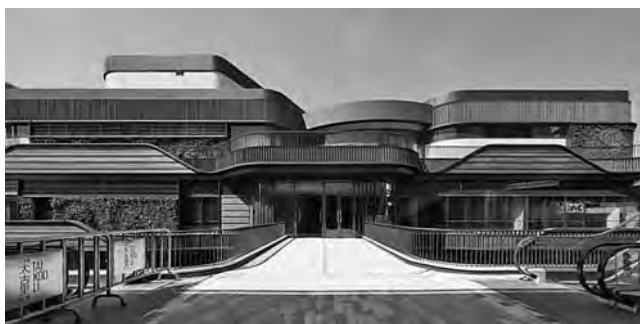
写真—2 上海のショッピングモールの外壁飾り（スギ・ヒノキ） （写真提供：越井木材工業株）
