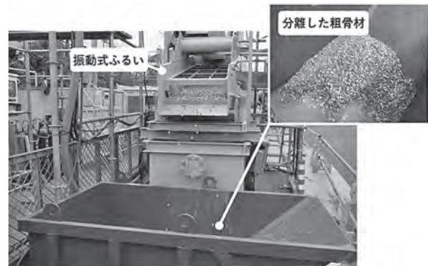
写真一2 散水装置付き振動ふるいの稼働状況
