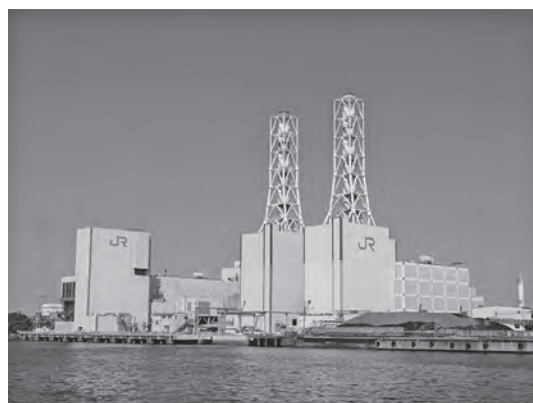
写真—1 川崎火力発電所
