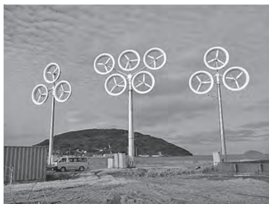
写真一3 唐津市、3kW×3基 (9kW)、および3kW×5基 (15kW) のマルチレンズ風車 (2020)
