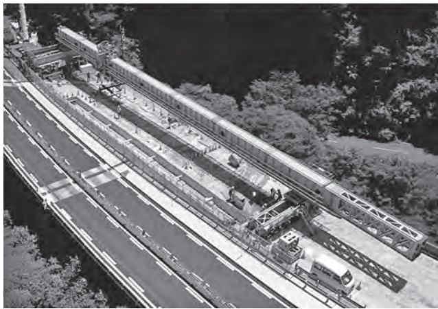
写真一 施工状況全景
