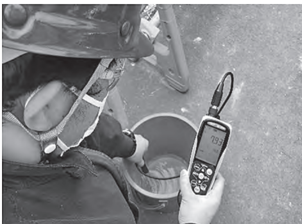
写真-5 pH測定状況
