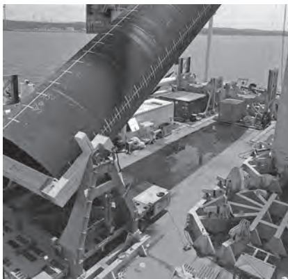
写真一5 SPMTに積載された Up-ending Hinge 荷重はSPMTにより甲板に均等に分散される点の特長
