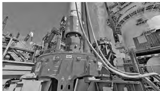
写真—15 水塊充填式騒音低減装置 写真中央にあり、ハンマーとスリーブの間に装着されている
