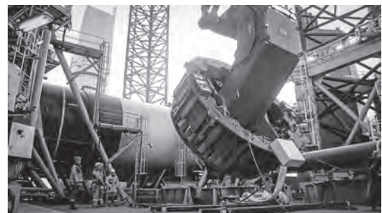
写真二2 グラウト式モノバイル用吊り具 既述のピンバイル用吊り具と設計原理は同じ。現在は 2,000 トンを超える杭の重量に対応可能
