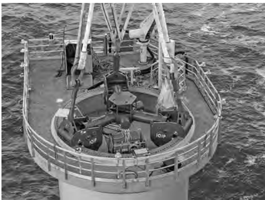
写真-11 トランジション・ピース専用吊り具
