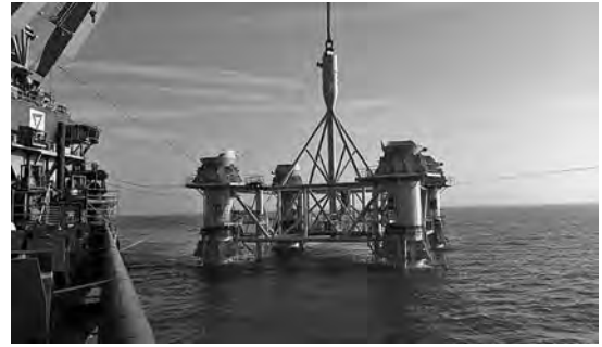
写真-12 ジャケット用据付テンプレート
