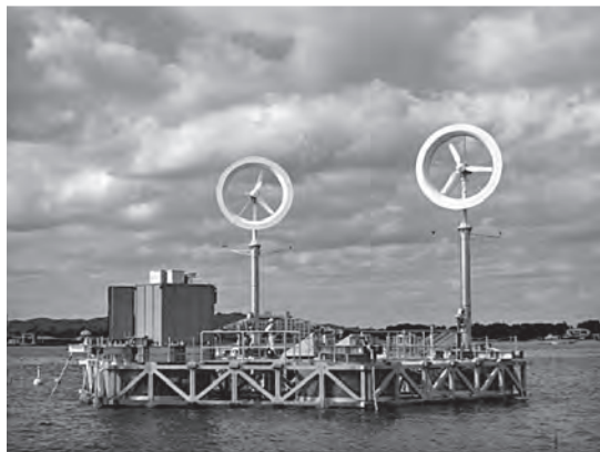
写真一2 博多湾プロジェクト(ステージI)18m直径の六角形コンクリート浮体。3kW レンズ風車2基と2kW 太陽光パネル搭載で計8kWのエネルギーファーム, 2011年12月。
