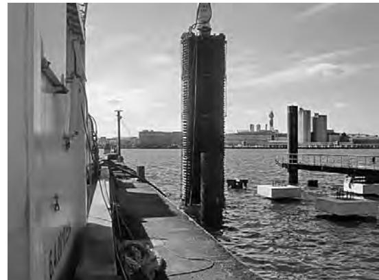
写真一九 気中騒音低減装置
