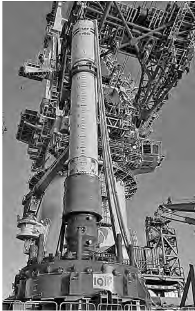
写真一七 打撃エネルギー 4,000 kJ の杭打ちハンマー
