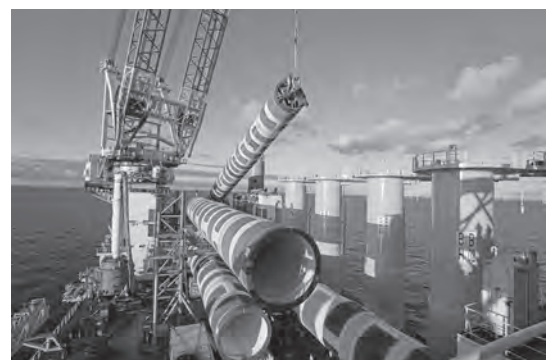
写真三3 フランジ式モノバイル用吊り具 こちらも 2,400 トンを超えるフランジ式杭の重量に対応可能
