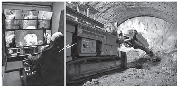
図-2 遠隔操作試験実施状況
