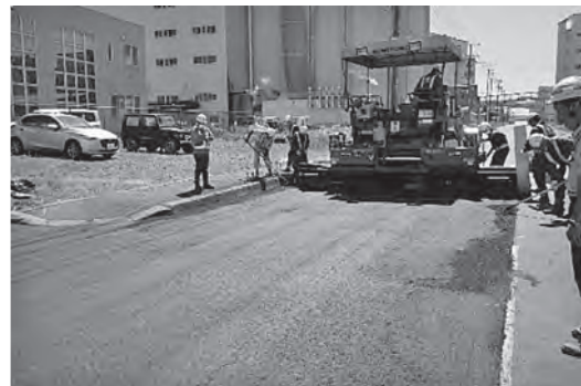
写真一七 施工状況
