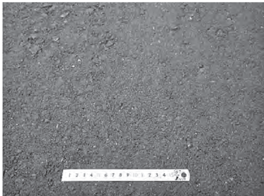
写真一五 舗装面写真
