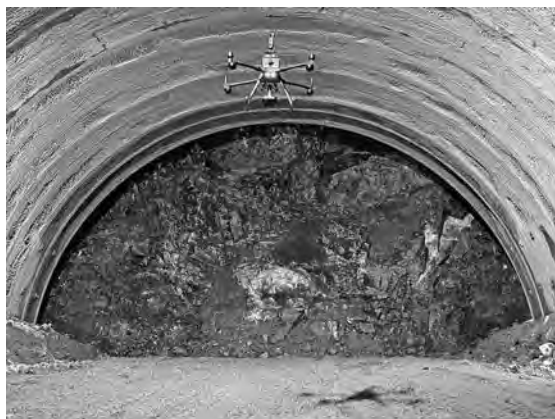
写真-5 ハイブリッドカメラによる遠隔切羽点検
