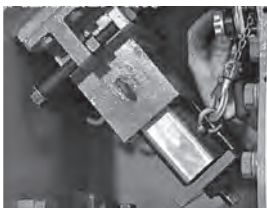
写真一〇 旧ビット引込み
