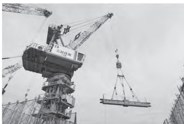
図一 運転支援システムを導入したタワークレーン
