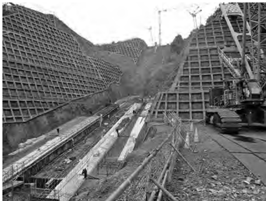
写真—10 洪水吐き（シュート部）
