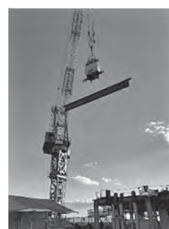
写真-1 実証試験の状況
