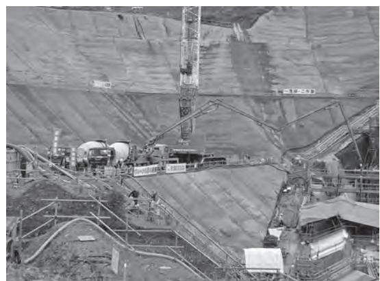
写真一 4 コンクリートポンプ打設
