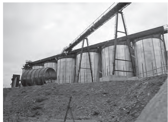
写真一九 骨材貯蔵ビン
