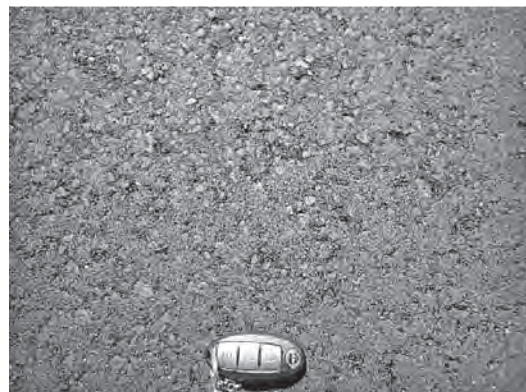
写真一八 舗装面写真 (施工直後)
