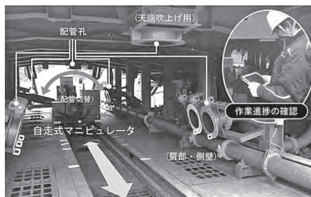
図一3 自走式マニピュレータを用いた覆工自動打設
