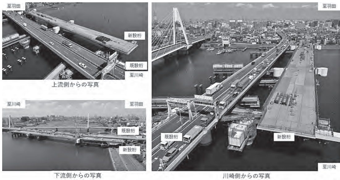
写真一 4 新設桁組立状況
