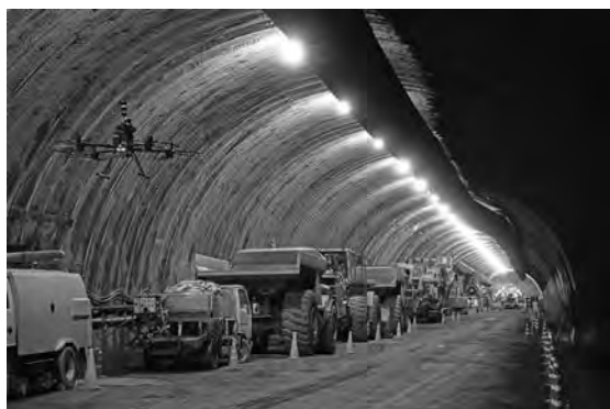
写真—2 坑内の自律飛行状況
