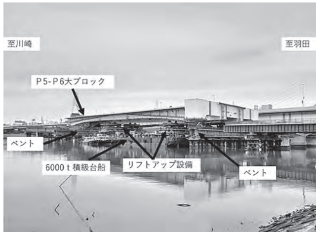
写真-2 大ブロック架設状況
