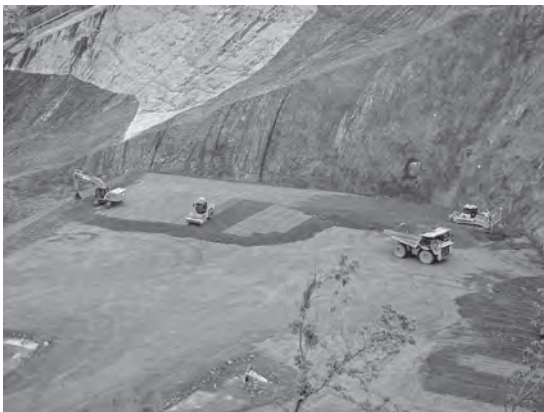
写真一六 堤体内部ロック施工
