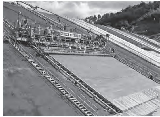
写真一七 スリップフォーム (他ダム事例)
