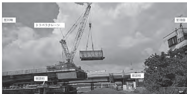
写真-3 トラベラクレーン架設状況
