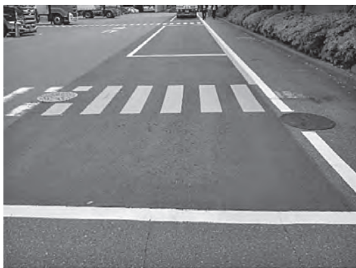
写真一四 状況写真 (事例①)
