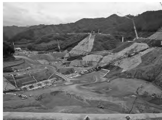
写真-2 ダム工事現場
