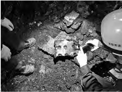
写真-5 添接部の既設グース撤去状況
