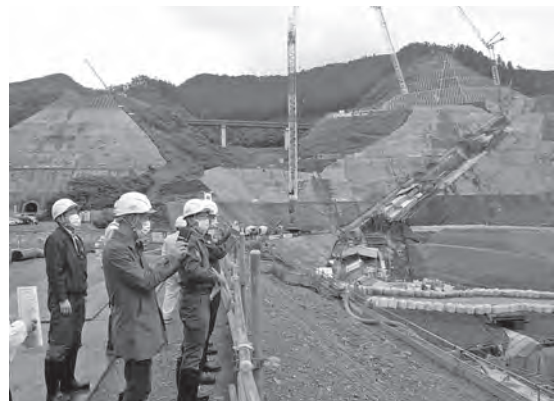
写真一 3 プリンス打設状況確認
