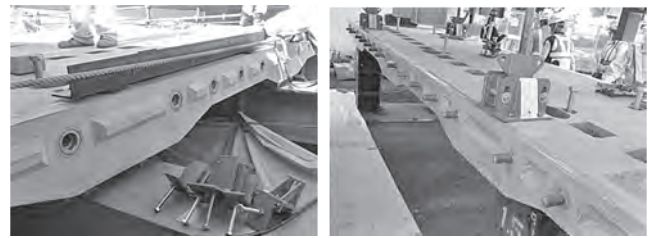
写真一 2 PS ジョイント床版接合部
