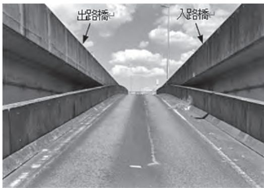
写真一 試験橋梁の施工前状況
