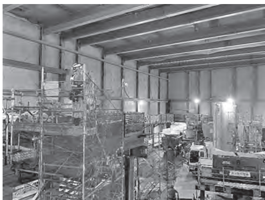
写真-3 Live 映像配信状況 (立坑上部)
