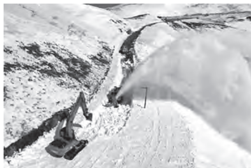
写真一 2 知床峠における現状の除雪作業
