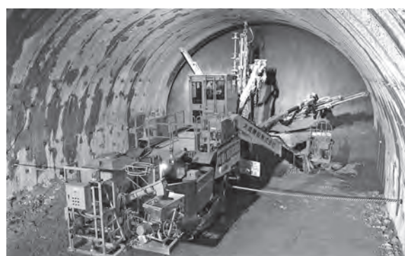
図-12 BOLTINGERでの施工状況(2号機)
