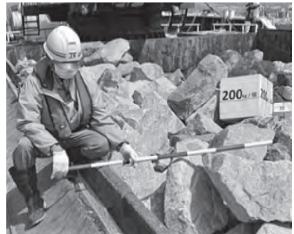
図-5 検収作業状況
