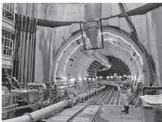
写真-4 Live 映像配信状況 (立坑下部)
