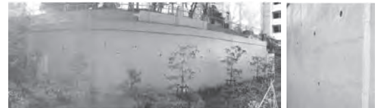
写真一10 タフネスコート工法の施工事例
