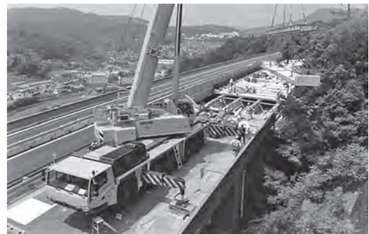
写真一 3 大型クレーンによる床版架設例
