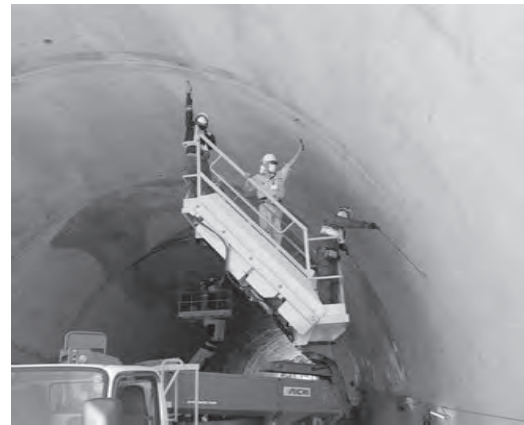
(b) プラットフォームによる作業状況
