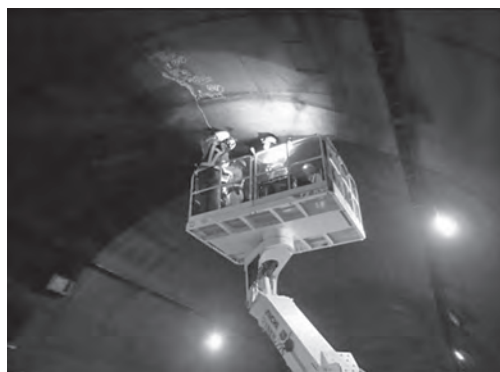
写真-1 高所作業車を用いた近接目視作業の例
