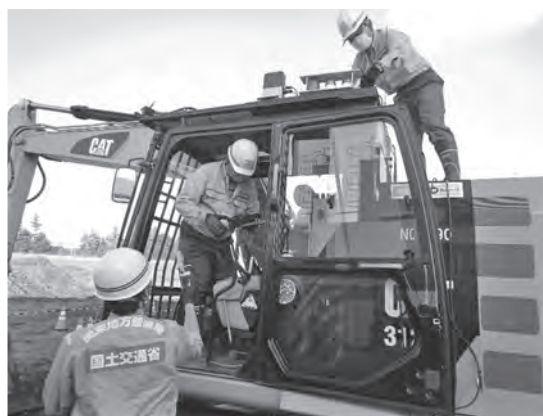
写真-2 簡易遠隔操縦装置（ロボQS）の設置
