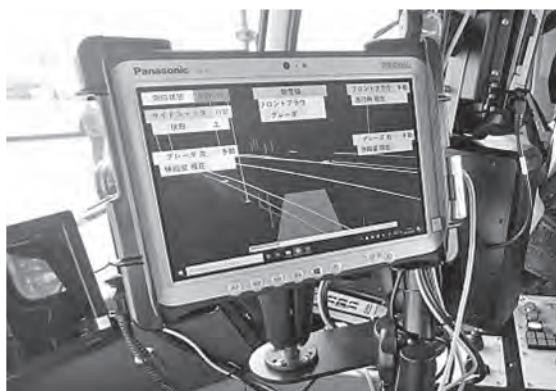
写真-2 自動制御装置
