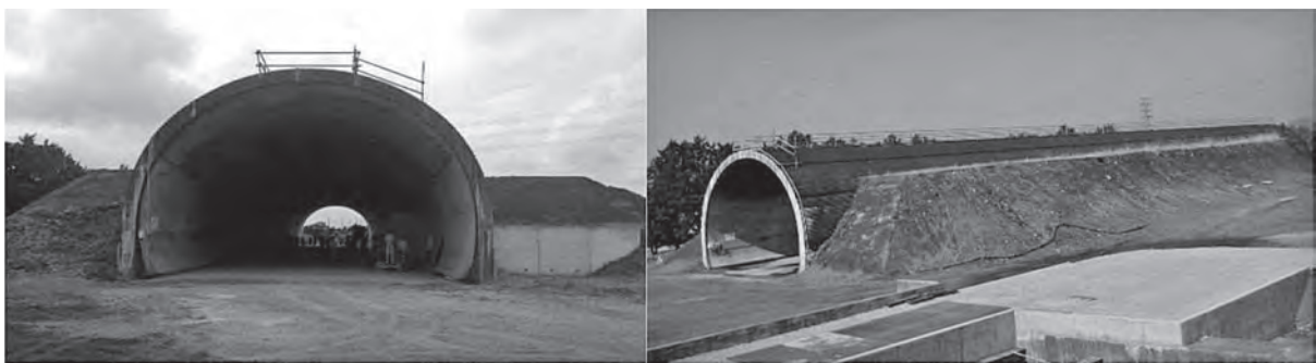
写真—3 模擬トンネルの外観
