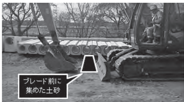
写真-5 オフセット仕様機でブレード前土砂をすくう動作の例
