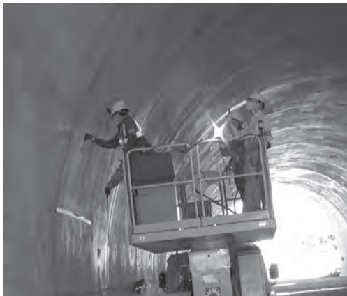
(a) 高所作業車による作業状況
