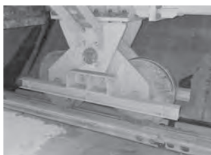
③下部コンクリート区間車輪
