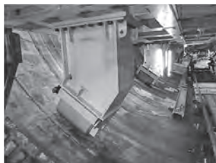
写真一17 車輪設置完了
