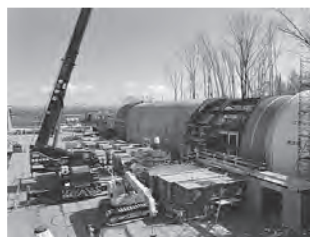
写真一〇 投入開口状況
