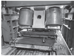
写真一13 車輪引込状況①
