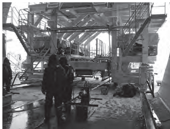
写真一八 後続台車引込状況
