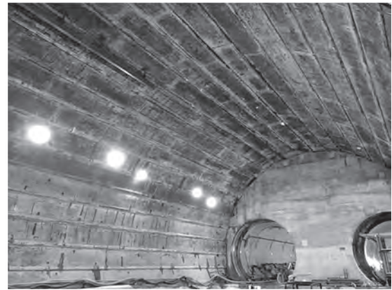
写真一 6 非開削区間内部全景
