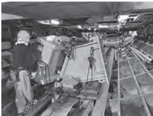
写真一14 車輪引込状況②
