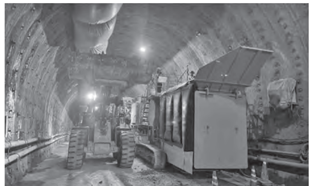
写真—4 掘削ずり投入状況
