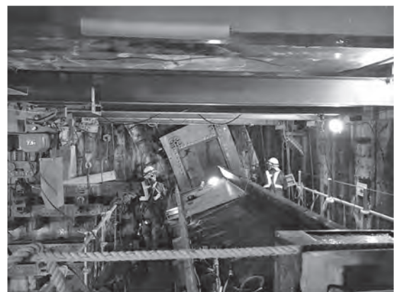
写真一 3 角形エレメント推進状況 (No.10)
