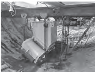
写真一16 車輪設置状況②
