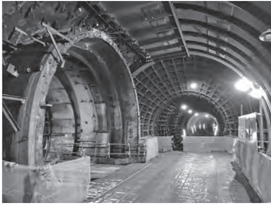
写真—4 隅田川幹線その3工事完了時
