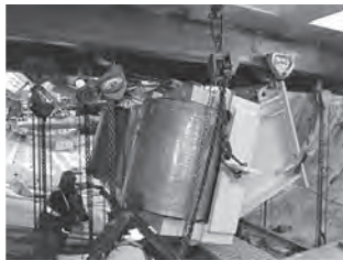
写真一15 車輪設置状況①
