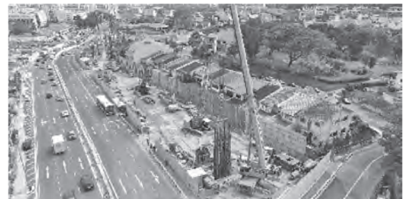
写真一4 地下連続壁施工状況
