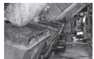
写真-3 打設ポンプ
