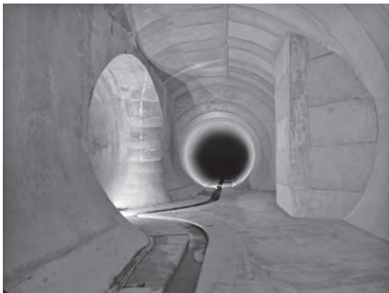
写真—5 二次覆工（隅田川幹線その4工事）完了時
