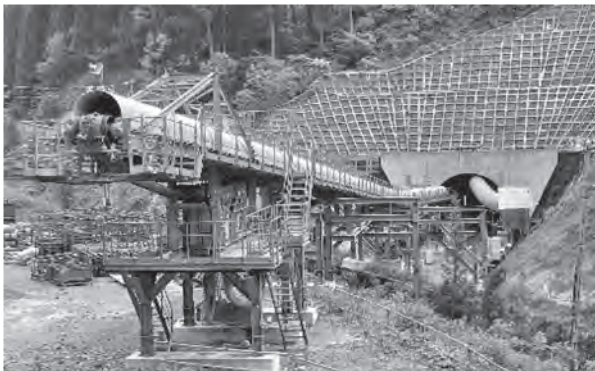
写真—1 坑外設備
