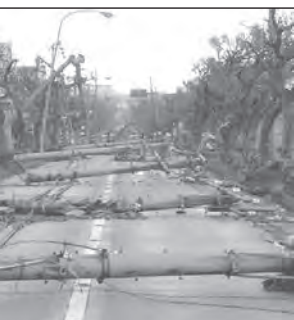
&lt;電柱の倒壊による道路閉塞&gt;
