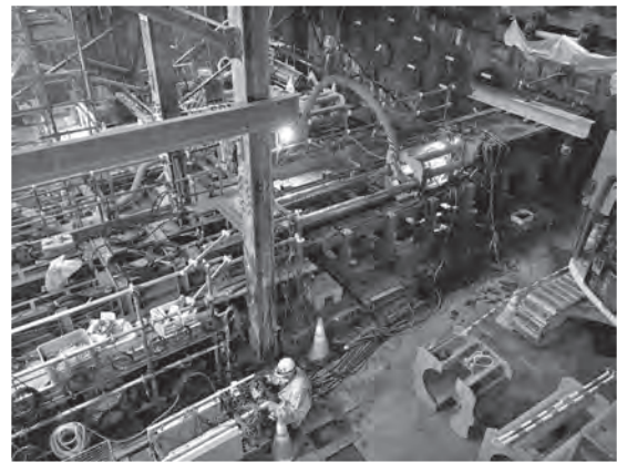
写真一 2 角形エレメント推進施工状況全景
