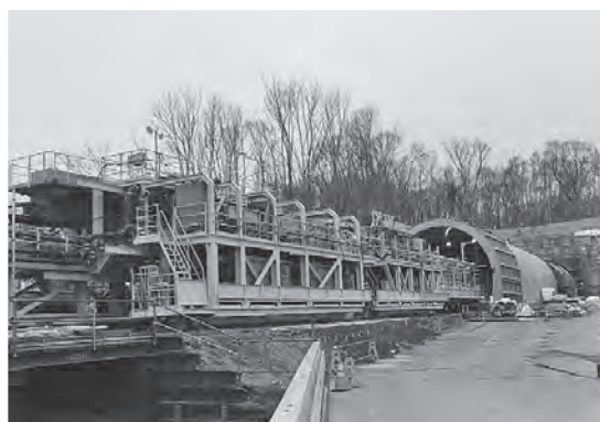
写真一九 初期掘進発進時後続設備全景写真
