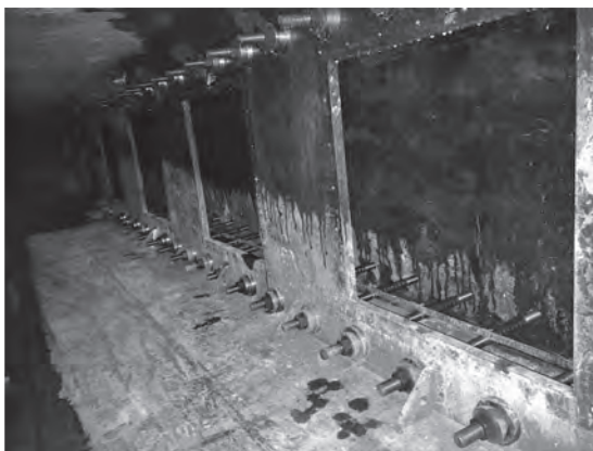
写真一 5 閉合部棒状連結材設置状況
