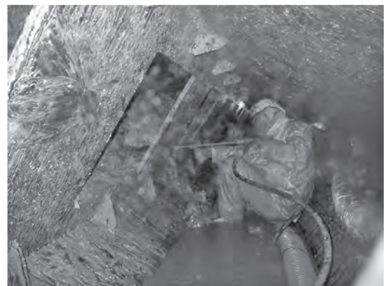
写真一 4 角形エレメント間掘削状況
