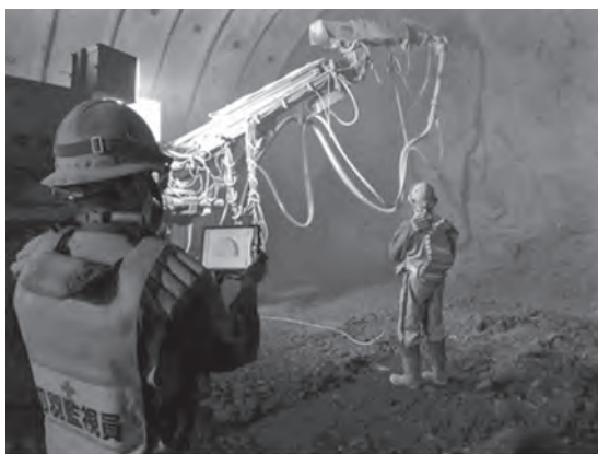
写真一三 切羽監視員による切羽監視状況
