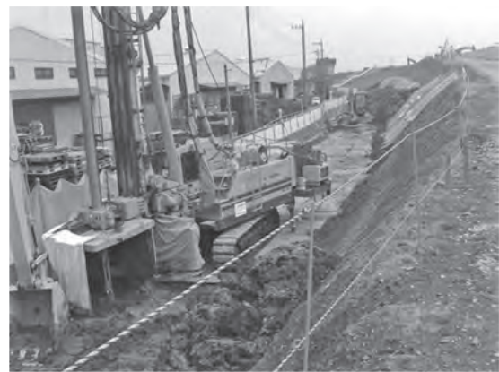
写真—1 河川堤防での小型施工機の施工状況
