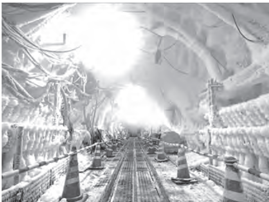
写真一1 凍土造成時のトンネル坑内
