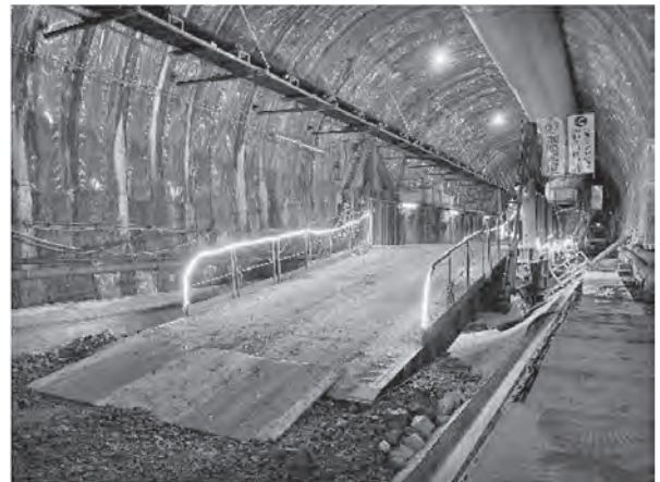
写真-6 インバート栈橋
