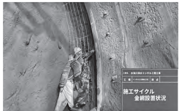
写真-10 溶接金網設置状況 (従来工法)
