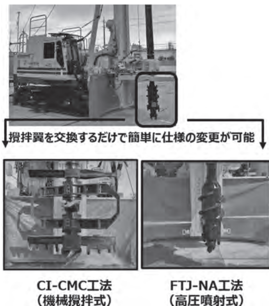
図-4 CI-CMC工法とFTJ-NA工法
