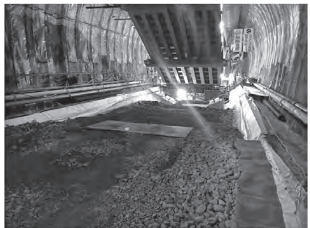
写真-7 インバート栈橋(跳ね上げ時)
