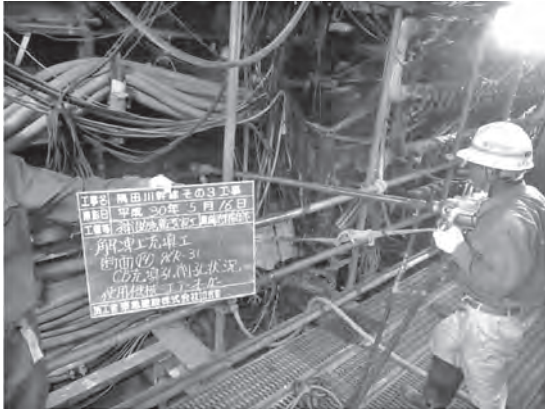
写真—3 セメントベントナイト充填状況
