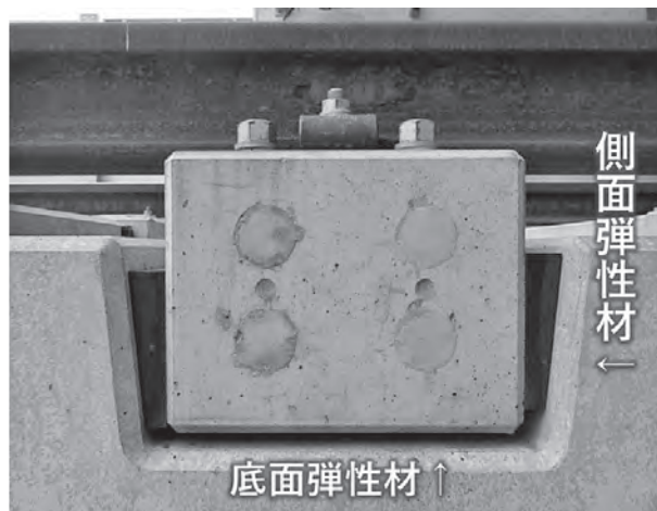
写真-5 側面弾性材と底面弾性材
