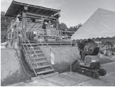
写真—2 坑外からの遠隔操作
