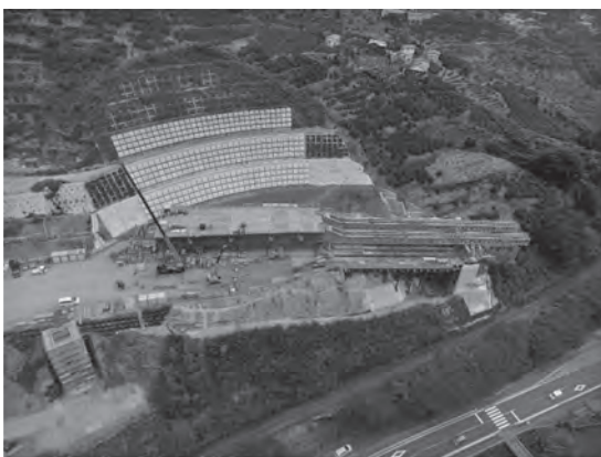
図一6 本桁+連結構+手延べ桁写真
