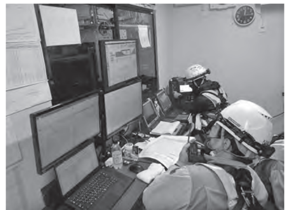
図-11 送り出し制御室により反力等の制御の写真
