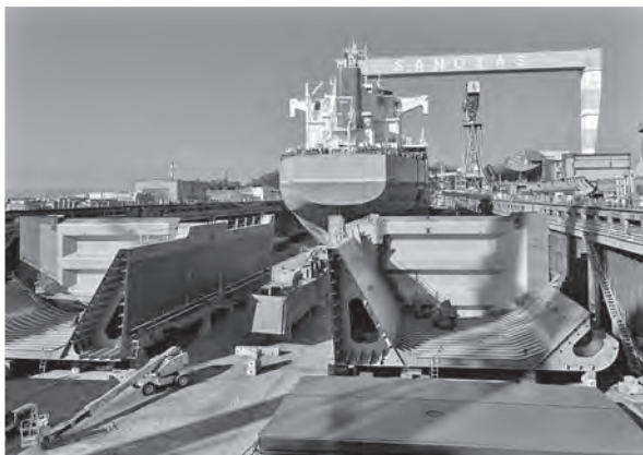
写真—7 ドック内新造船作業風景
