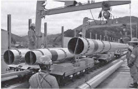
写真一四 D型トロによる電車線柱の荷卸し
