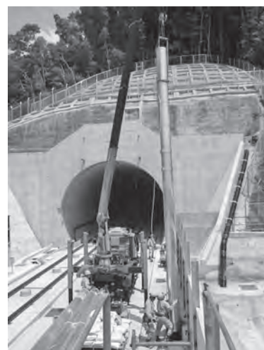
写真—1 特種車ⅢBによる建植作業
