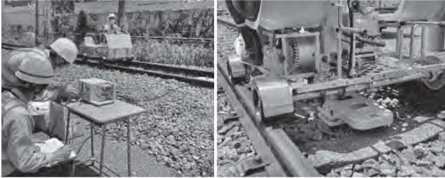
写真一七 試験線での試験状況
