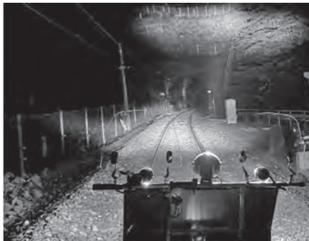
写真一八 紀勢本線における性能確認試験
