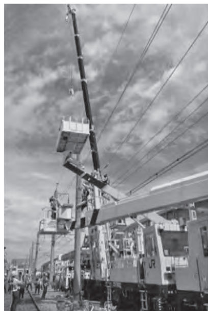
写真一 6 施工訓練
