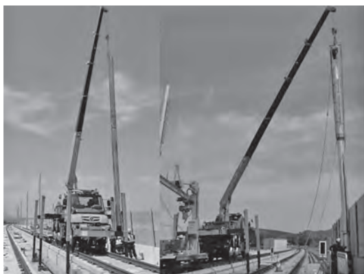
写真一六 特種車ⅢEによる電車線柱建植（左：最大の電車線柱建植機、右：複線の反対側への建植機）
