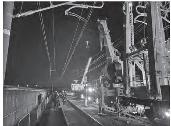
写真一八 ステップ2-① コンクリート製電柱撤去
