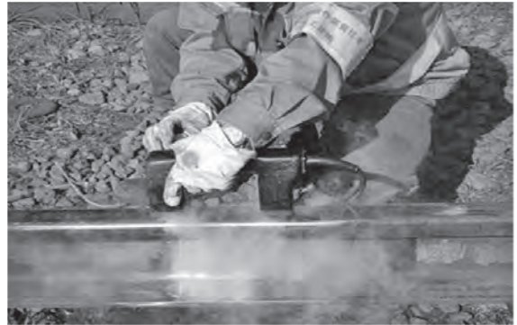
写真一4 磁粉探傷検査
