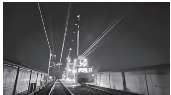
写真一九 ステップ3-② 鋼管柱新設
