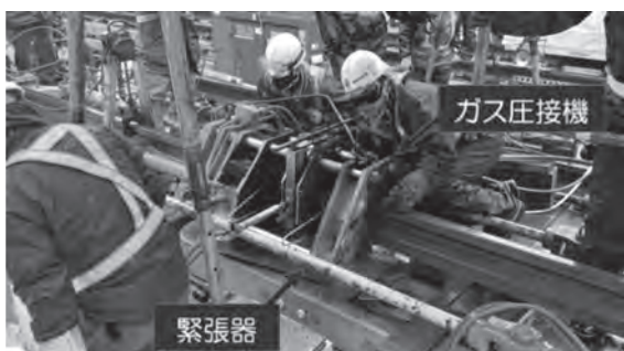
写真—5 緊張器を使用したガス圧接
