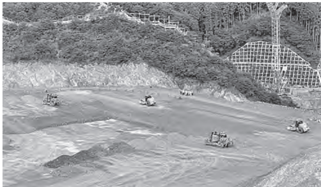
写真1 自動建機4台の施工状況
