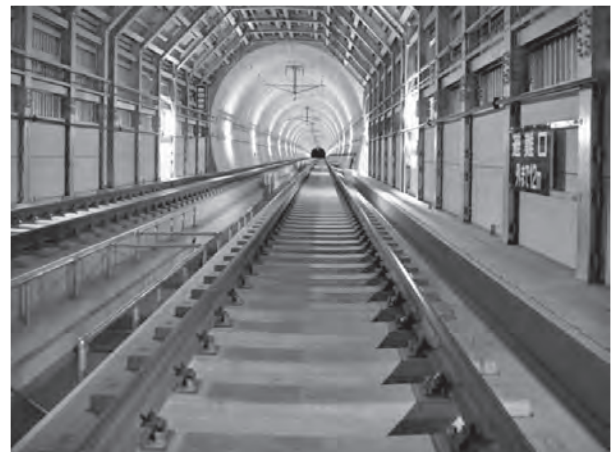
写真—1 弾性まくらぎ直結軌道
