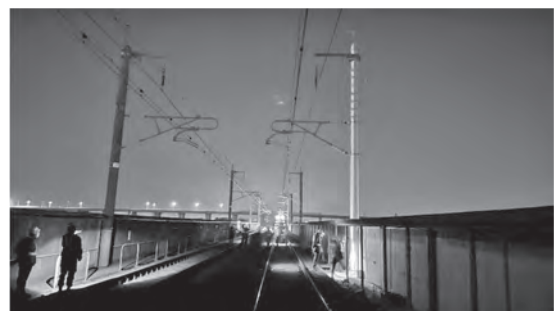
写真一〇 施工完了
