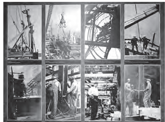
写真—5 建設の様子 (パネル写真)
