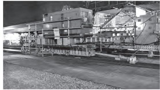
図一7 後方台車推進設備 ダブル水平ジャッキ
