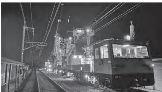
写真一七 ステップ1-③ 架線支持外し
