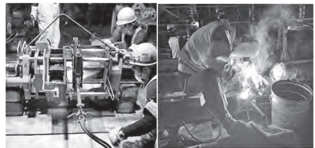
写真一 2 GP・EA 施工時
