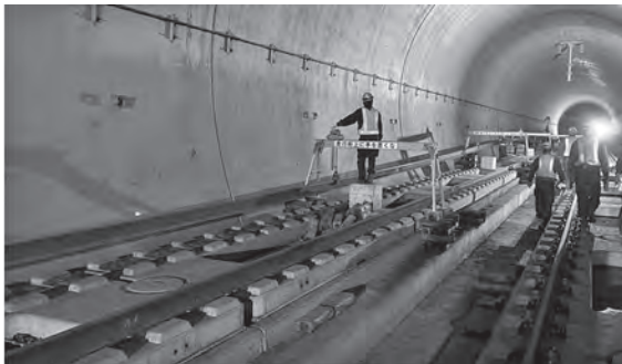
写真一3 レール扛上時
