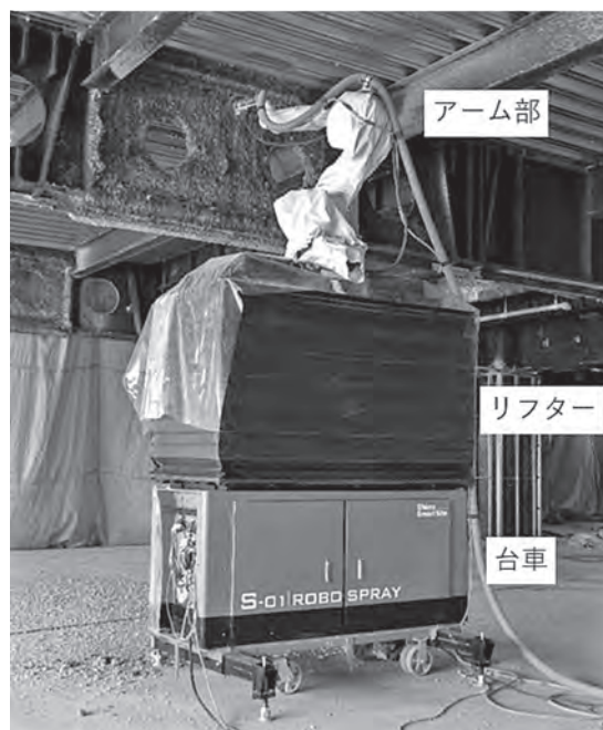
図二 耐火被覆吹付ロボットの構成
