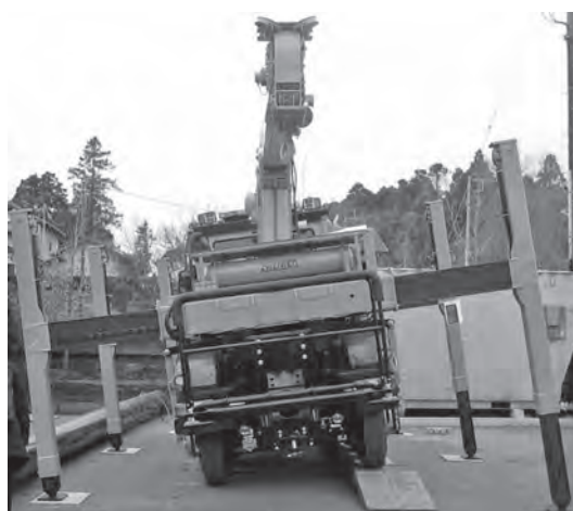
写真-3 カント補正機能によるクレーン水平調整
