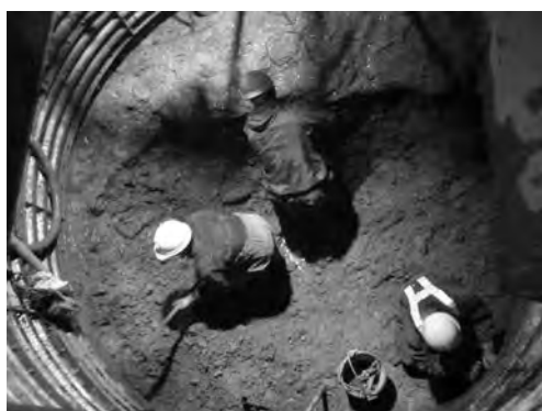
写真—1 人力による掘削状況
