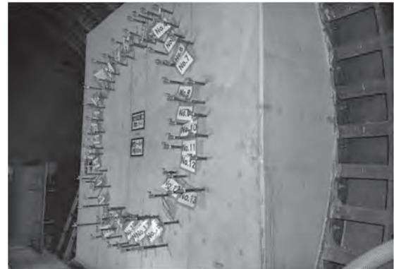
写真-4 既設管きよ内防護コンクリート
