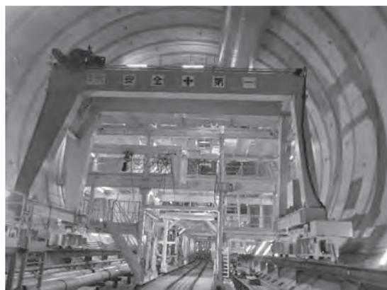
写真一七 坑内ストック用30t橋形クレーン
