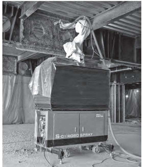
図-7 耐火被覆吹付けロボット
