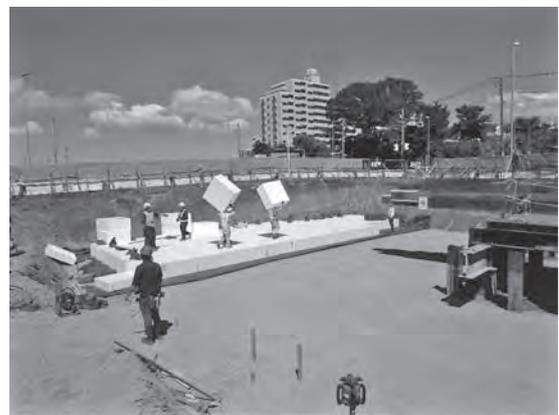
写真-3 軽量盛土施工状況
