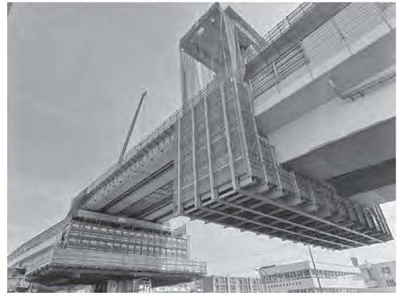
写真一4 移動台車下部作業台置
