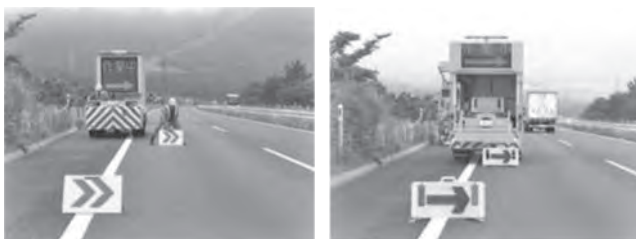
図一七 矢印板設置作業の違い
