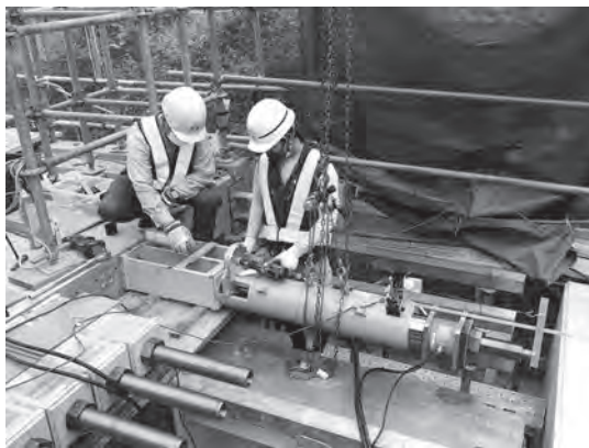
写真一三 アラミドFRPロッド緊張状況
