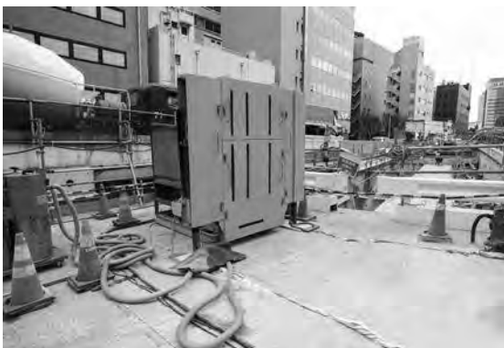
写真一八 床版クールカット工法 現場実装
