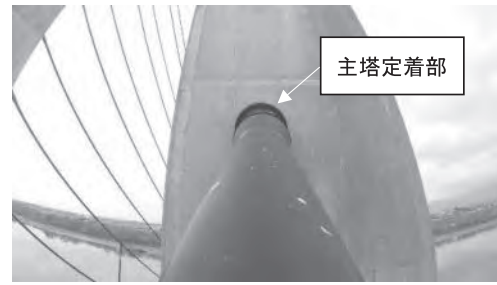
写真—9 主塔側定着部の状況
