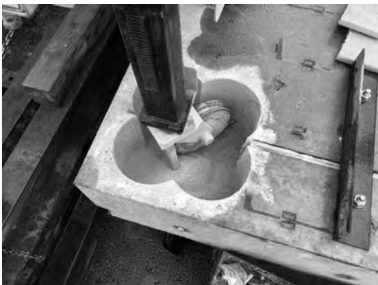
写真一七 コア孔 粉塵堆積状況
