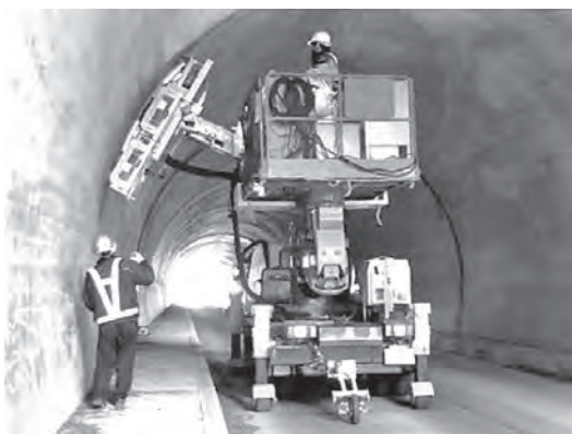
写真一七 道路トンネルでの点検状況
