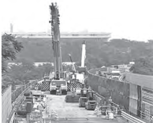
写真—1 床版取替工事の事例
