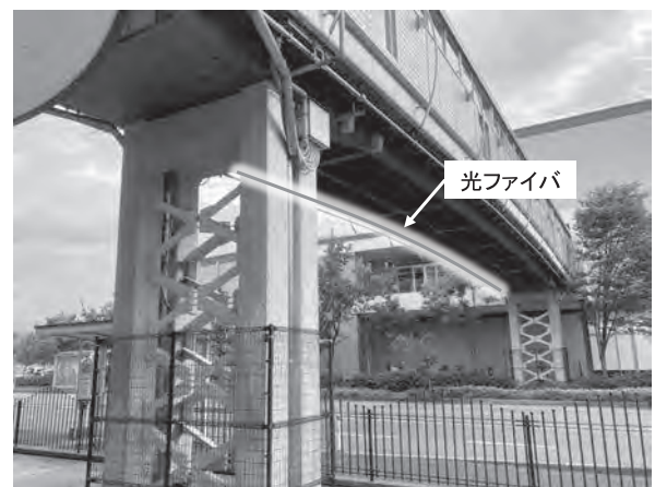
図—5 ひび割れ検知対象の歩道橋
