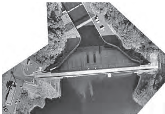
図一五 オルソ画像（堤体全体）
