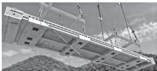
写真-4 床版吊上げ
