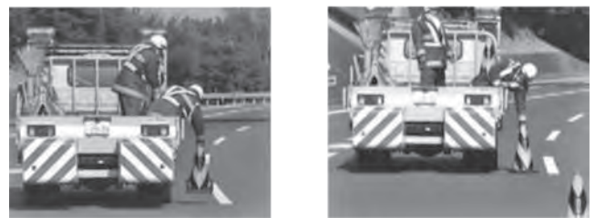
図一2 ラバーコーン設置・回収作業
