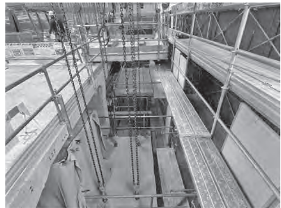
写真一6 撤去ブロック仮吊切断状況
