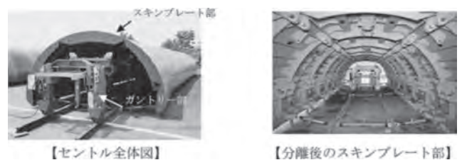
図一八 テレスコピック型セントルの例 3)
