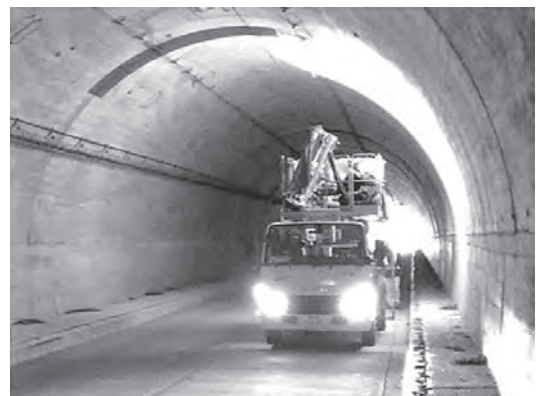
写真一 9 撮影ユニットによる撮影状況
