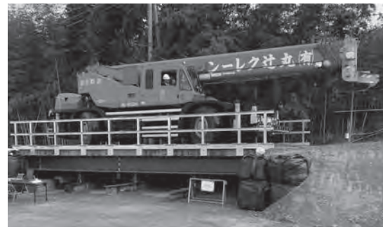
写真-2 車両載荷試験
