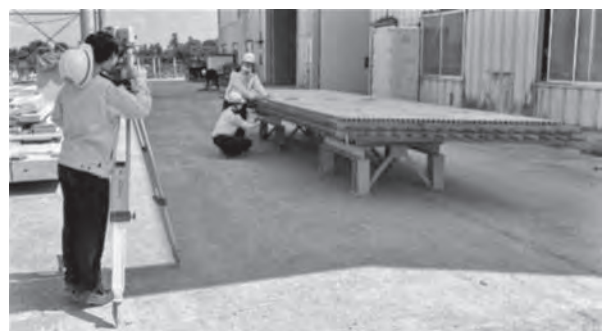
写真一2 製作した床版の計測状況
