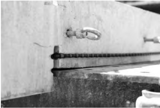
写真一2 床版下面スリット部（幅 10 mm，深さ 30 mm）とダイヤモンドワイヤー
