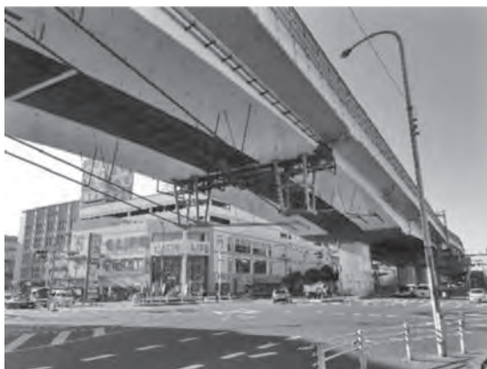
写真-1 架け替え前の喜連瓜破高架橋
