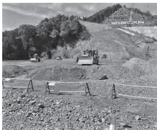
写真一 自動建機による施工状況
