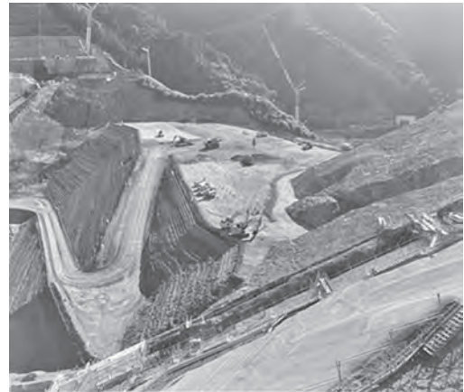
写真一5 堤体と上流側工事用道路
