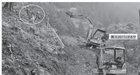
遠隔 + 丁張で掘削 危険区域に作業員
