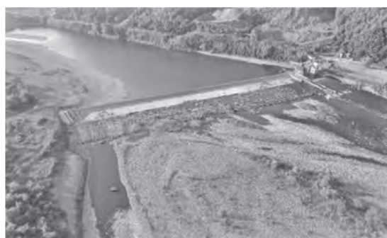
写真-3 水域・陸域が混在した現場状況
