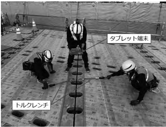
図-3 締付ボルトのトルク管理
