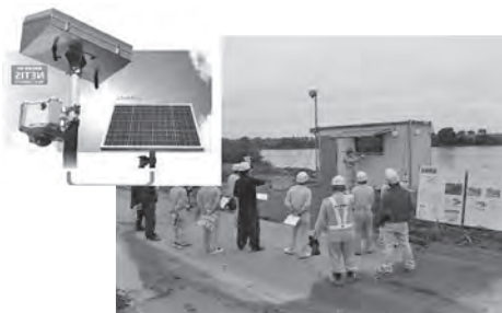
ソーラー稼働監視カメラとデジタルサイネージ
