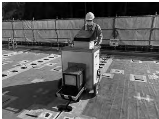
写真—2 計測状況 (出来形検査システム)
