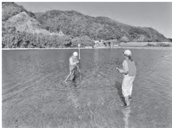
写真-2 VRS-GNSS 計測状況
