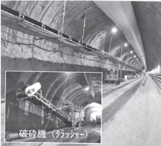
写真一2 連続ベルトコンベアと破砕機（天神トンネル作業所現場概要資料より）
