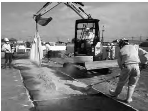
写真一五 固化材敷均し状況
