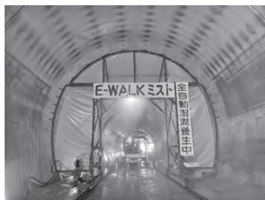
図一3 E-WALK ミスト<sup>®</sup>設置状況
