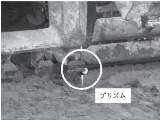
図-5 測量機でプリズムの位置を測量
