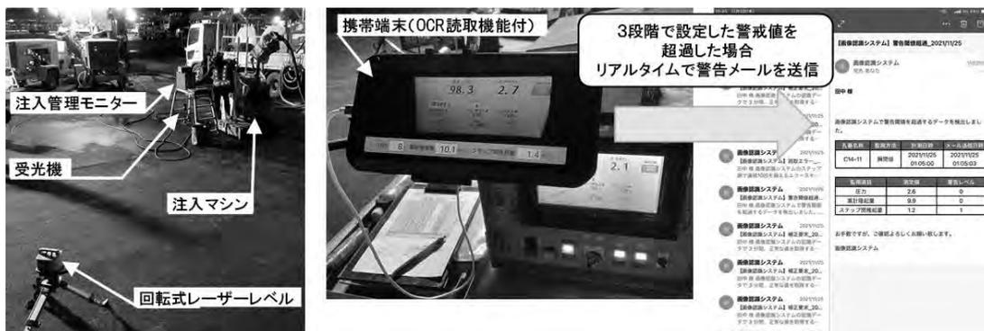
図-14 施工状況連携技術 検証状況
