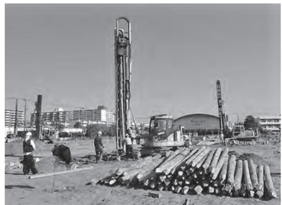
写真一 1 LP-LiC 工法の施工状況
