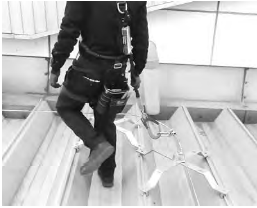
写真一 水平設置型システム
