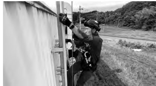
写真四 タラップ（固定はしご）に設置した垂直設置型システム
