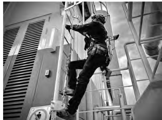
写真五 垂直設置型システムを使用したタラップの昇降シーン
