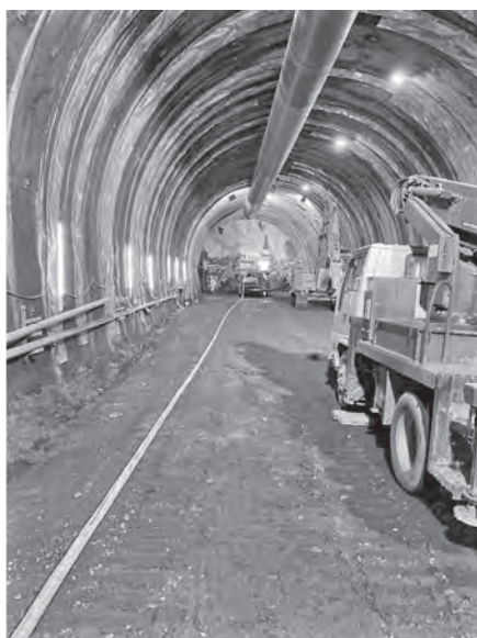
写真—1 トンネル掘削現場（切羽）
