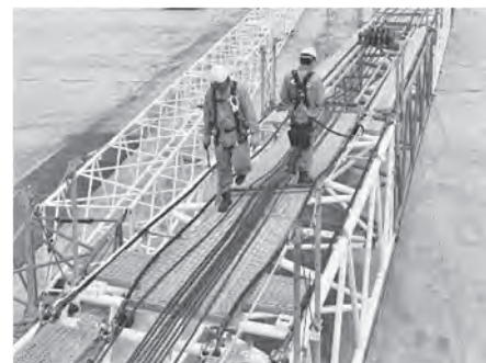
写真一一 ブーム上面でのすれ違い
