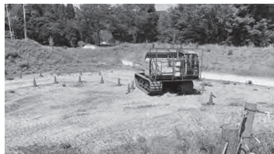
コースを走行する重機（遠隔からの探縦）
