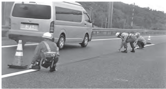
写真一五 路面マーキング作業（舗装修繕工事）
