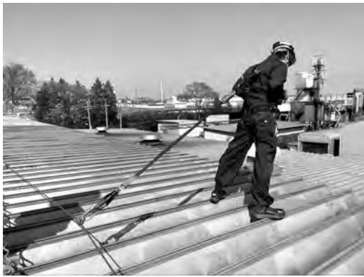
写真二 水平設置型システムによる「レストレイント」
