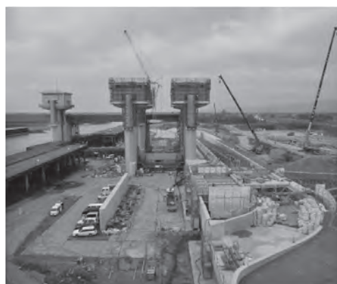
写真-1 工事実施状況
