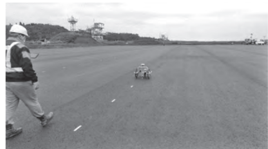
写真—4 自走式ロボットの作業状況
