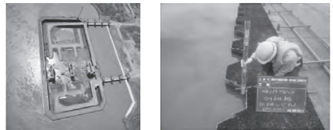
写真一2 出水時状況
