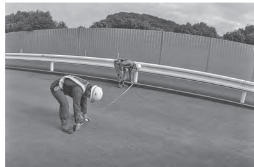
写真—1 路面マーキング作業（型枠配置用）
