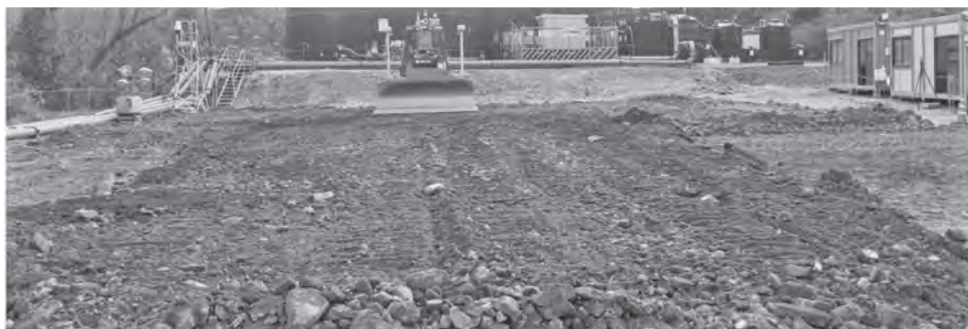
写真—3 仕上げ敷均し後の状況
