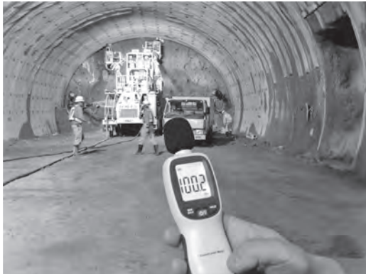
写真-3 100 dB を超える騒音下での実証実験 (切羽)
