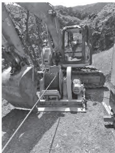
写真-1 ウインチと0.45 m 3 油圧ショベル（重量物置換アンカー）
