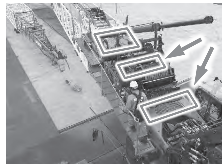
写真一二 ドラム周囲の足場
