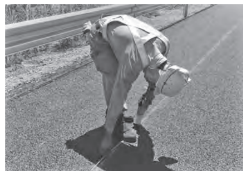
写真一八 基準線描写作业（チョークライン）
