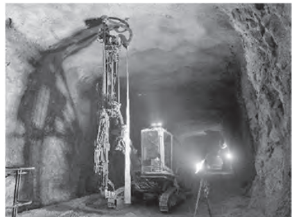
写真-4 油圧クロラドリル上向き削孔(頂設導坑)
