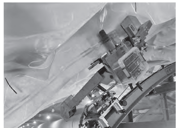
写真二 自動溶着機
