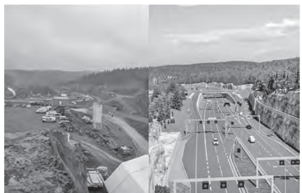
写真—2 実際の現場の様子(左)と Trimble Connect 上で表示される 3D モデル
