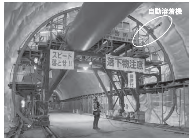
写真一 本技術を搭載した足場台車と実証試験状況
