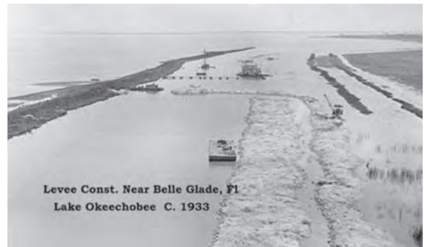
写真一2 1933 年頃の HHD 初期築堤状況
