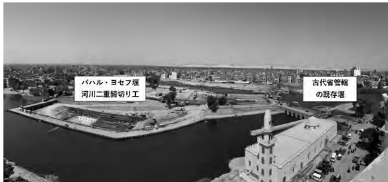
写真—5 河川二重締切り工 完了
