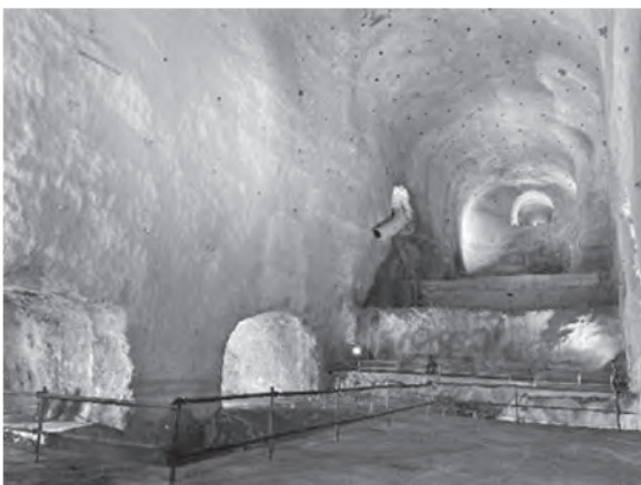
写真-3 地下発電所掘削完了
