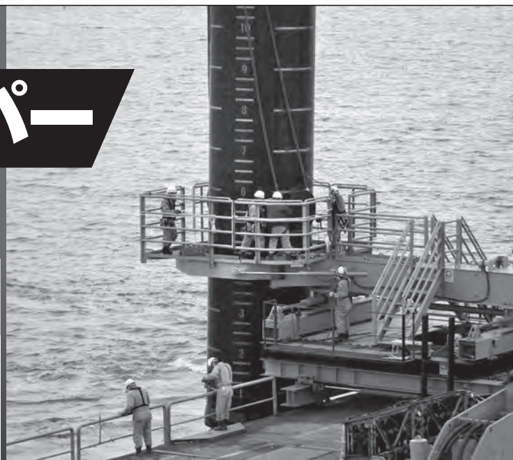
洋上風力発電ジャケット基礎杭工事
