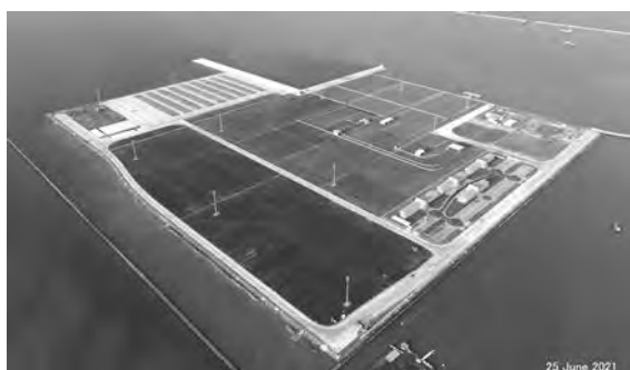
写真一 1 パッケージ1 完成写真
