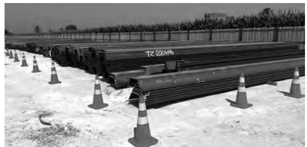
写真-3 現場搬入完了
