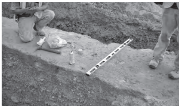
写真一6 止水壁頭部の出来型検査
