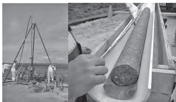
写真一7 コアボーリング採取状況
