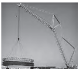
写真一19 3,000tクローラクレーン
