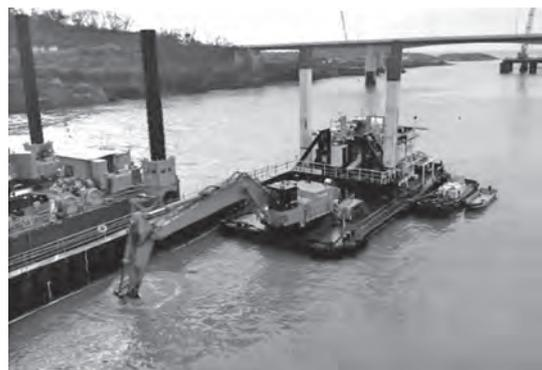
写真-2 バックホウ浚渫船の掘削状況
