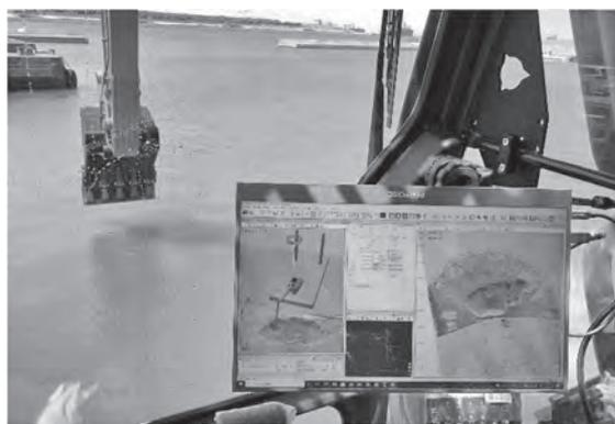
写真1 MBES施工管理システム使用状況
