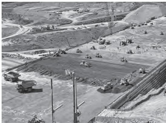
写真—2 A<sup>4</sup>CSEL による施工状況
