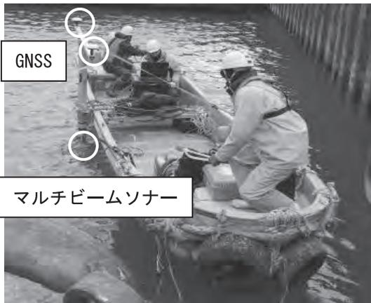
写真—3 作業船による深淺測量状況
