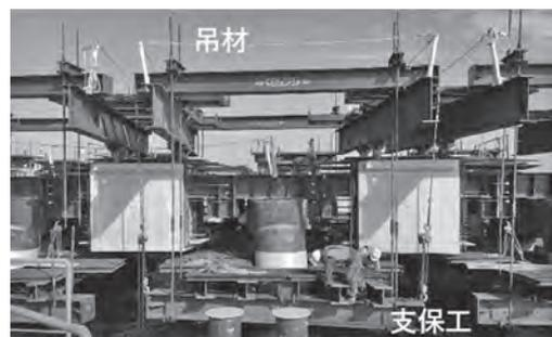
写真-6 吊支保工状況
