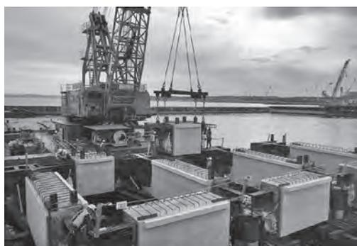
写真-8 PCa 梁設置状況
