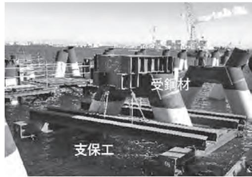
写真-4 受鋼材、支保工、PCa梁架設状況
