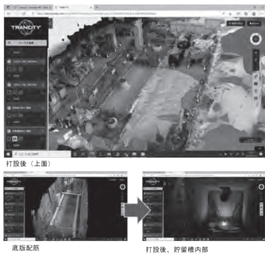
(a) 武蔵小杉駅 (貯留槽)
