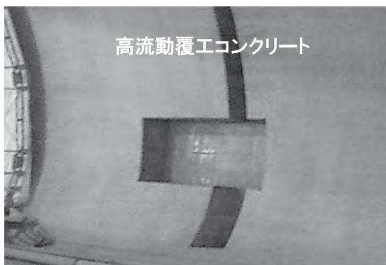
写真—7 箱抜き箇所の高流動覆工コンクリートの充填状況
