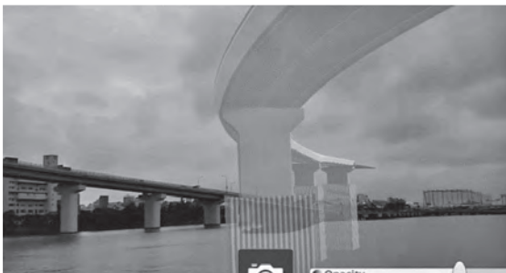
図一八 都市計画道路（高架橋）現場の例
