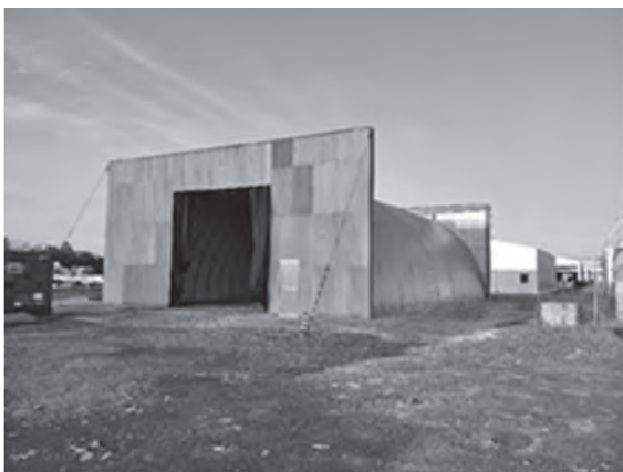
写真一 模擬トンネル全景
