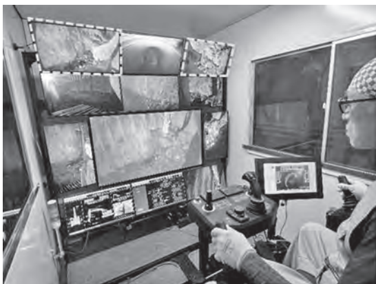
写真—5 遠隔操作によるあたり取り (改良後)
