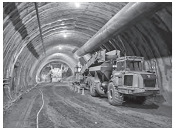
写真一3 切羽の早期開放（支保工作業）
