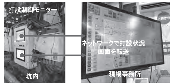
写真-2 打設状況の共有化
