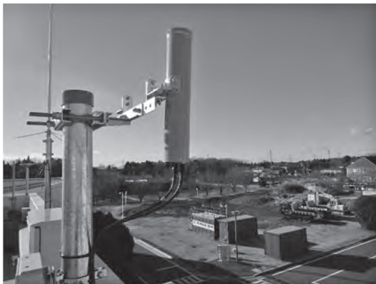
写真一 屋外実験ヤードに指向性を向けた基地局用のアンテナ
