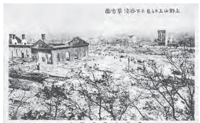
写真—1 関東大震災後の火災被害(上野山から見た浅草方面)
