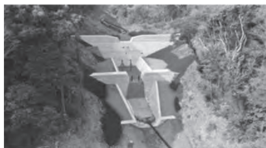
写真—10 新設砂防堰堤（伊豆山砂防堰堤）施工完了
