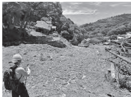
写真-2 被災状況 (施工起点下流)
