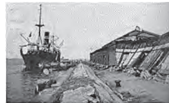
写真一2 横浜港第六岸壁の被害 ※6
