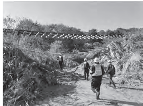
写真—1 目視による被災現場の全体像の把握
