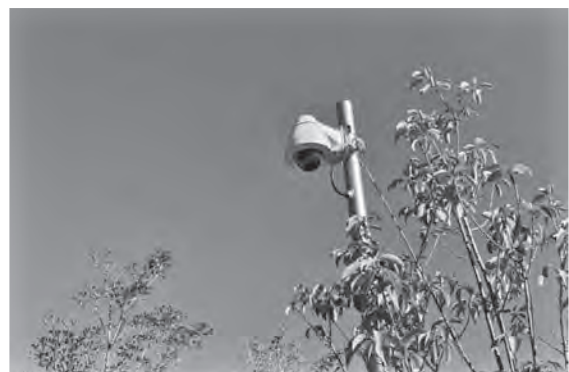
写真一2 ネットワークカメラの設置状況
