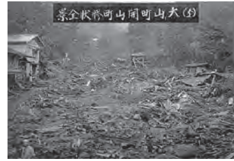
写真一1 伊勢原市大山町開山町の土石流被害 ※4
