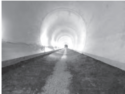
(a) 掘削・床付け
