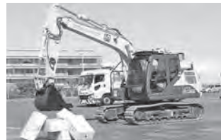
写真-20 遠隔操作によるガレキ移動
