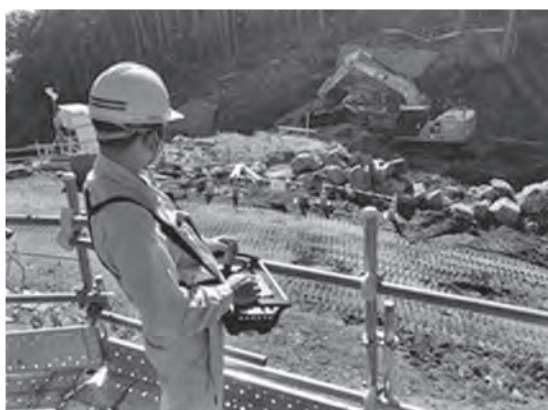
写真一五 遠隔操作バックホウ (0.8m³ 級)
