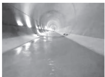
(i) コンクリート打設完了
