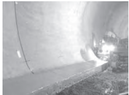
(c) 端部コンクリート打設
