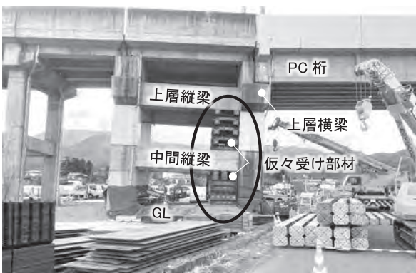
図-5 仮々受け工（沈下防止）設置完了
