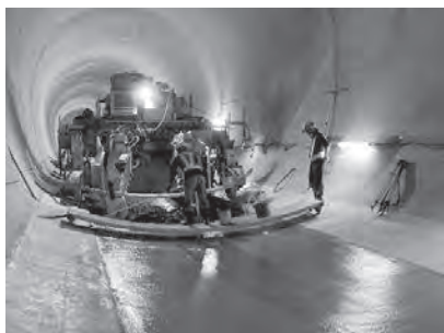
(h) コンクリート表面仕上げ
