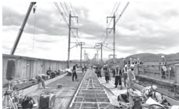
写真—6 路盤コンクリート施工状況
