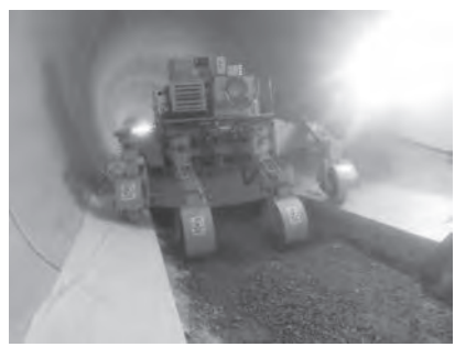
(f) 中央部コンクリート打設
