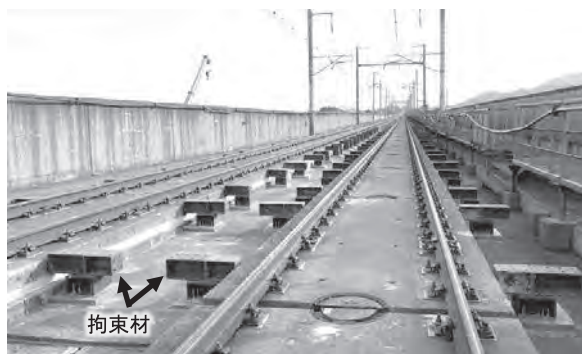
写真—7 仮軌道復旧状況
