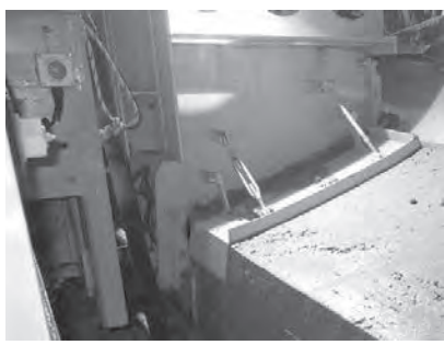
(d) 端部コンクリート打設
