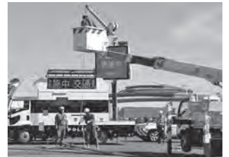
写真-23 倒壊電柱・電線の除去
