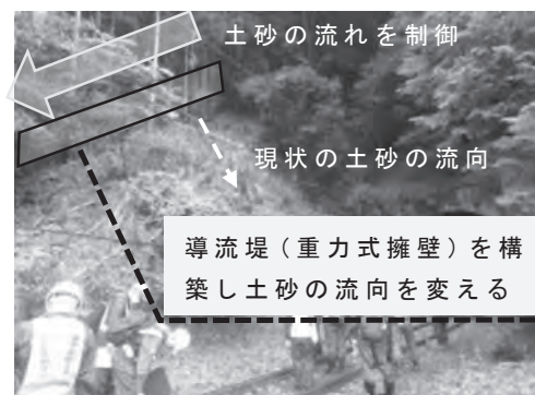
図一七 導流堤の設置
