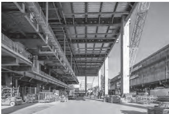
写真-2 低層施工中写真（撮影：2023年7月）
