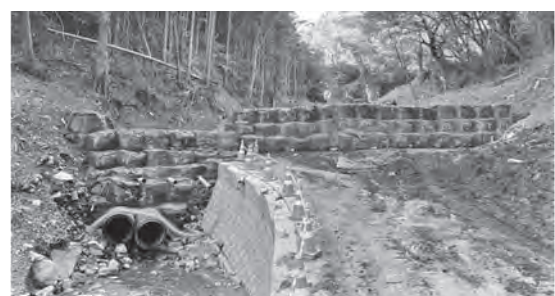
写真一7 仮設堰堤工(ネットロール土のう工)
