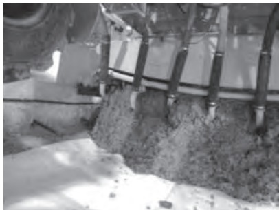
(g) コンクリート打設状況
