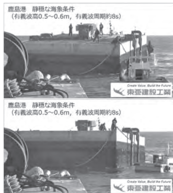
図-1 浮遊ケーソン（2,000 t級）の動揺
