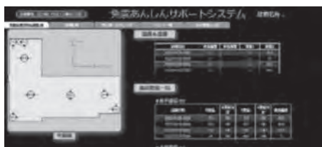
免震装置変形遠隔監視
