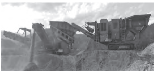
写真二 災害ガレキ破碎再資源作業
