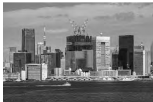
写真—1 外観施工中写真（撮影：2023 年 9 月）
