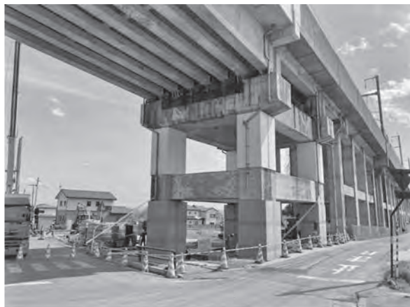
写真—5 鋼板巻き耐震補強完了
