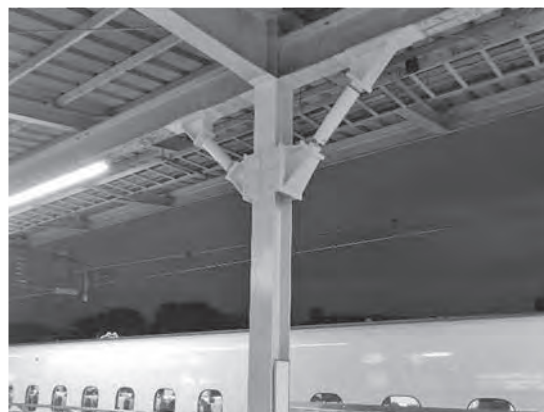
写真-1 補強箇所（柱梁接合部）
