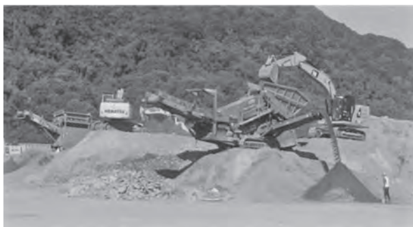
写真一 災害土砂選別及び分別作業
