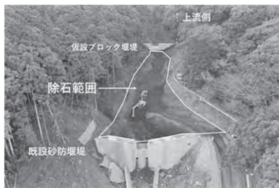
写真—9 既設砂防堰堤除石完了
