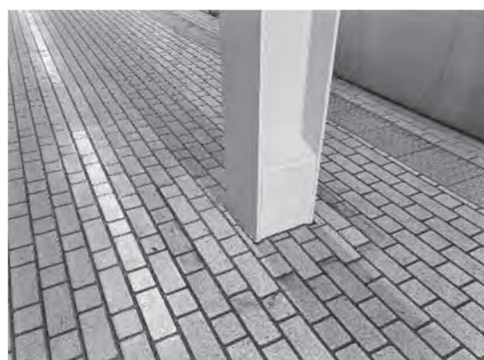
写真-2 補強箇所（柱脚）
