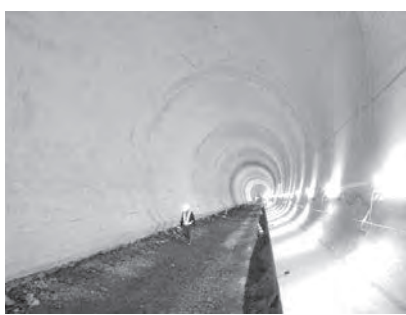
(e) 端部コンクリート打設完了
