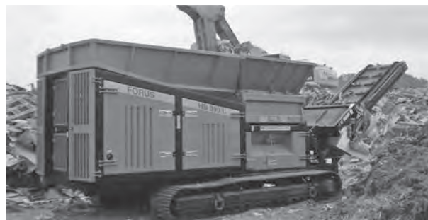
写真四 災害可燃性廃棄物の破碎減容作業
