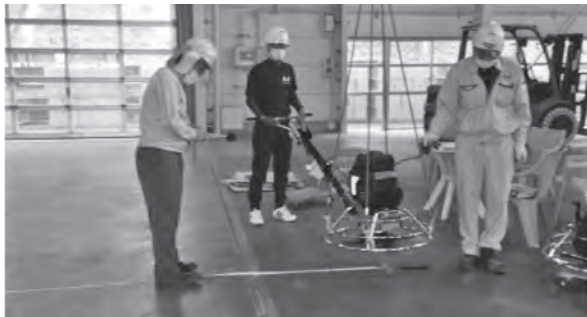
写真—4 電動ハンドトロウエル（モーター） 1 mでの測定で70.7 dB 20 mでの測定で58.5 dB
