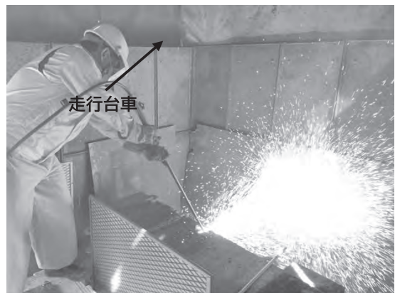
写真—5 ランス棒による切断状況
