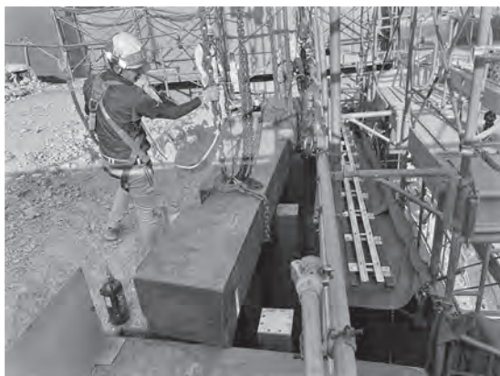
写真—10 スラブ遮蔽鋼板揚重状況
