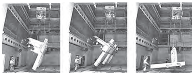
写真一 5 吊荷反転状況
