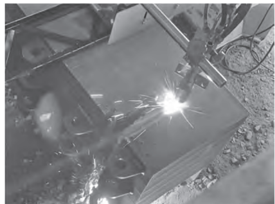
写真—6 本工法による切断状況
