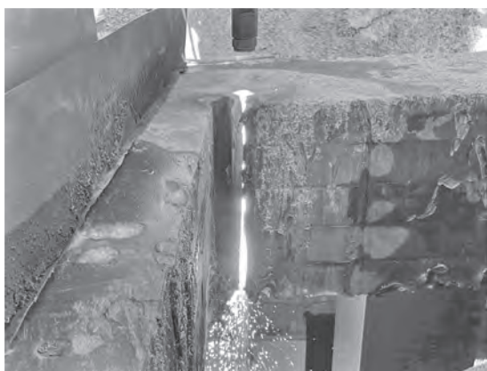
写真—9 スラブ遮蔽鋼板切断状況
