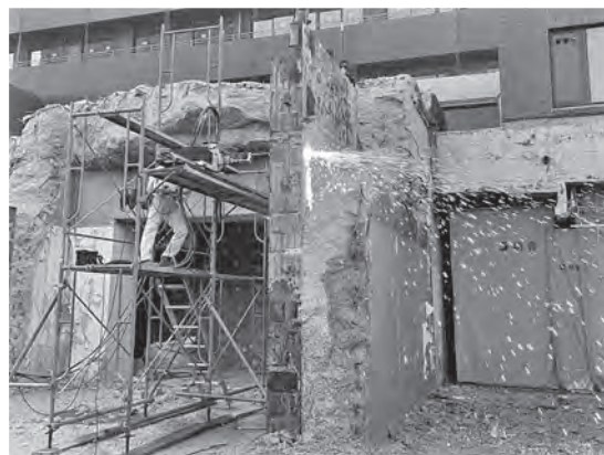
写真—12 壁遮蔽鋼板切断状況
