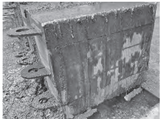
写真—7 本工法で切断した切断面
