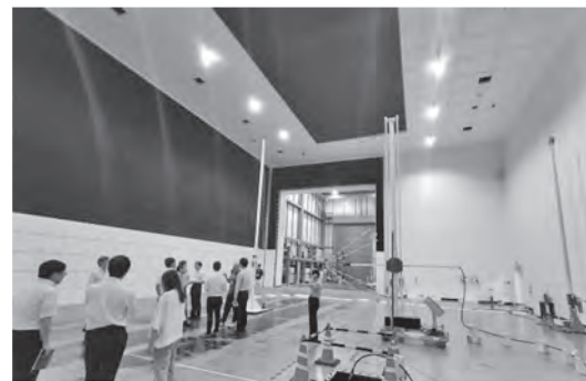
写真一3 大型電波暗室（入口と比べても内部は大きい）
