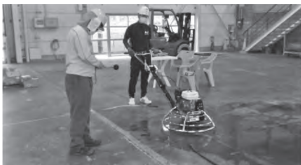
写真—5 通常のハンドトロウエル（エンジン） 1 mでの測定で96.4 dB 20 mでの測定で84.0 dB
