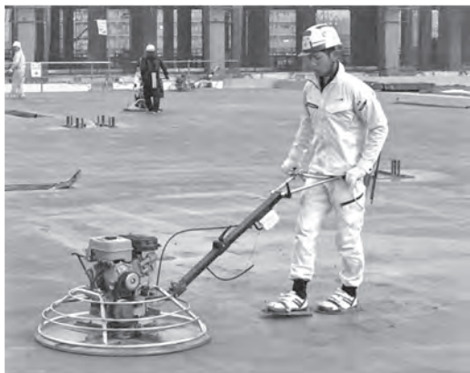
写真—1 従来のエンジン式ハンドトロウエル
