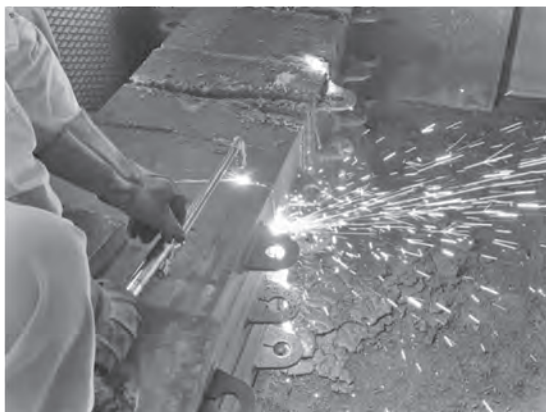
写真—4 手持ちのガス切断器による切断状況
