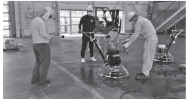
写真—6 電動ハンドトロウエル（モーター） 1 mでの測定で96.8 dB 20 mでの測定で82.0 dB
