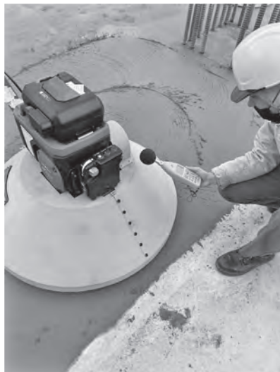
写真一八 発生音の測定状況
