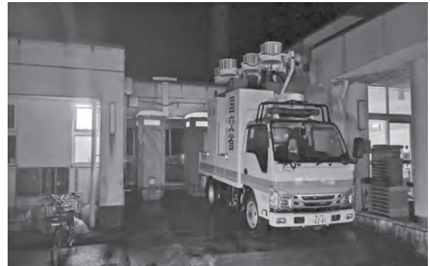
写真—10 旧日本小学校への電源供給
