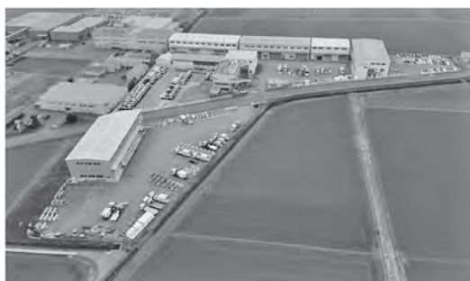
写真—4 工場全景
