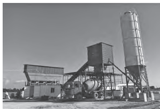
写真－1 現場生コン工場の例（ミャンマーの例）
