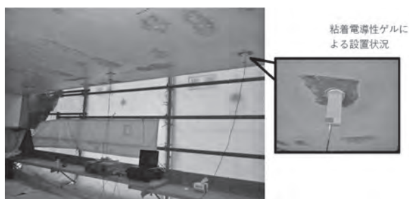
写真—2 鉄道高架橋補修工事での測定状況
