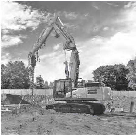
写真—2 日立建機 RX3300-7 リーダレス型基礎機械
