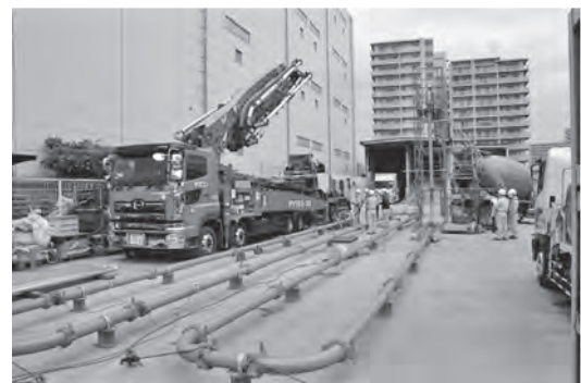
写真一 1 圧送試験配管組立状況
