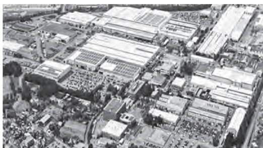
写真—1 工場全景
