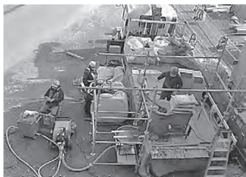
写真一 プラント全景
