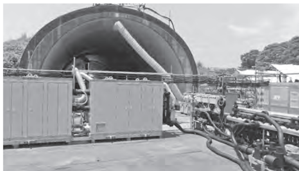
写真—2 実験全景（冷凍機（左手前）と模擬トンネル（奥））
