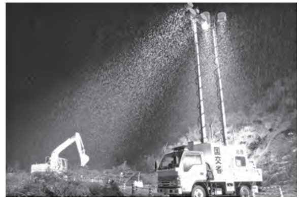
写真—1 孤立地域の解消に向け24時間体制で進められている道路啓開（石川県輪島市）
