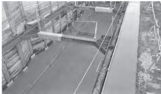
写真—5 仕上り状況（事例2）
