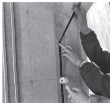
写真一1 テープ式陽極材の設置状況
