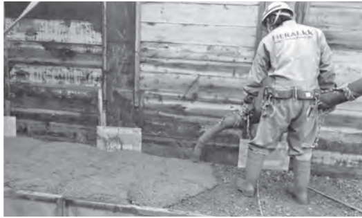
写真—4 コンクリート打込み状況（事例2）
