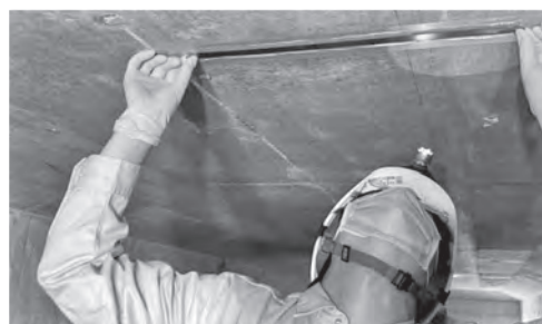
写真ー5 ディストリビュータ貼り付け状況
