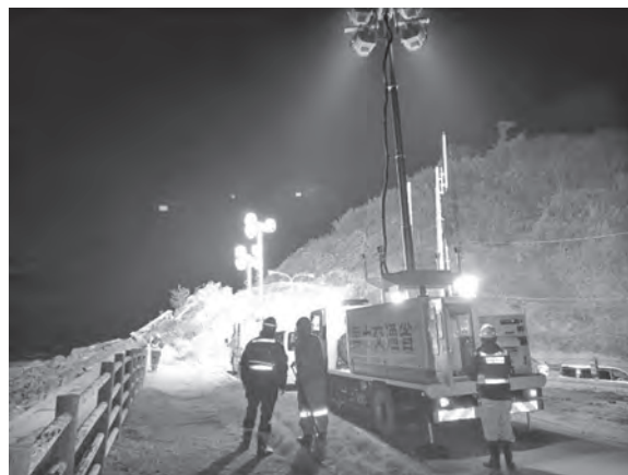
写真—14 道路啓開の夜間作業支援（関東・中部）
