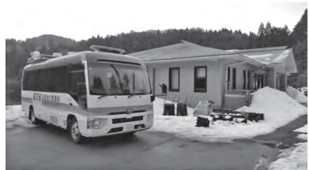
写真—8 地原浄水場（珠洲市）
