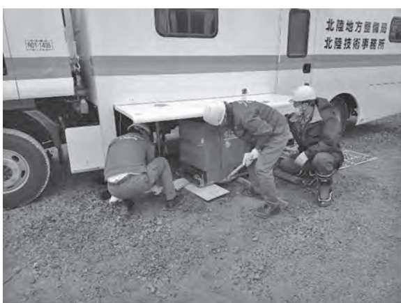
写真—17 災害対策車両の現地整備（（一社）日本建設機械施工協会（北陸支部））
