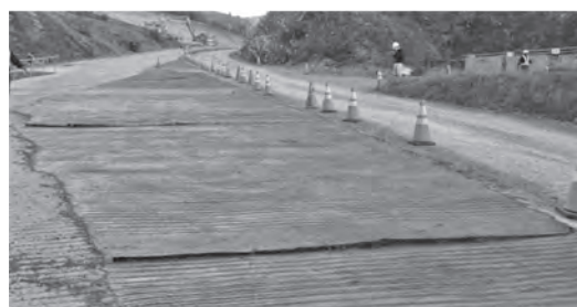
写真—3 仕上り状況（事例1）
