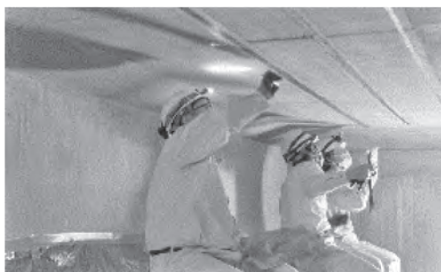
写真—6 テープ式陽極材貼り付け
