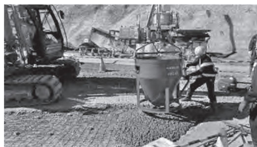
写真—2 コンクリート打込み状況（事例1）
