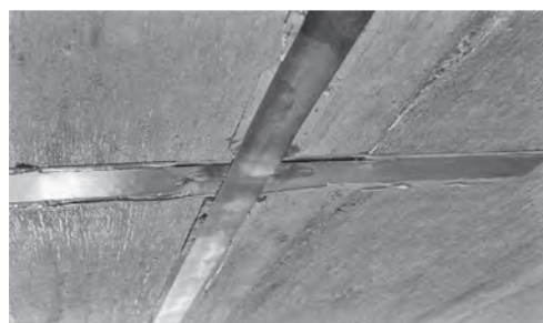
写真—8 テープ式陽極材とディストリビュータ溶接
