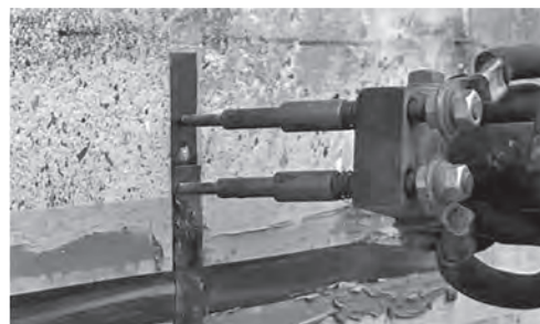
写真—7 専用溶接機端子部
