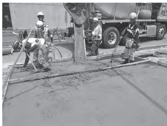
写真-7 本工法の打込み
