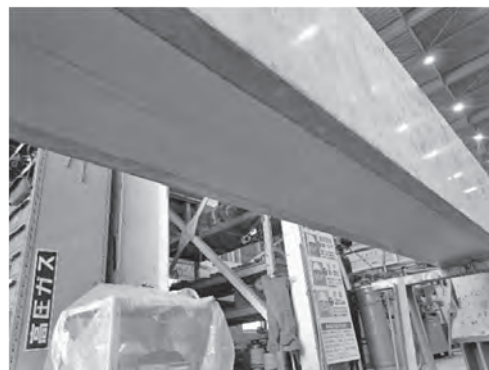
写真一2 試験体下面の状況
