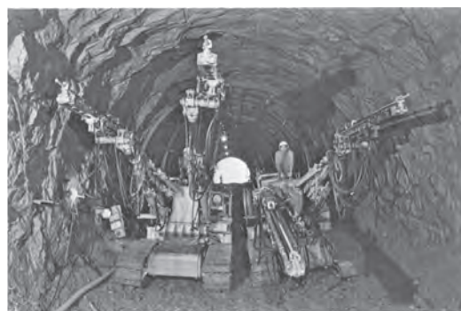
写真-7 大清水トンネル斜坑工事現場のトンネルエース
