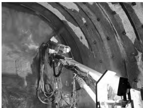
写真—3 支保工背面部への吹付け
