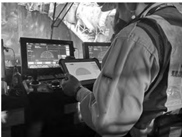
写真—4 発破パターン共有状況
