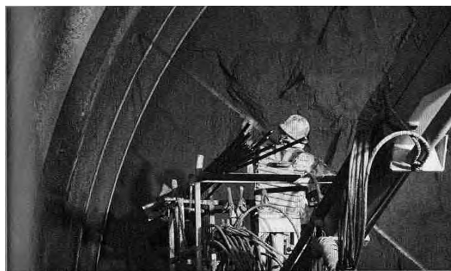
写真-1 モルタル注入する作業員 1)
