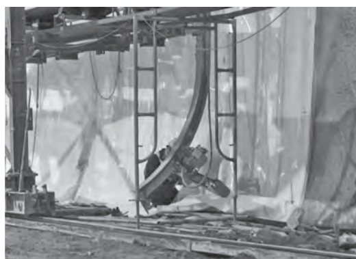
写真—4 防水シートのセット状況
