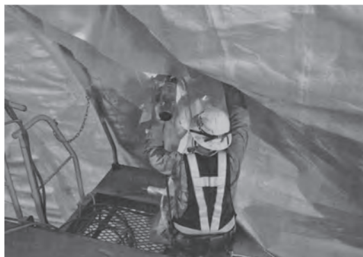
写真—1 一般的なシートの溶着作業状況
