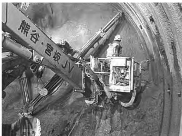
写真—1 人力によるロックボルト打設作業（注水拡張）
