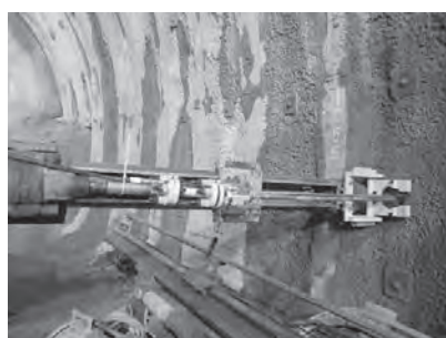
(g) ボルト挿入・座金設置状況
