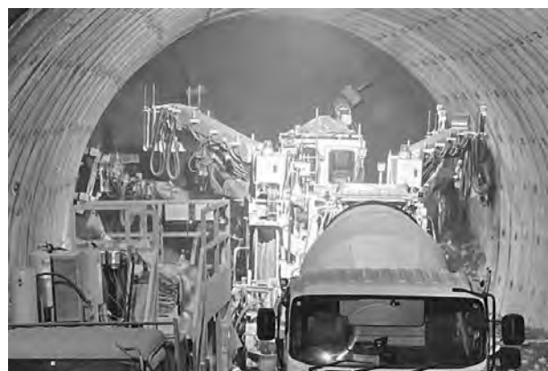
写真—4 2ノズル吹付機の自動化
