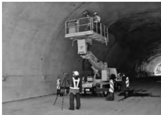
写真—5 地中レーダにより覆工巻厚および背面空洞を計測する技術の例
