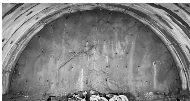
写真一 3 システムの適用状況（装薬完了）
