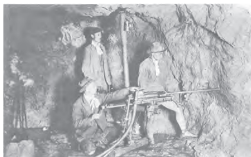
写真—4 岩盤上下面に突っ張り固定したスタンドに搭載されたドリフタ（足尾銅山）
