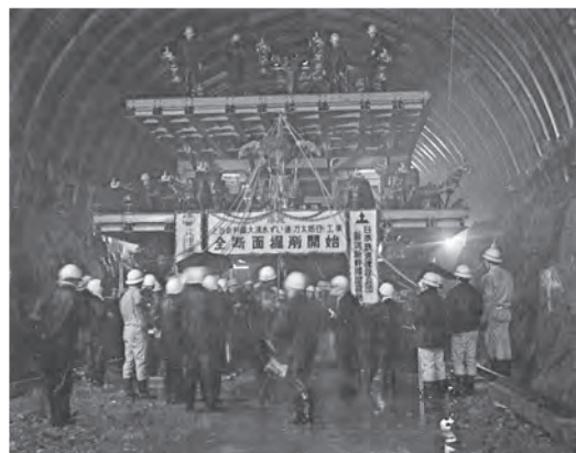
写真-8 大清水トンネル19ブームガントリージャンボ(万太郎谷工区)
