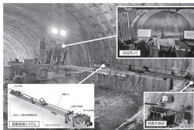
写真—3 無人の切羽にて試験施工の様子
