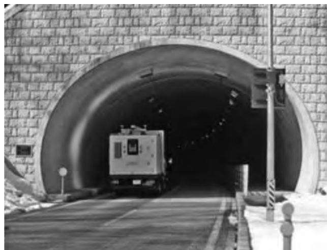
写真—4 覆工の形状計測を行う技術の例
