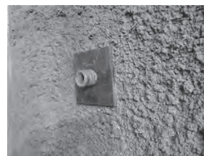
(i) 打設完了
