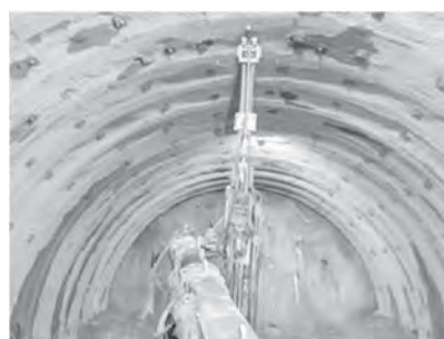
(f) ボルト挿入状況
