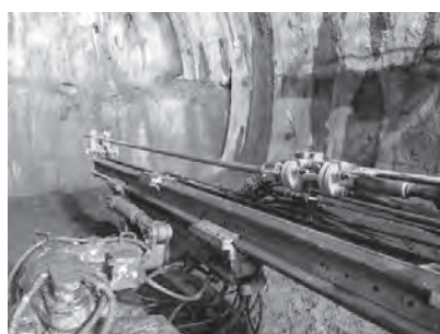
(a) ボルト・座金セット状況
