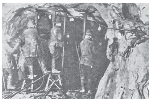
写真—5 清水トンネル導坑工事で使用されるドリフタ（土合口坑門）
