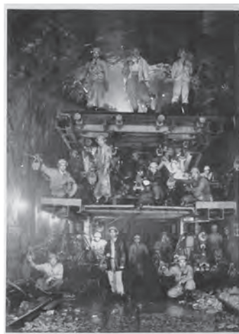
写真—6 新清水トンネル 11 ブームガントリージャンボ（湯檜曾工区）
