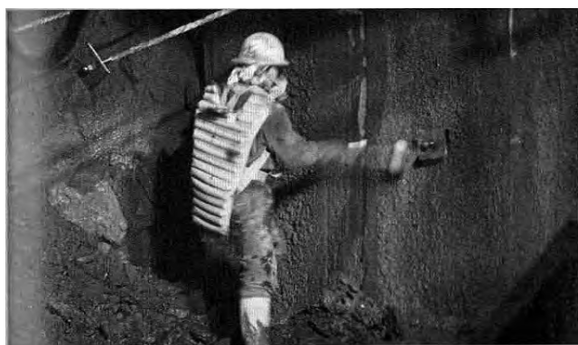
写真—2 ロックボルト打設 1)
