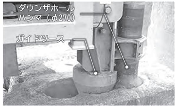
写真-1 スロット孔の連続穿孔状況
