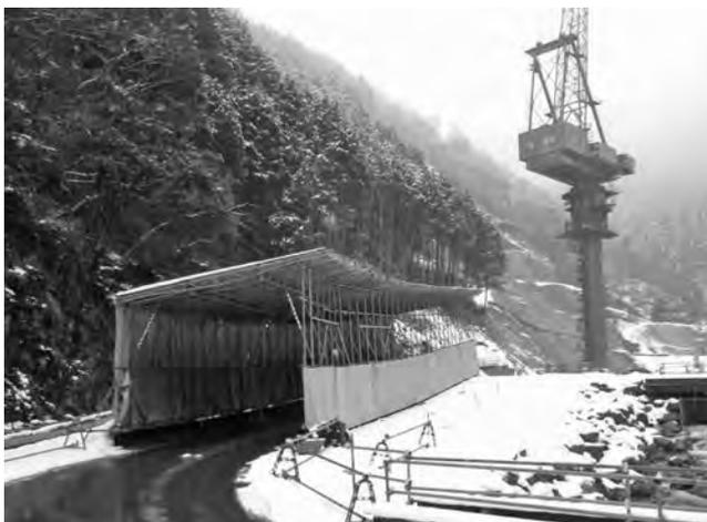
写真一七 バンカー線の防音シートによる養生
