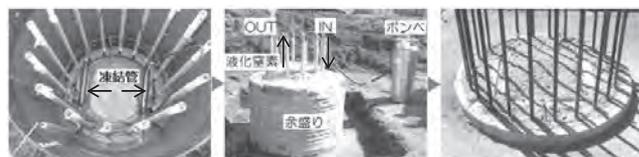
図一2 本工法の施工手順
