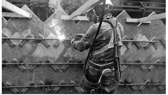
写真一7 定規用鉄筋の設置
