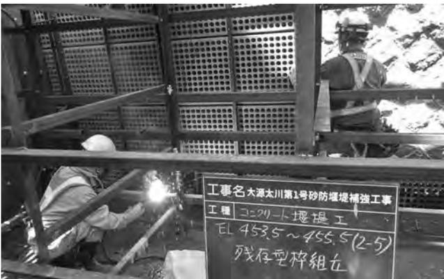
写真一4 残存型枠設置状況
