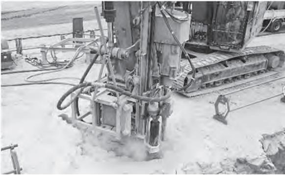
写真一三 スロット孔の連続穿孔状況
