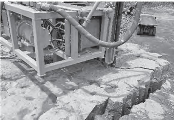
写真一五 バッカー割岩状況
