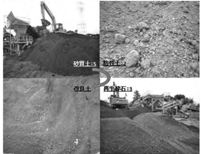
写真一一 原土 (砂質土, 粘性土, 再生碎石) と改良土
