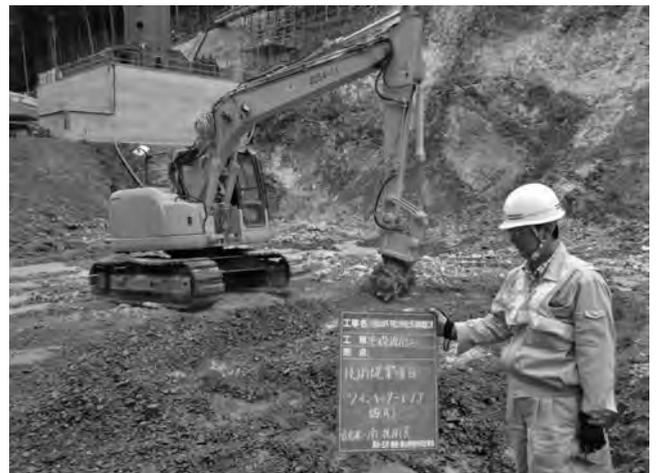
写真一八 ツインヘッダーによる施工状況
