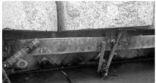
写真一10 天端端石のアンカー固定状況
