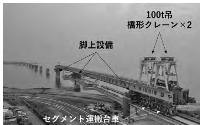
写真—13 セグメント吊上げ状況
