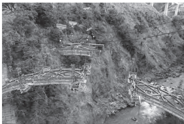
写真—8 下弦材架設状況(閉合)
