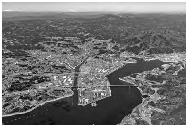
写真—1 気仙沼湾横断橋の全景
