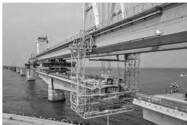
写真—14 セグメント架設状況
