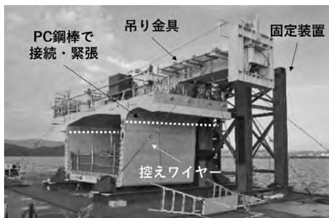
写真—17 台船上セグメント固縛状況
