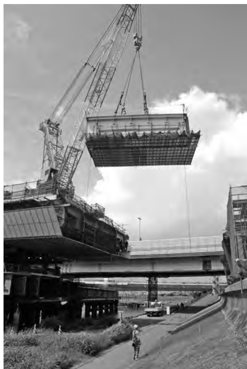
写真—3 トラベラークレーン架設
