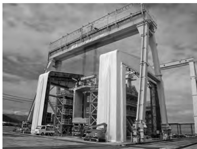
写真—4 100t吊橋形クレーン
