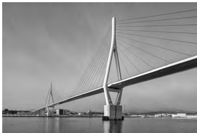
写真—2 斜張橋の全景
