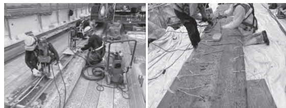
(a) 装薬孔削孔
