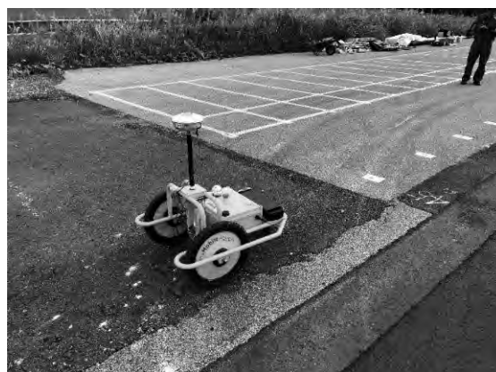
写真―2 確認実証状況 (GNSS 受信機)
