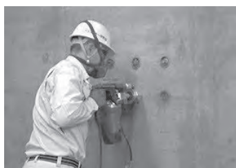
写真—1 ブラストキー施工例
