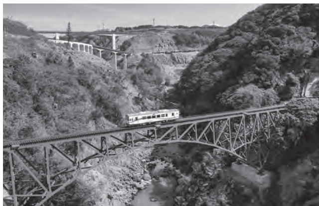
写真—9 全線開通後の第一白川橋梁
