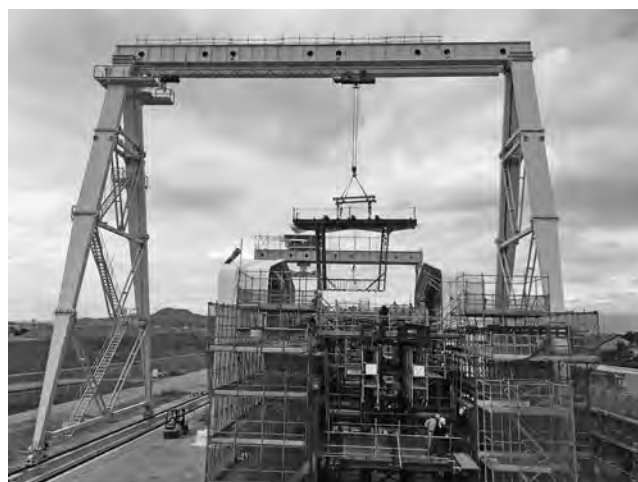
写真—5 15t吊橋形クレーン
