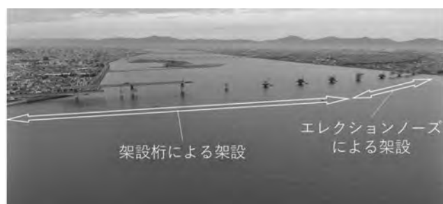
写真—11 セグメント架設
