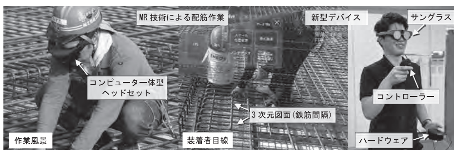
写真—2 MR 技術を用いた配筋作業と新型デバイス
