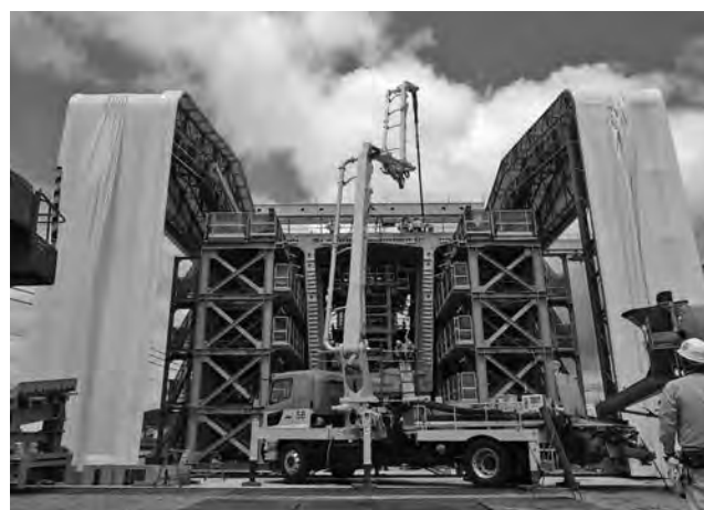
写真—9 セグメント製作台, 上屋設備
