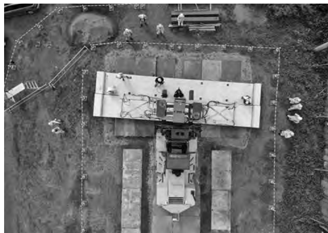
写真一6 模擬床版中心角度1.5°回転した条件での床版設置実験状況
