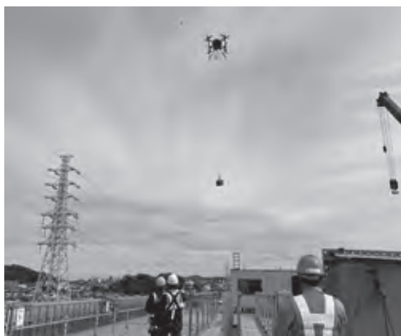
写真—3 ホイス機構による荷下ろし
