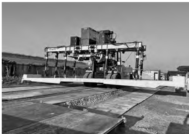
写真一4 フォークリフトに装備した本装置による模擬床版運搬状況
