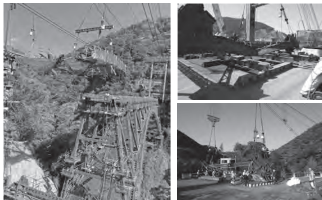
写真—5 撤去状況
