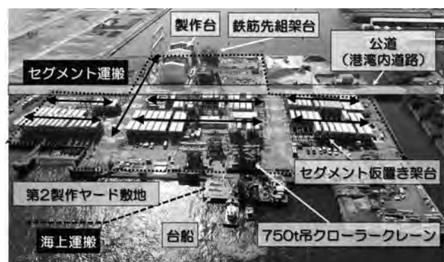
写真—3 第2製作ヤード
