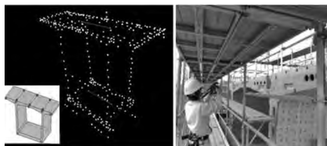
写真—10 デジタルカメラによる計測状況
