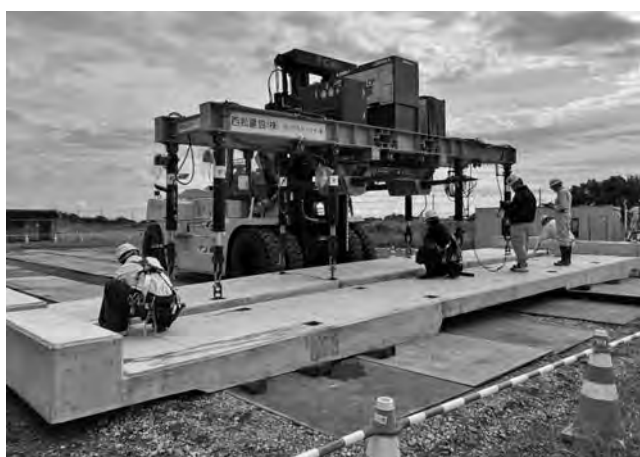
写真一5 橋軸直角条件の床版設置実験状況
