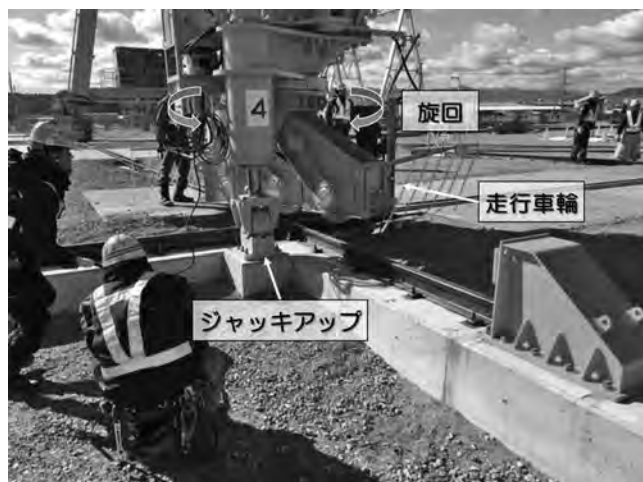
写真—7 走行車輪旋回状況
