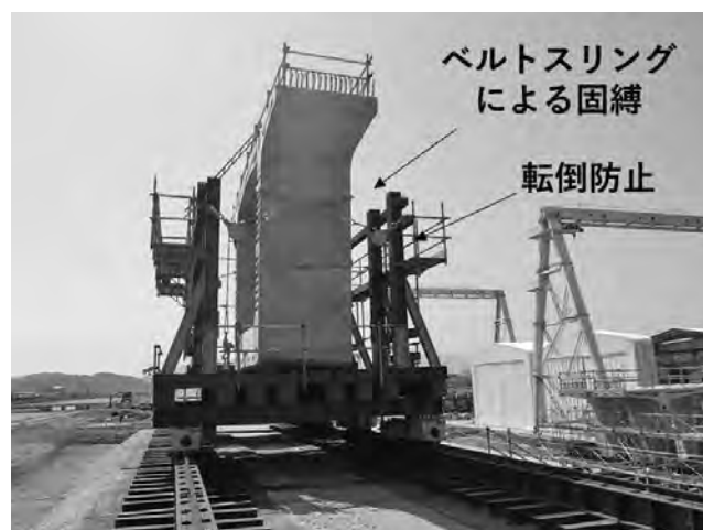
写真—15 セグメント運搬台車
