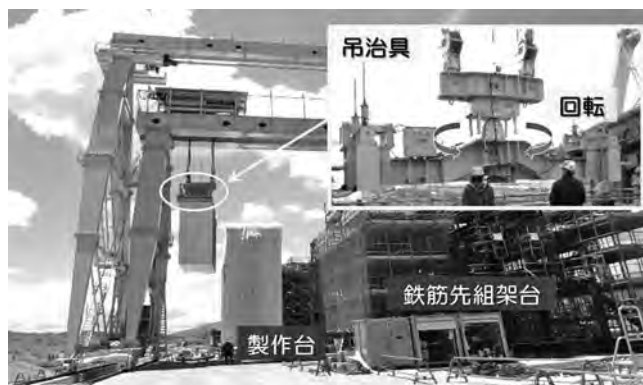
写真—6 セグメント運搬状況
