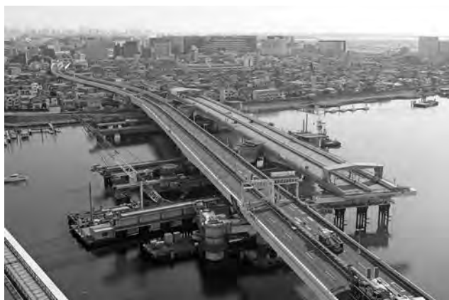
写真—4 集中工事直前の高速大師橋
