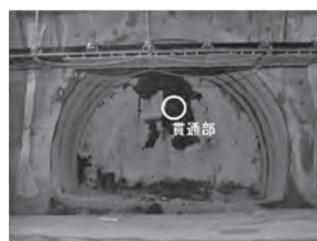
図—2 貫通時切羽状況
