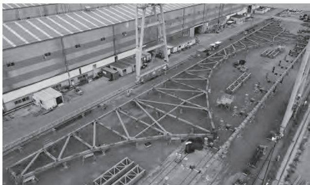
写真—6 部分面組仮組立
