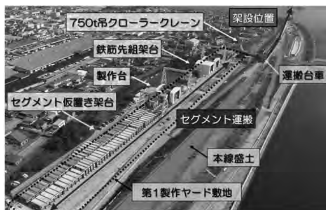
写真—2 第1製作ヤード
