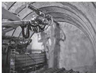
写真—2 「連結機構付きガイドシエル」による打設状況
