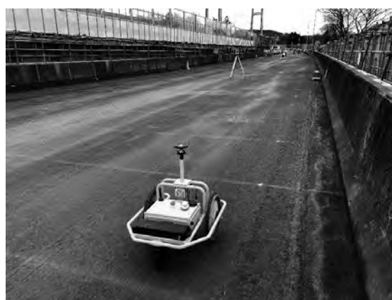
写真―3 マーキング状況 (自動追尾型トータルステーション)
