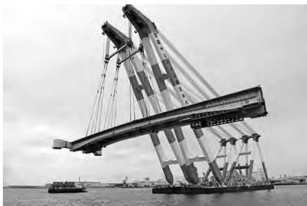
写真—1 大ブロック浜出し
