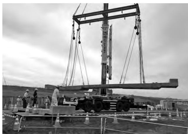
写真一7 クレーンを使用した床版設置実験
