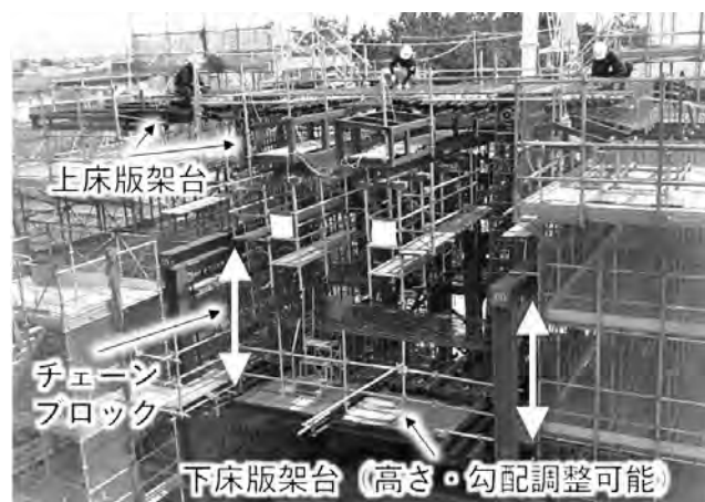
写真—8 鉄筋先組架台
